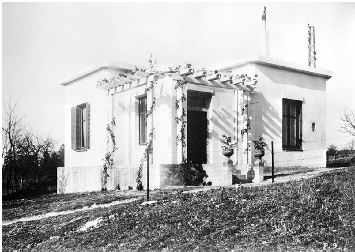
Vue de trois quarts après l'ajout de la 4e pièce.
