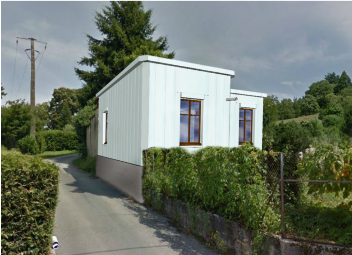
Restitution de la maison d'origine, intégrée au paysage actuel (dessin des élévations sud et ouest). 39, Saint-Amour, 23 rue d' Allonal
