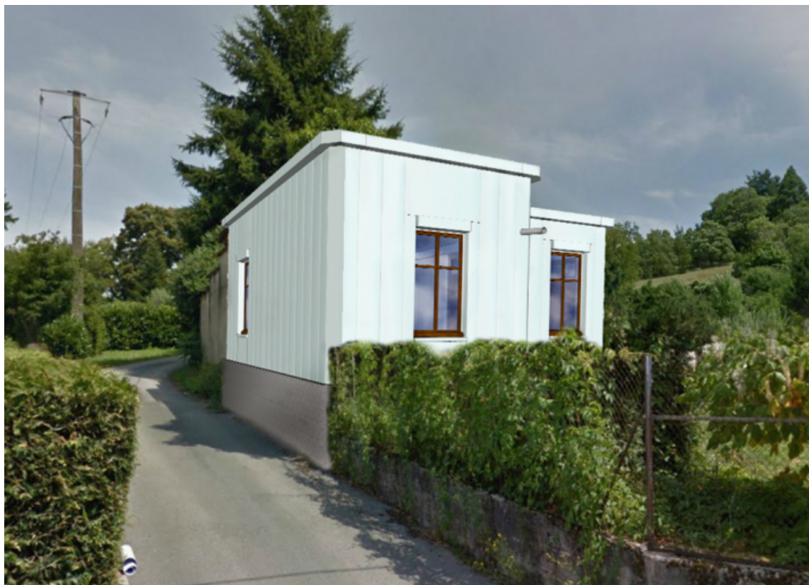
Restitution de la maison d'origine, intégrée au paysage actuel (dessin des élévations sud et ouest). 39, Saint-Amour, 23 rue d' Allonal
