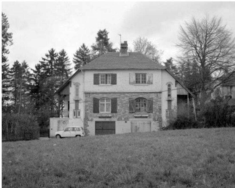
Maison (B) : façade antérieure.
