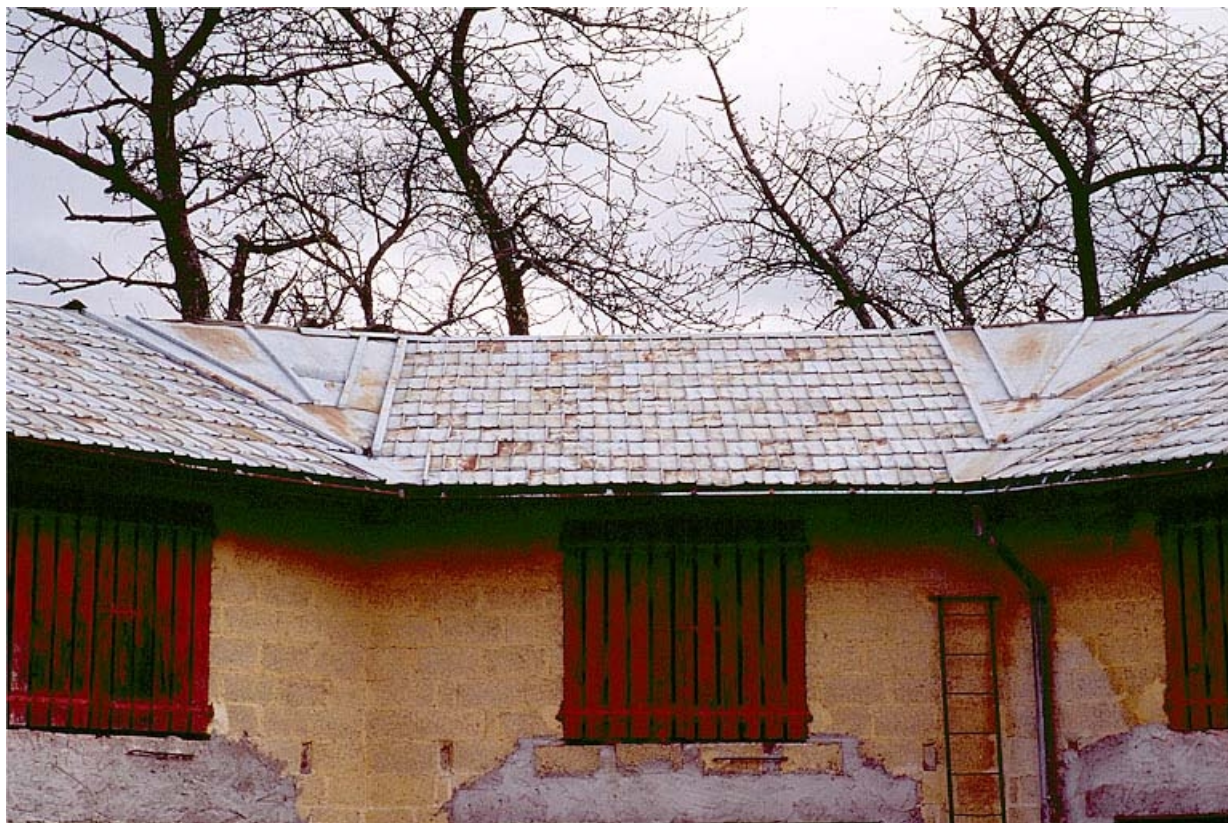
Remise d'automobile et bûcher (F) : toiture couverte de tuiles métalliques.
