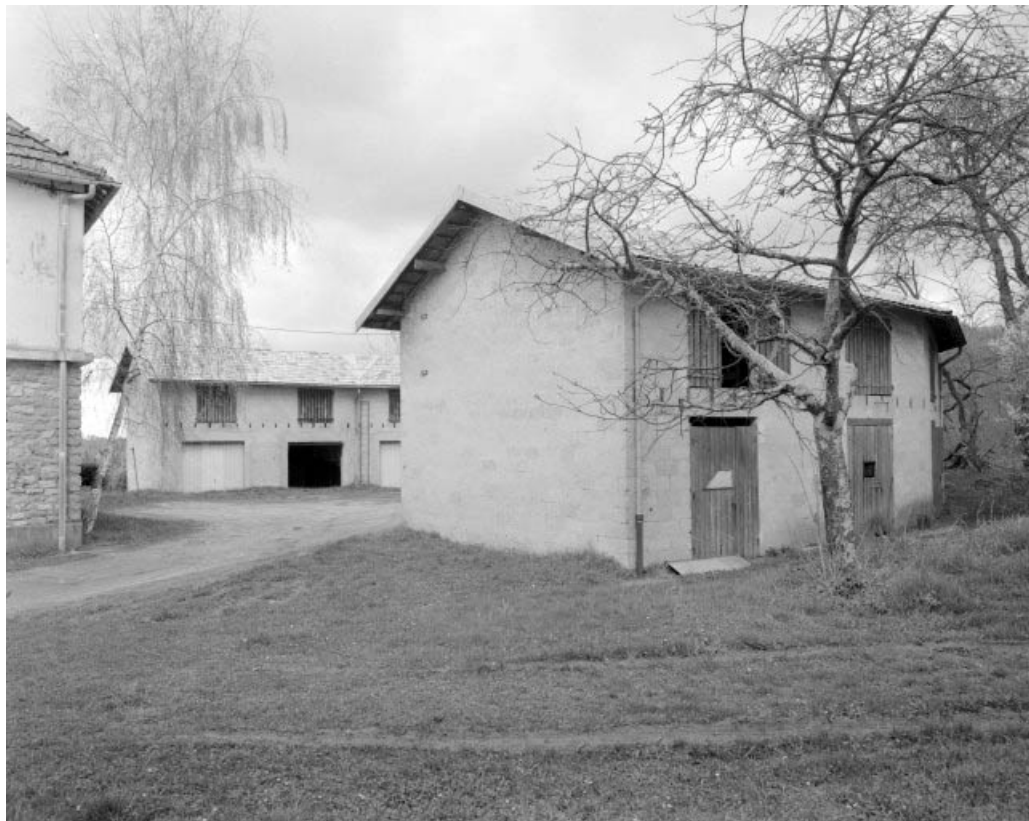
Remise d'automobile et bûcher (F) : vue d'ensemble.
