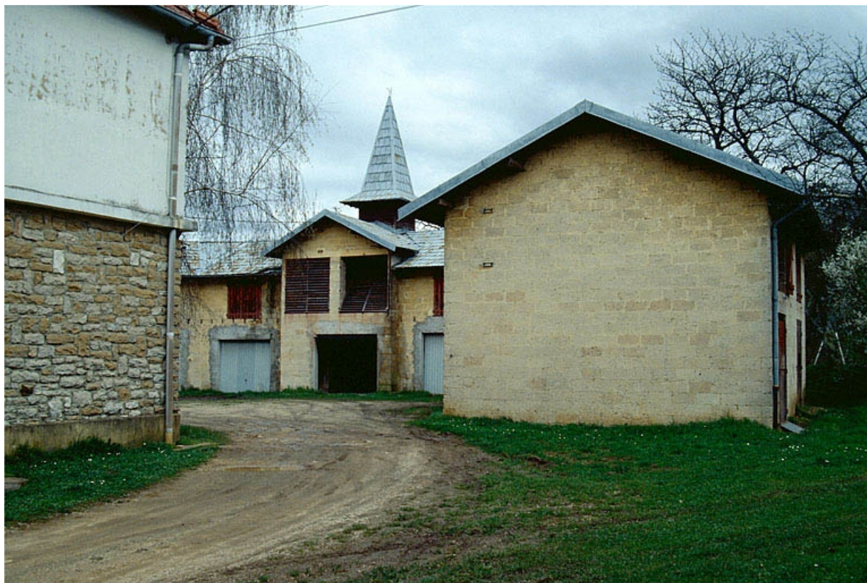
Remise d'automobile et bûcher (F) : entrée. 39, Saint-Amour rue des Enversys
