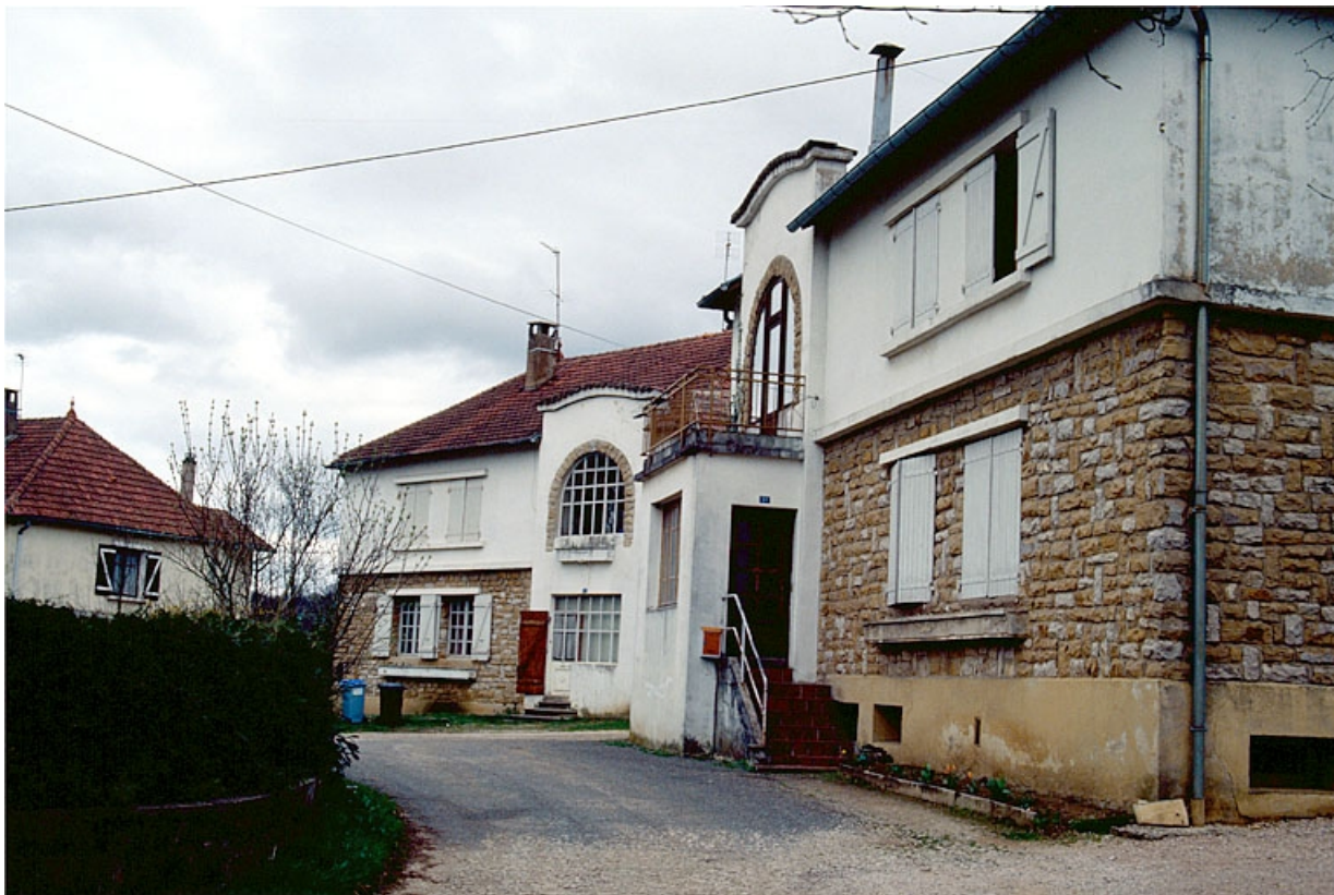
Maisons (G, H) : vue d'ensemble.
