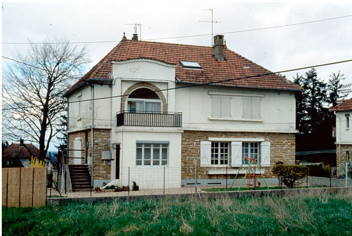
Maison (H) : façade postérieure.
