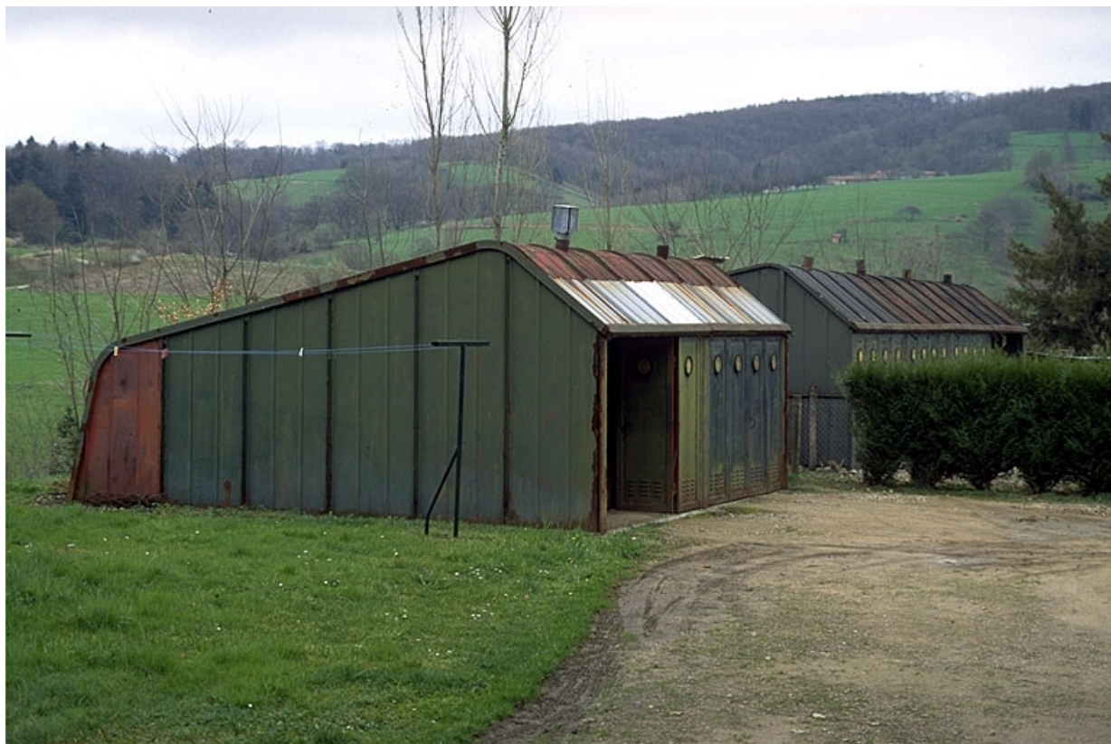
Remises d'automobile métallique : vue d'ensemble.
