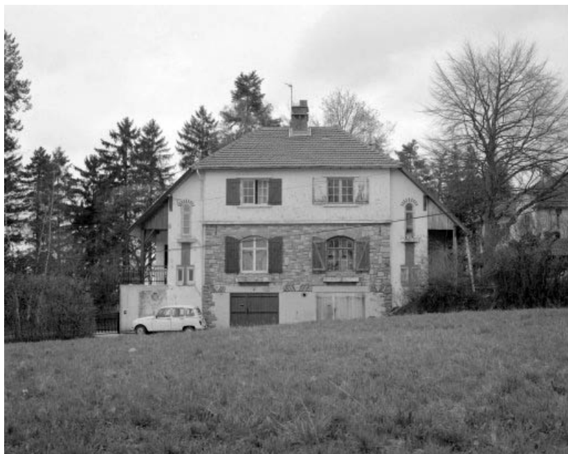
Maison (B) : façade antérieure.
