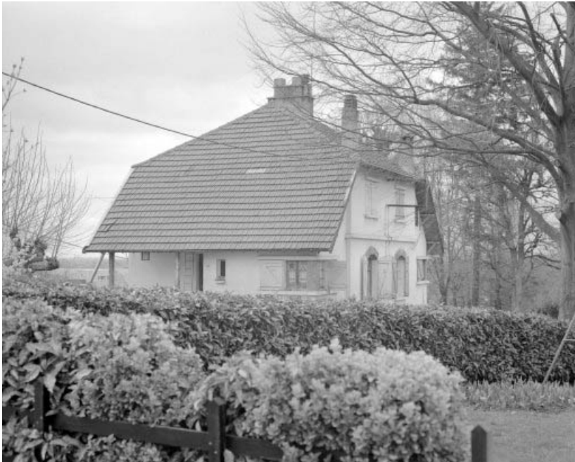
Maison (B) : façades postérieure et latérale droite.
