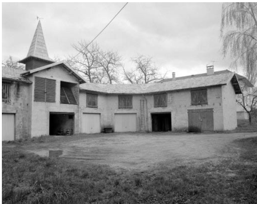
Remise d'automobile et bûcher (F) : cour.
