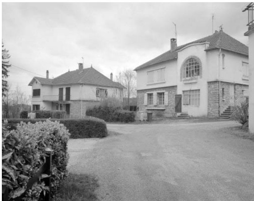
Maisons (G, D) : vue d'ensemble.
