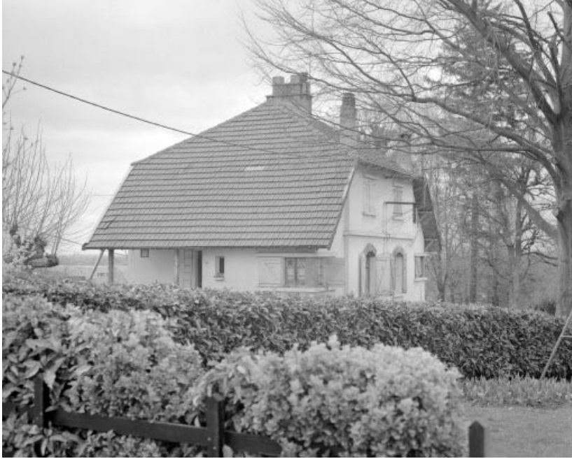
Maison (B) : façades postérieure et latérale droite.
