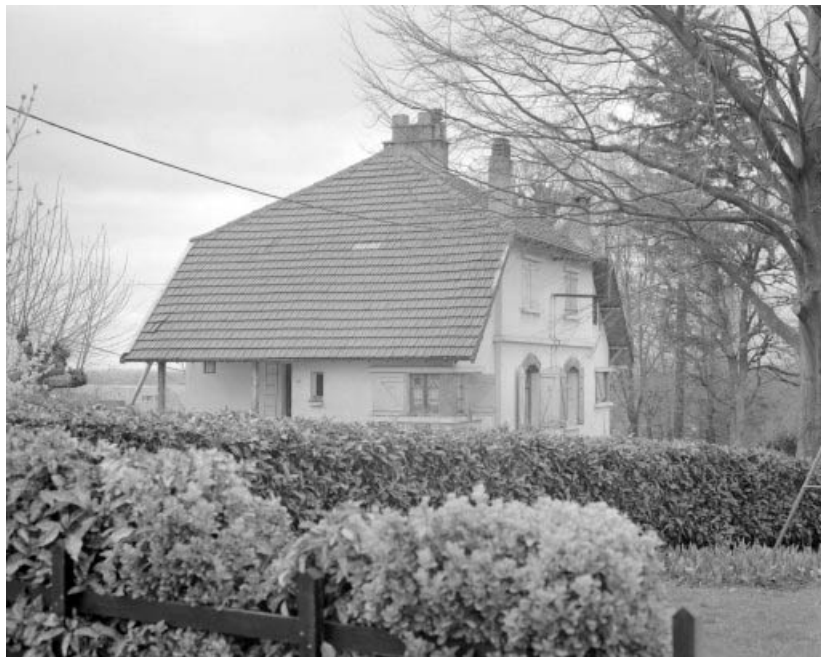
Maison (B) : façades postérieure et latérale droite.
