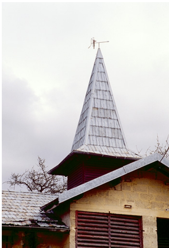
Remise d'automobile et bûcher (F) : flèche couverte de tuiles métalliques. 39, Saint-Amour rue des Enversys
