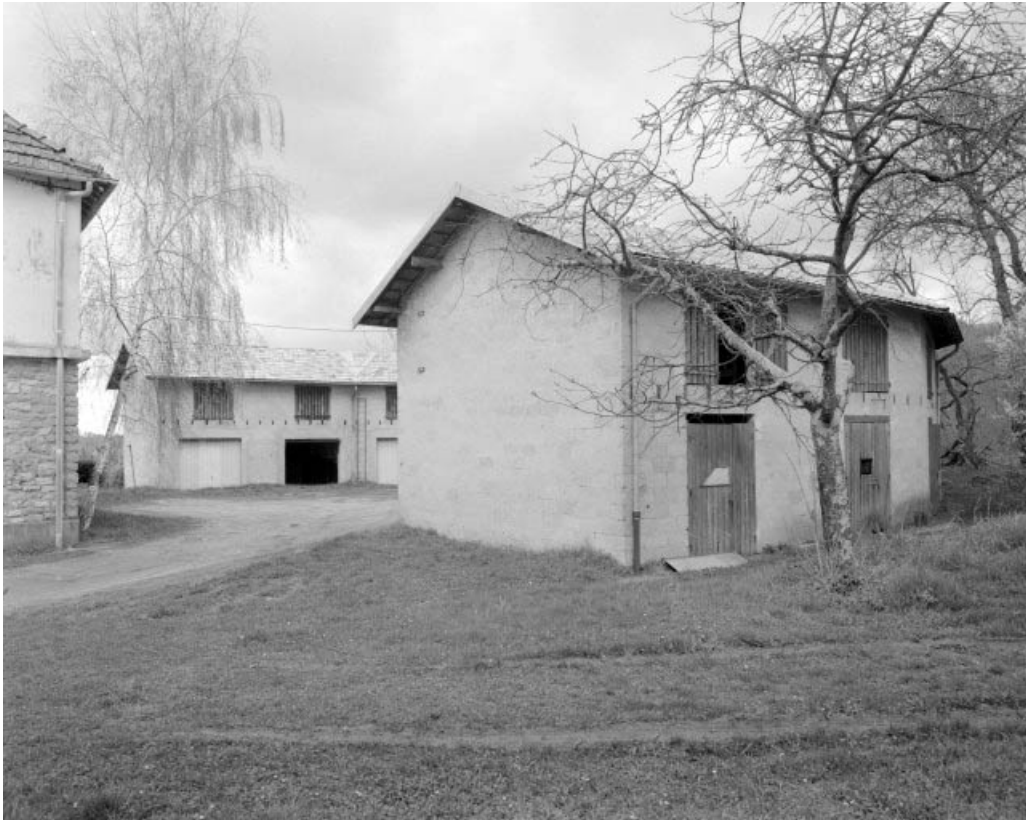
Remise d'automobile et bûcher (F) : vue d'ensemble.
