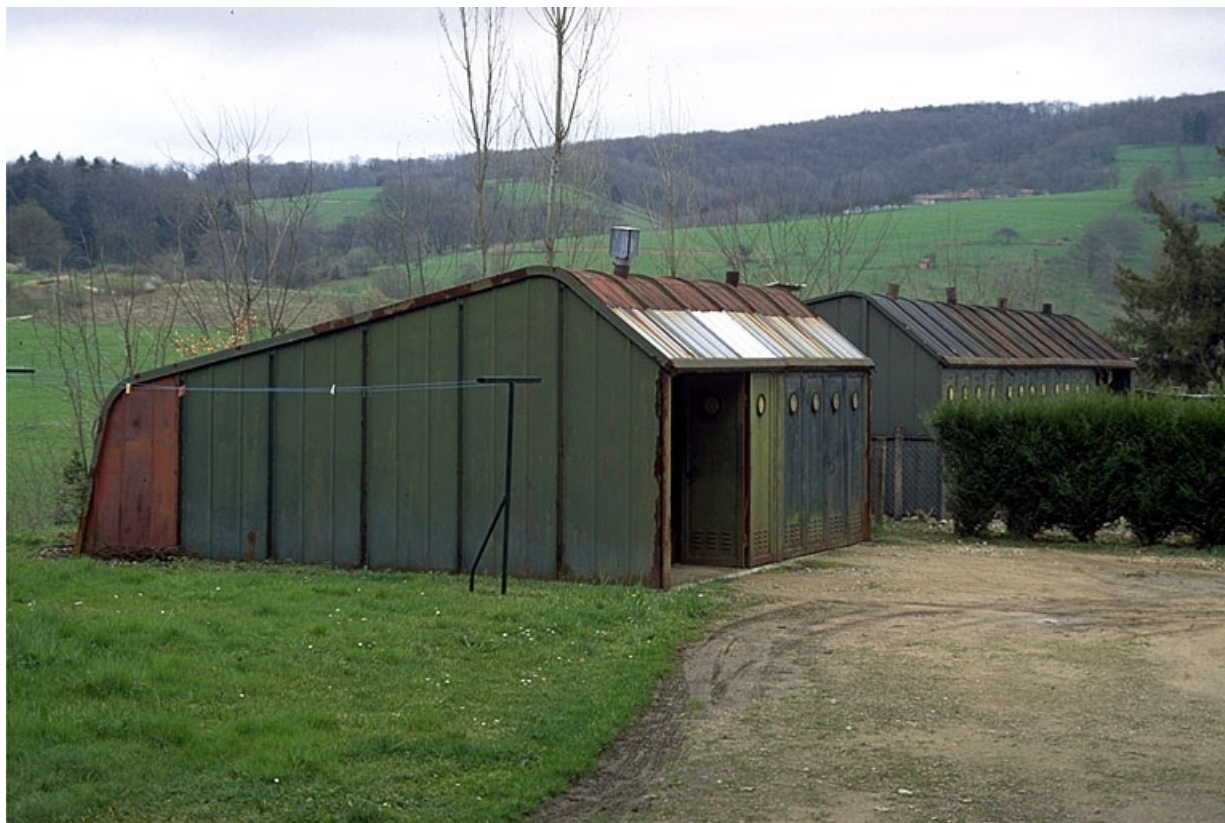
Remises d'automobile métallique : vue d'ensemble.
