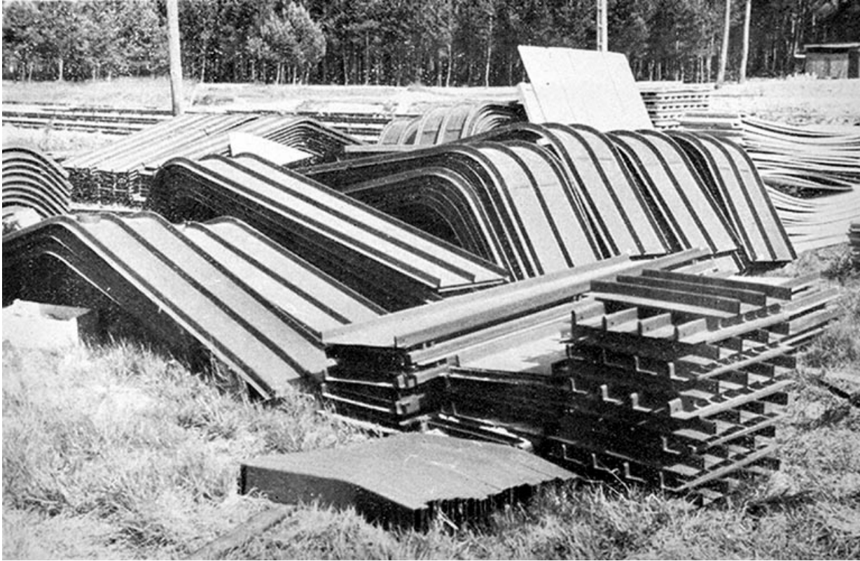
Montage d'un baraquement métallique dans les années 1940 : stockage des tôles.
