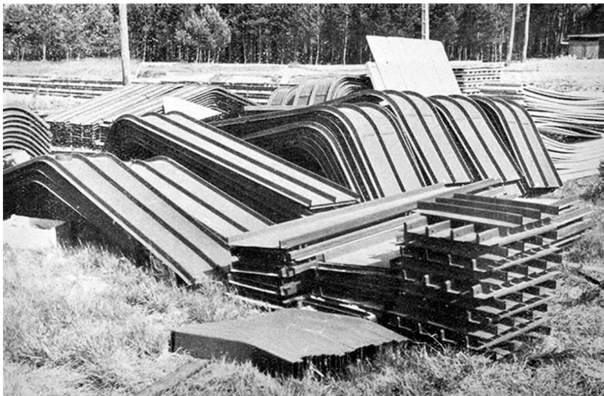
Montage d'un baraquement métallique dans les années 1940 : stockage des tôles.
