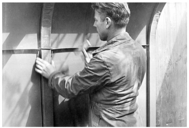
Montage d'un baraquement métallique : pose d'une agrafe.
