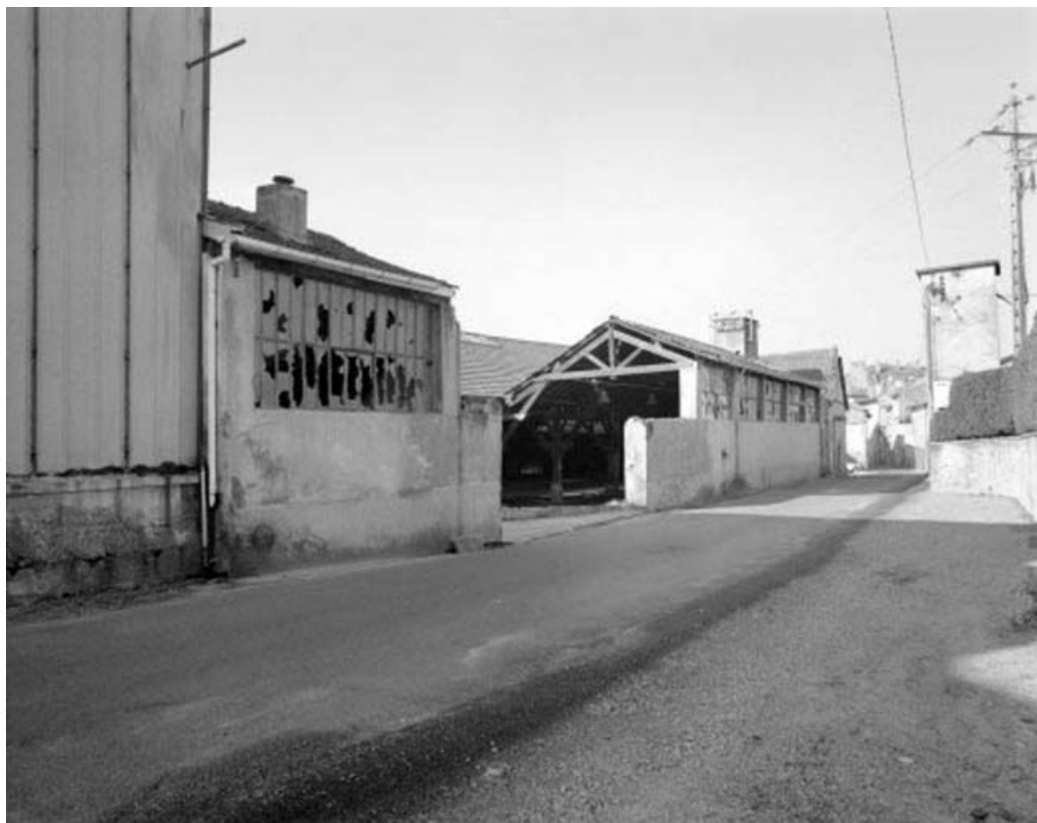
Façades sur la rue d'Allonal et entrée des ateliers (J).
