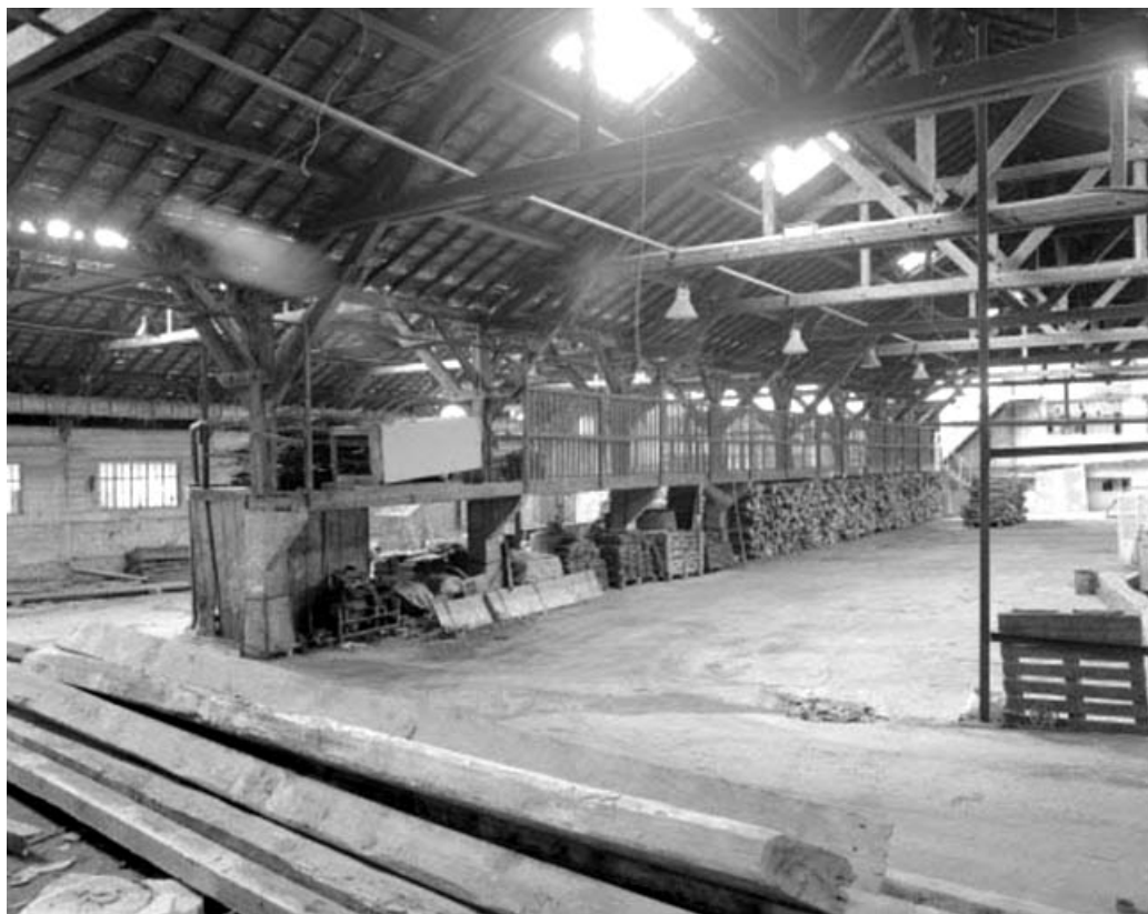
Ateliers de fabrication (J) : intérieur du parc à tôles (J2). Rampe d'accès au premier plan, quai d'expédition dans le vaisseau (J1) à gauche.
