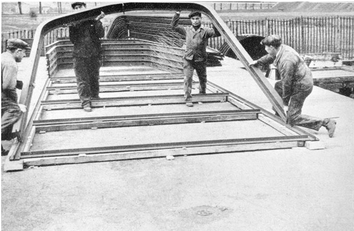
Montage d'un baraquement métallique dans les années 1940 : montage de l'armature.
