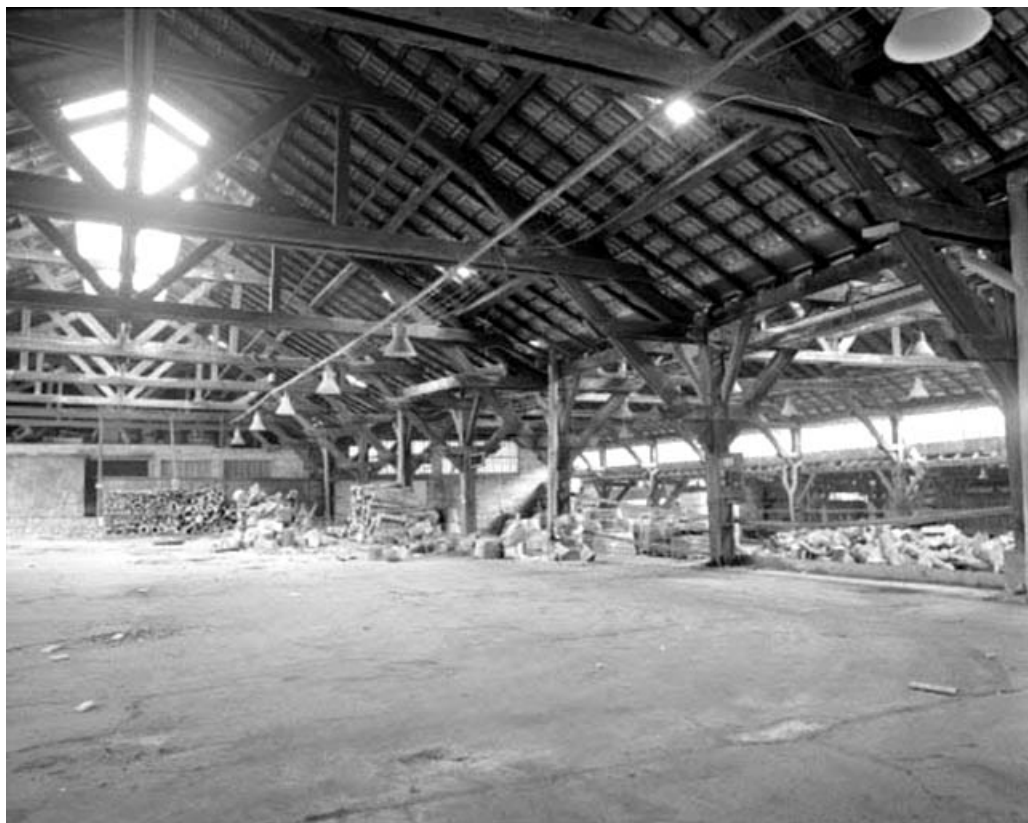
Ateliers de fabrication (J) : intérieur de l'atelier de soudure (J4). Rampe d'accès au fond, atelier des presses dans le vaisseau (J3) à droite.
