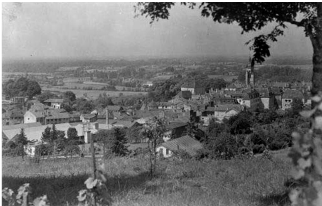
Vue d'ensemble de l'usine depuis le nord-est.
