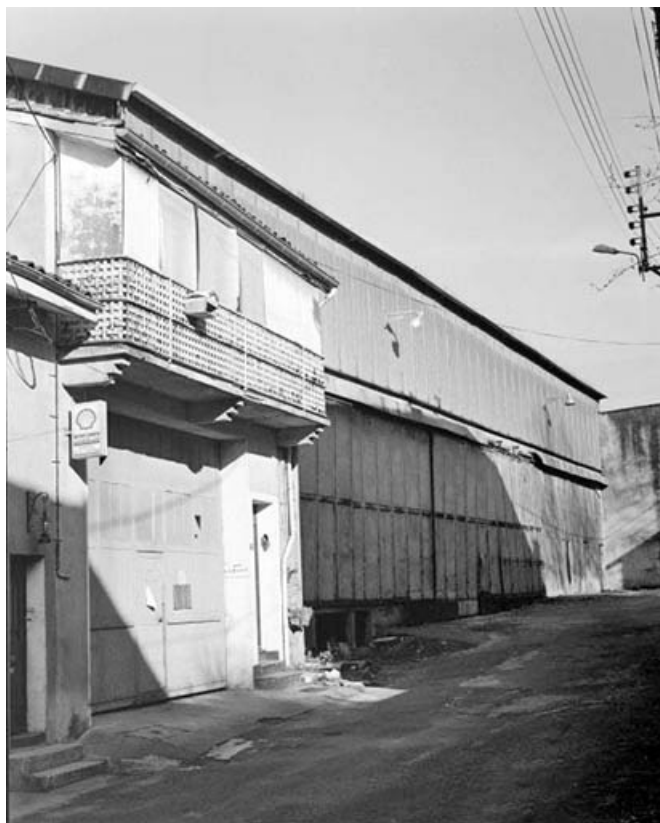
Façades sur la rue du Soujet : logette du garage (I) et atelier de fabrication (L). 39, Saint-Amour, 25 rue Lamartine
