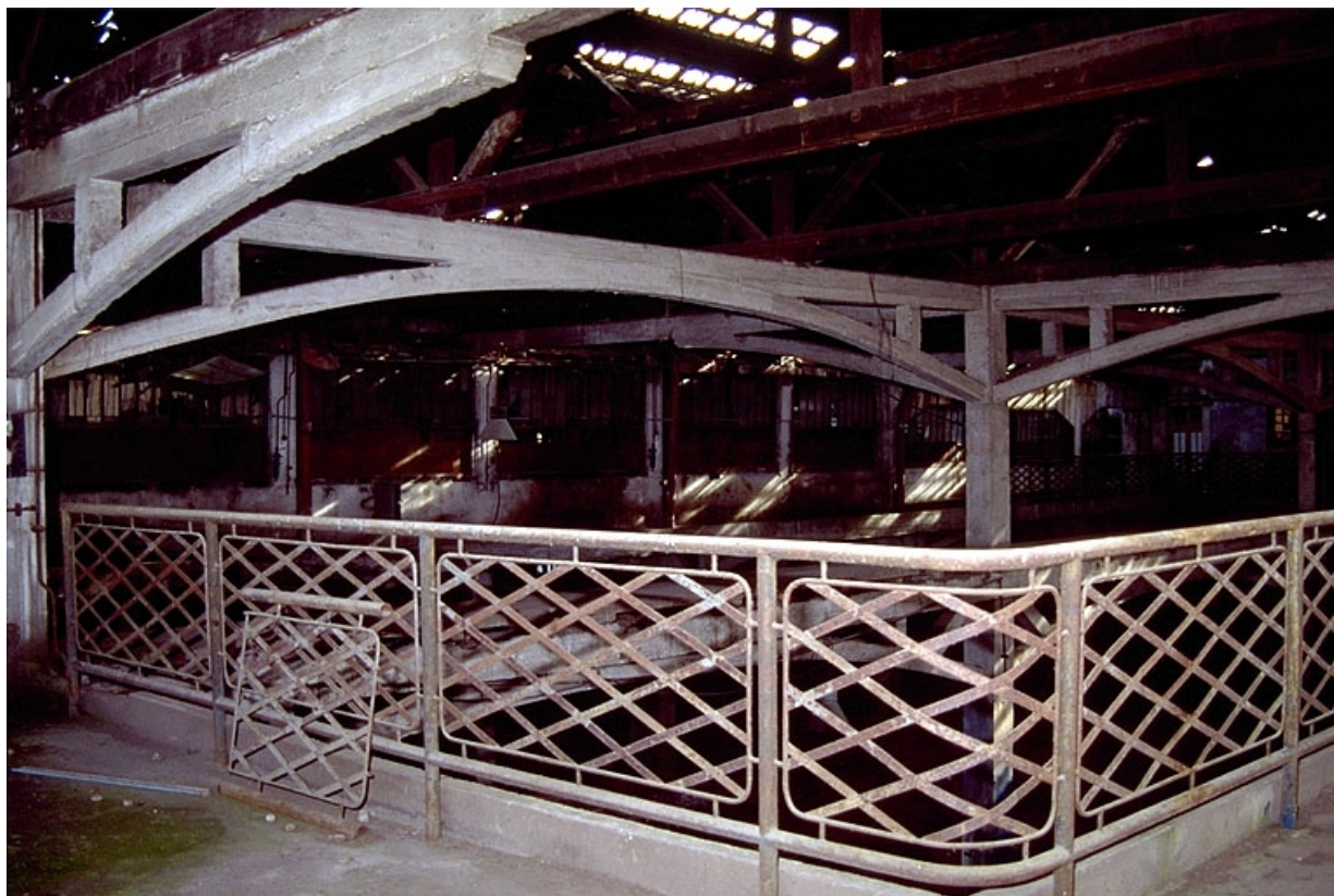
Cour couverte et atelier des presses (B) : galerie à l'étage. 39, Saint-Amour, 25 rue Lamartine
