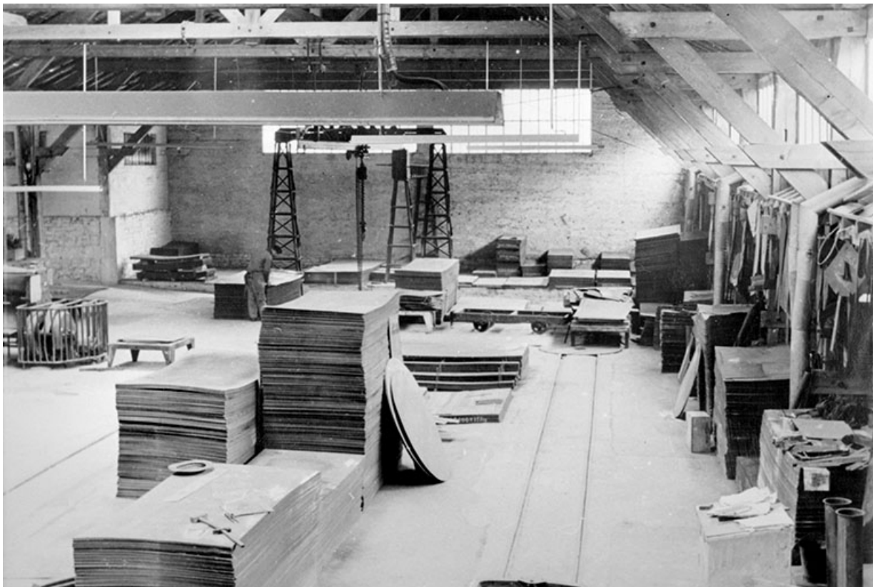
Intérieur de l'entrepôt industriel (J2) avec traçage et découpage. 39, Saint-Amour, 25 rue Lamartine
