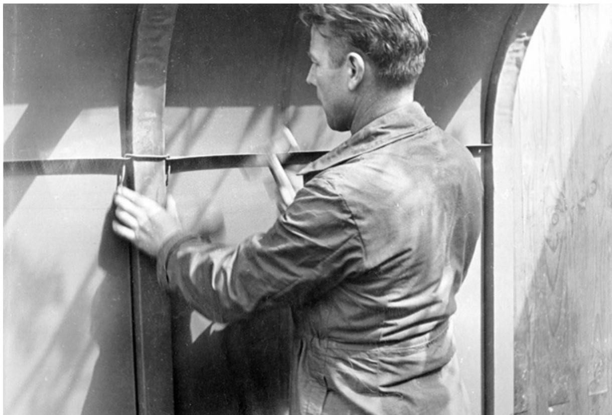
Montage d'un baraquement métallique : pose d'une agrafe.
