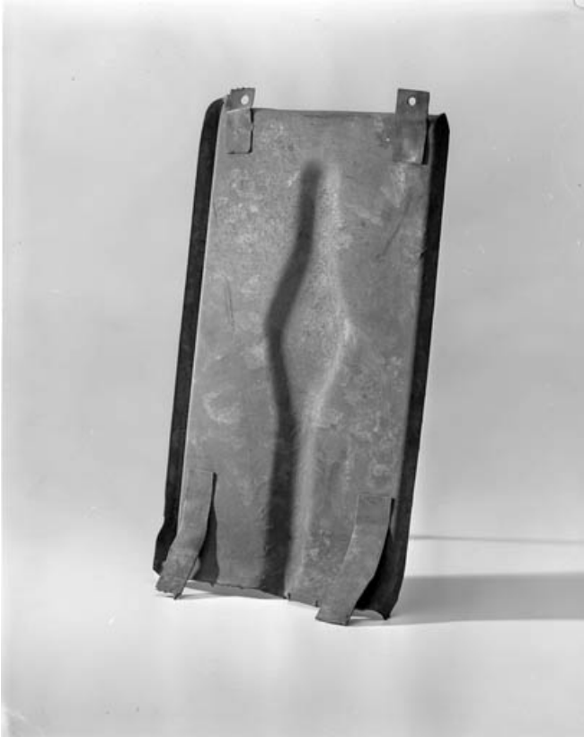
Tuile métallique Fillod brevetée : face inférieure.
