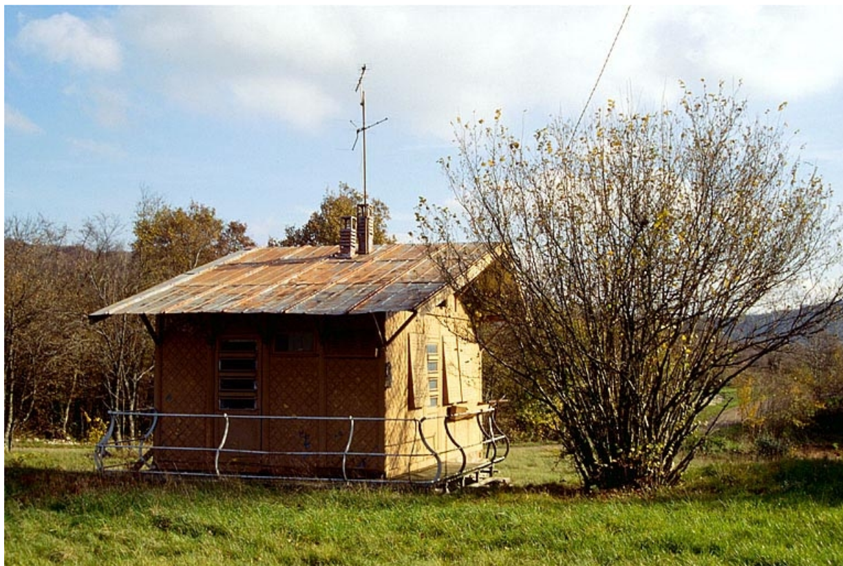
Maison (bungalow) dans la commune de Montagna-le-Reconduit : vue d'ensemble.
