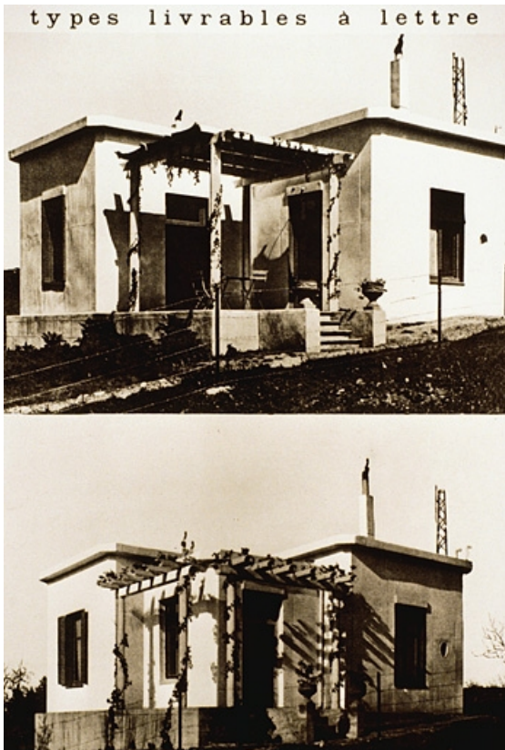
Exemple de constructions dans les années 1930 : maisons T1 et T2. 39, Saint-Amour, 25 rue Lamartine
