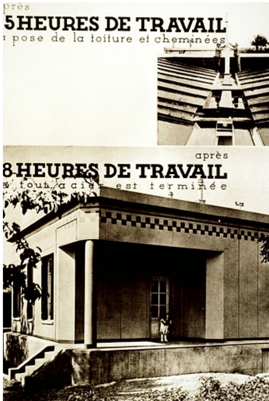
Montage d'une maison tout acier dans les années 1930 : pose de la cheminée et maison achevée. 39, Saint-Amour, 25 rue Lamartine
