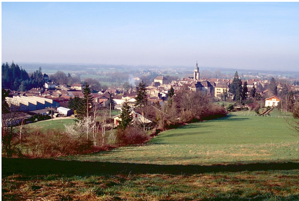
Vue d'ensemble de l'usine rue Lamartine et de la maison métallique rue de Peroset. 39, Saint-Amour, 25 rue Lamartine
