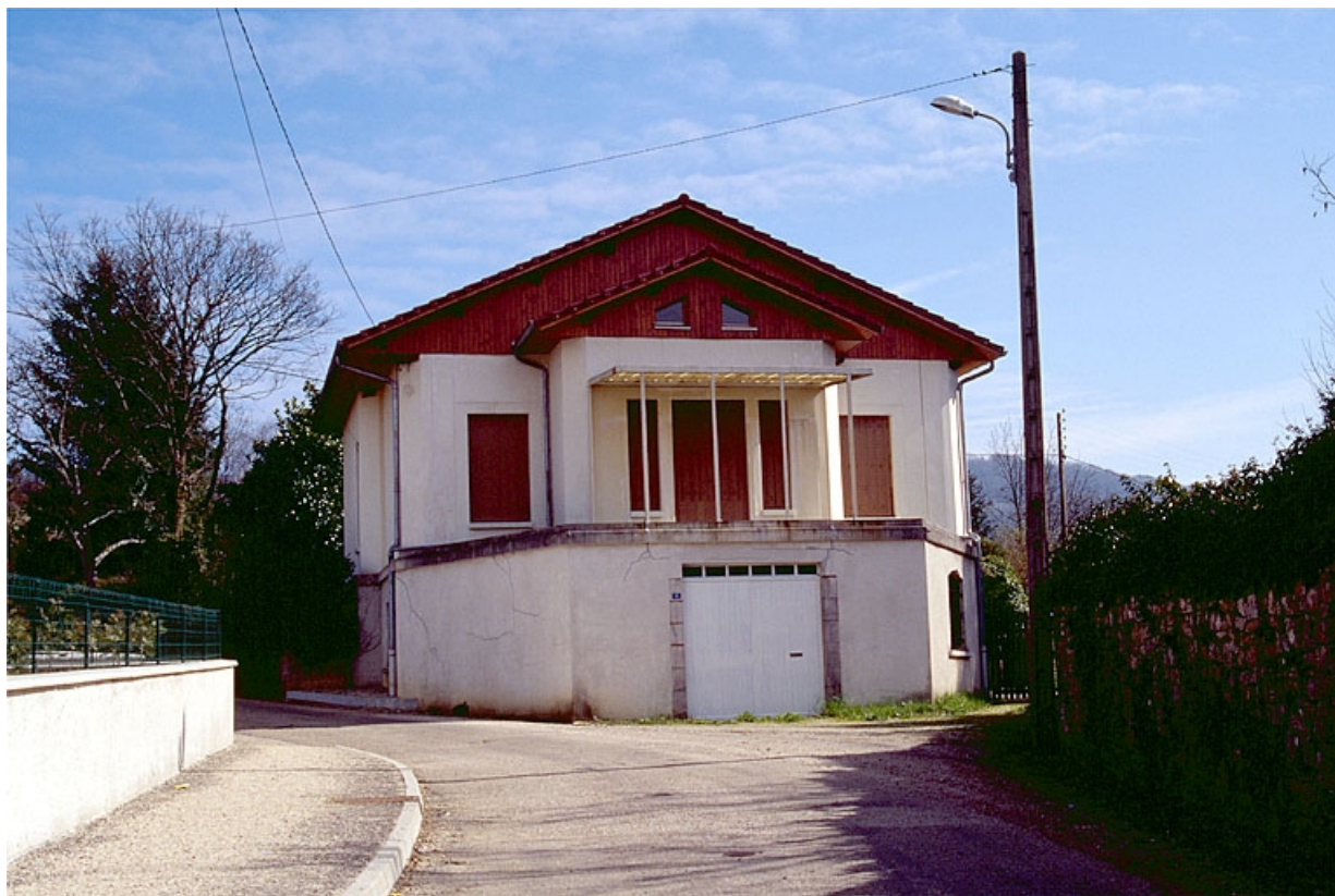
Maison métallique rue de Peroset : façade antérieure.
