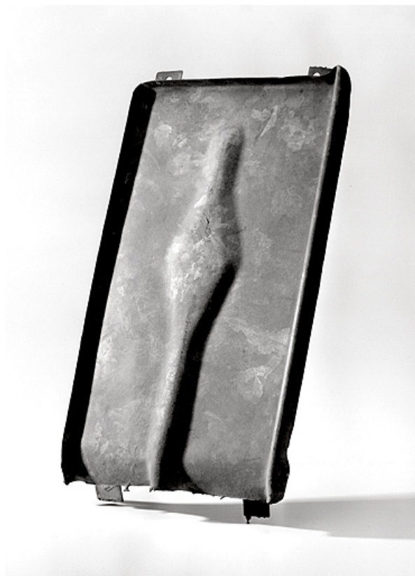
Tuile métallique Fillod brevetée : face supérieure.
