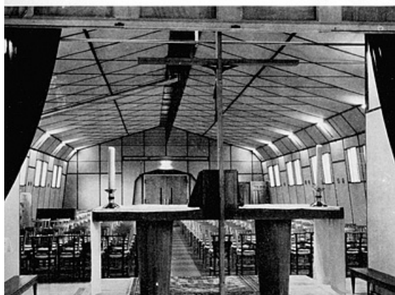
Bâtiment à paroi inclinée à usage d'église (non localisé) au début des années 1960. 39, Saint-Amour, 25 rue Lamartine
