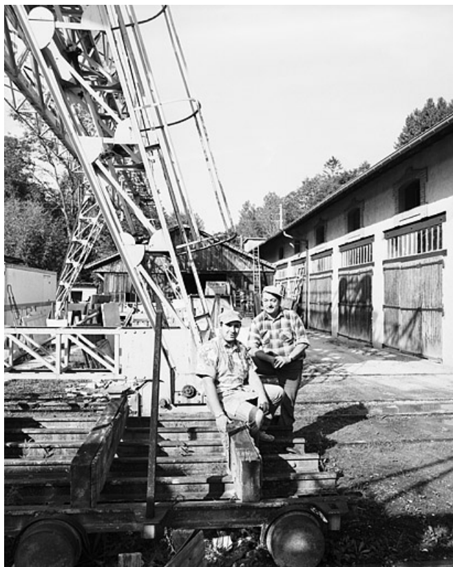
Ouvriers au pied du portique roulant.
