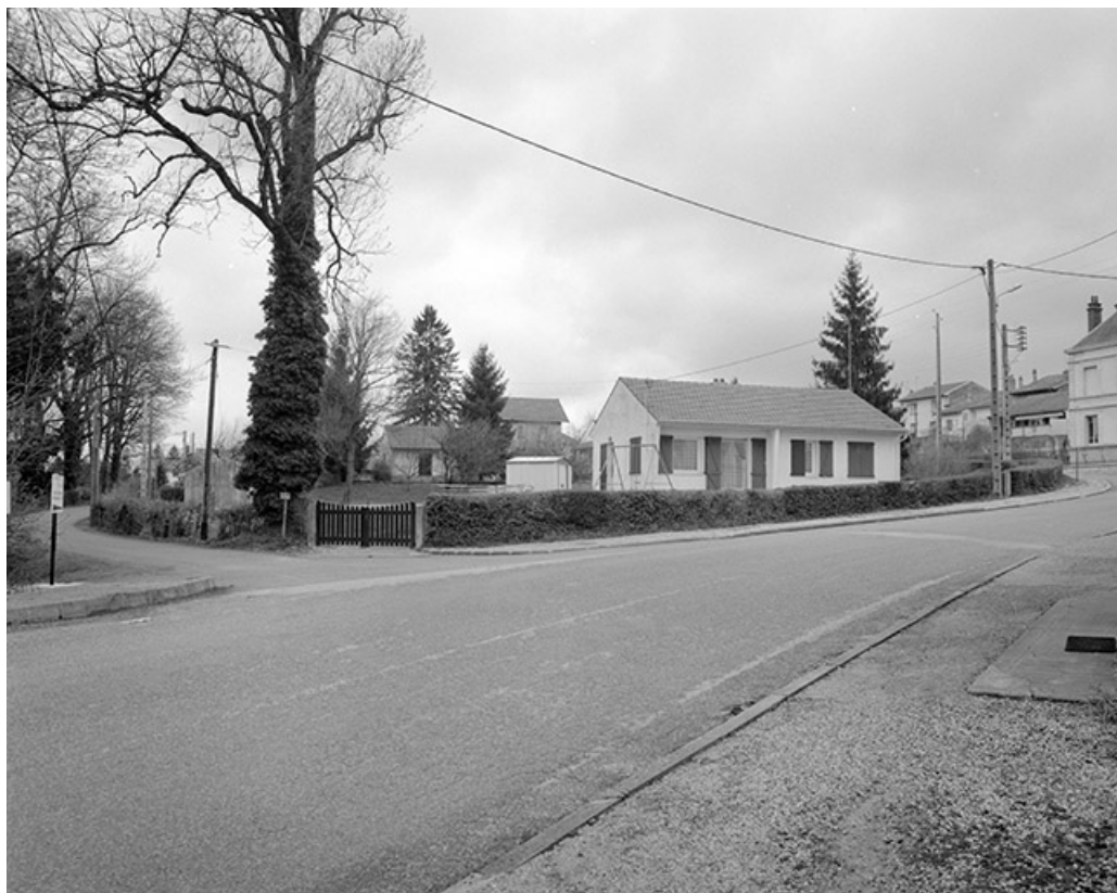
Vue d'ensemble des logements d'ouvriers, depuis le sud.
