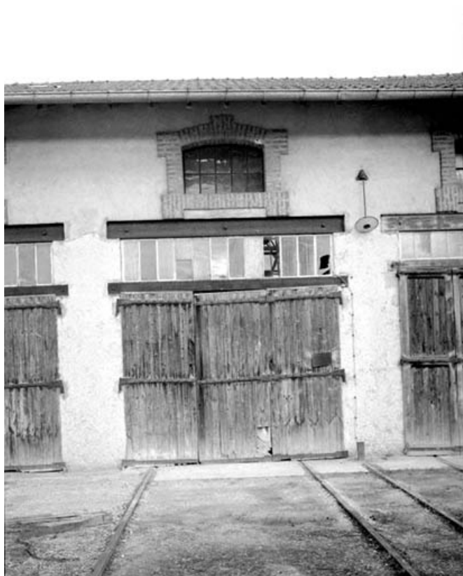
Détail d'une travée de la scierie.
