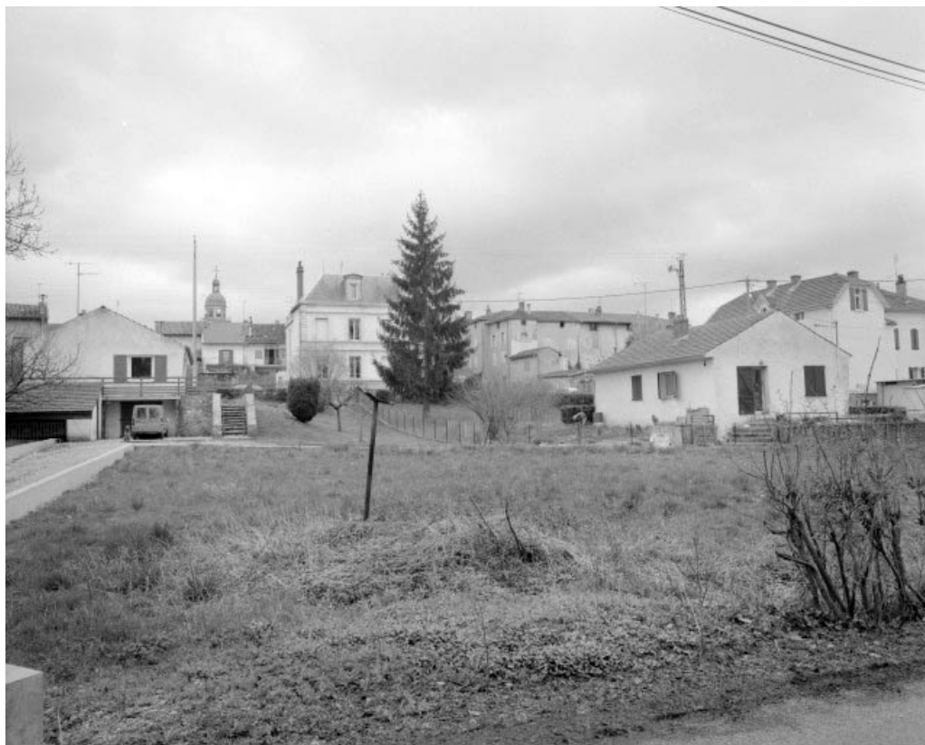
Vue d'ensemble des logements d'ouvriers, depuis l'ouest. Maison de 1956 à gauche, de 1959 à droite. 39, Saint-Amour, 2 à 6 rue de la Marbrerie
