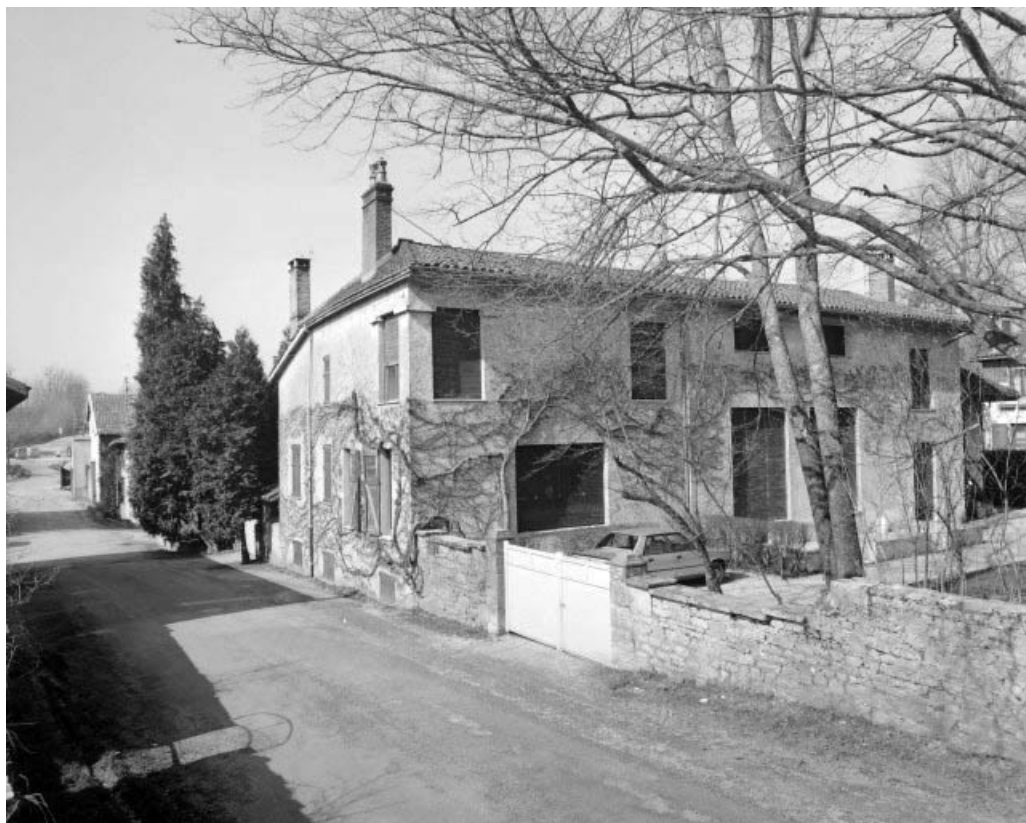
Façades latérale gauche et postérieure du logement patronal (O).
