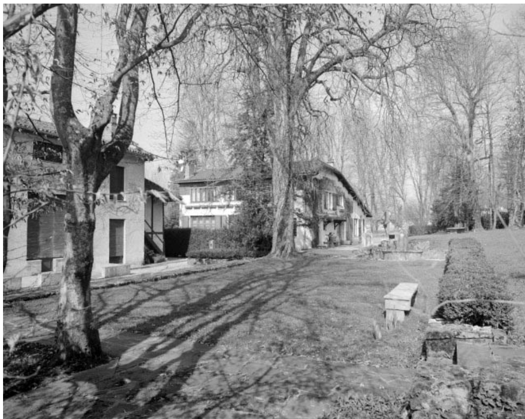
Façades latérale gauche et postérieure du logement patronal (P).
