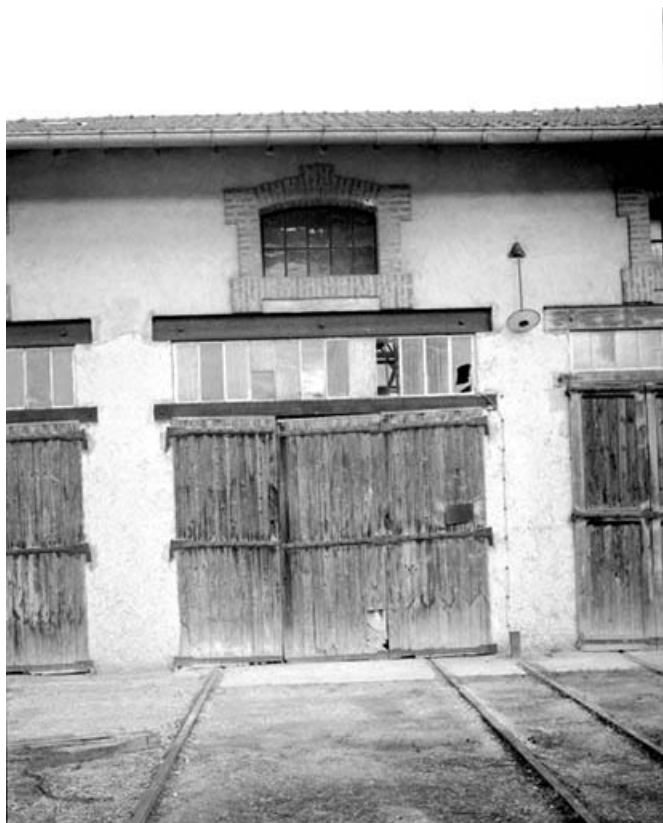
Détail d'une travée de la scierie.
