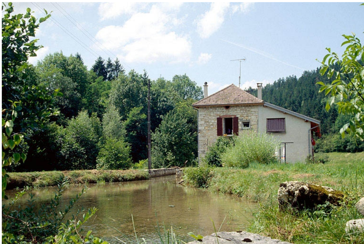
Bassin de retenue et façade latérale gauche.
