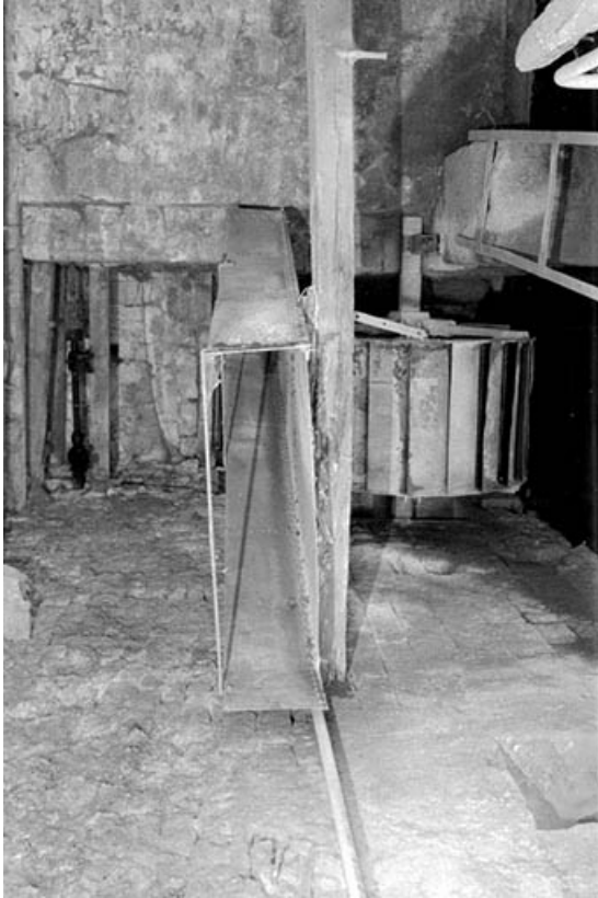
Roue en dessus et conduite d'amenée.
