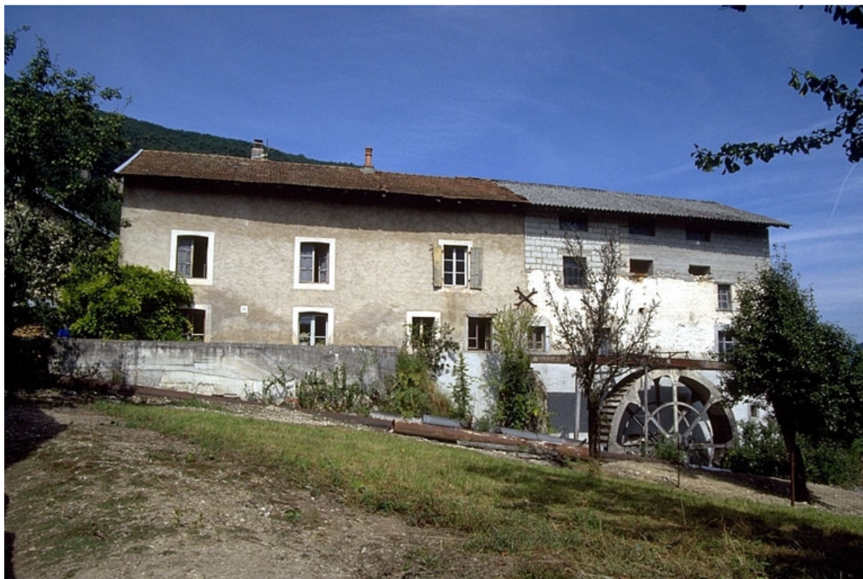
Façade postérieure du logement et de l'atelier de fabrication.
