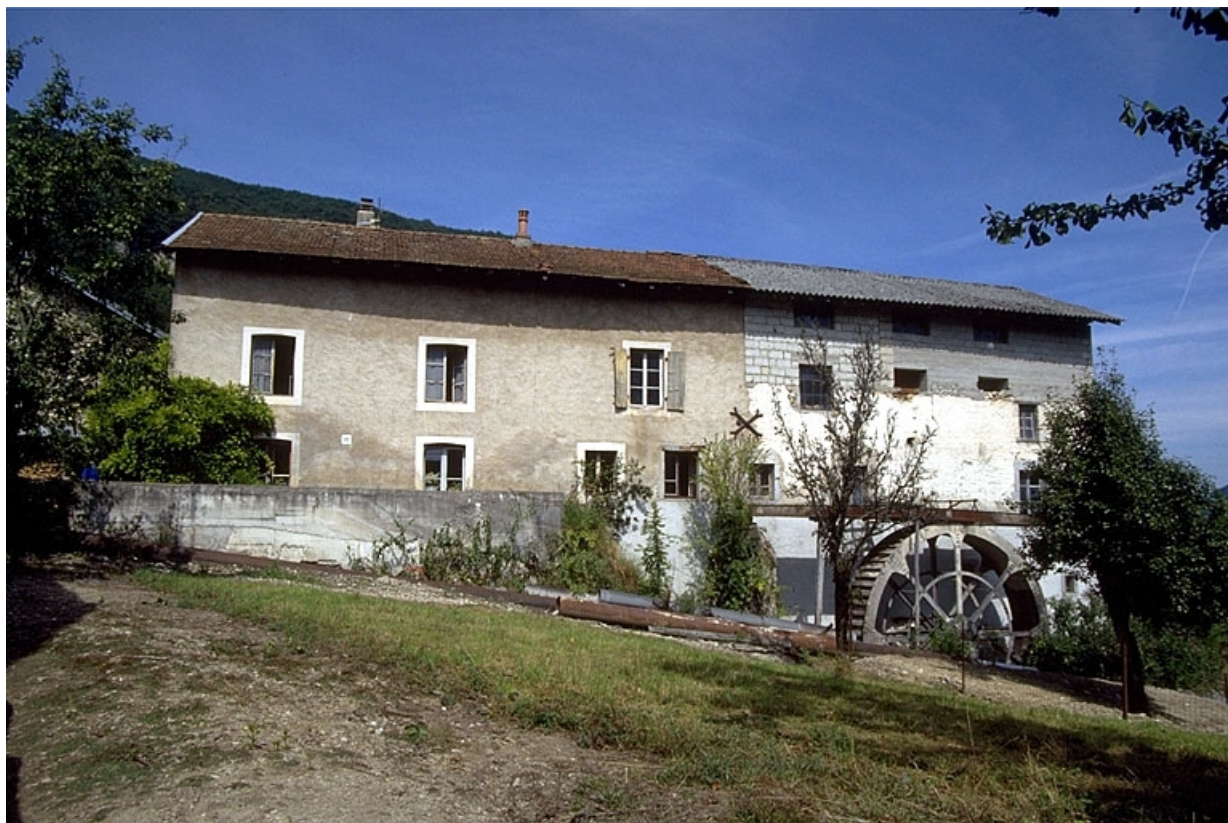
Façade postérieure du logement et de l'atelier de fabrication. 39, Condes
