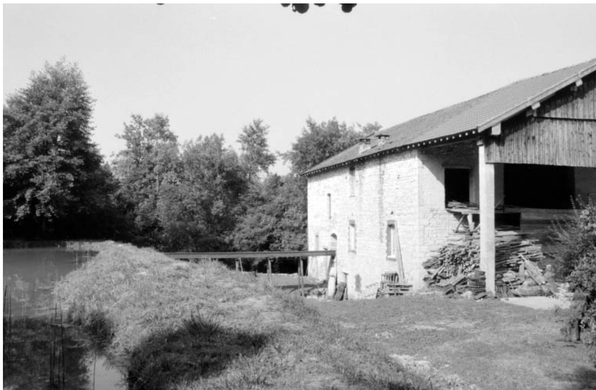
Façade postérieure et conduite d'aménée de la roue.
