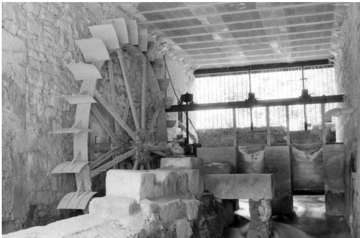
Vannes de prise d'eau, coursiers et roue en dessous.
