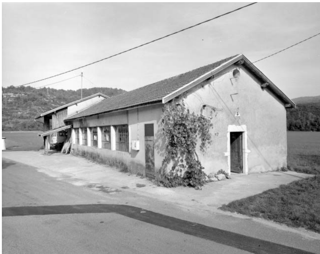
Façades antérieure et latérale droite.
