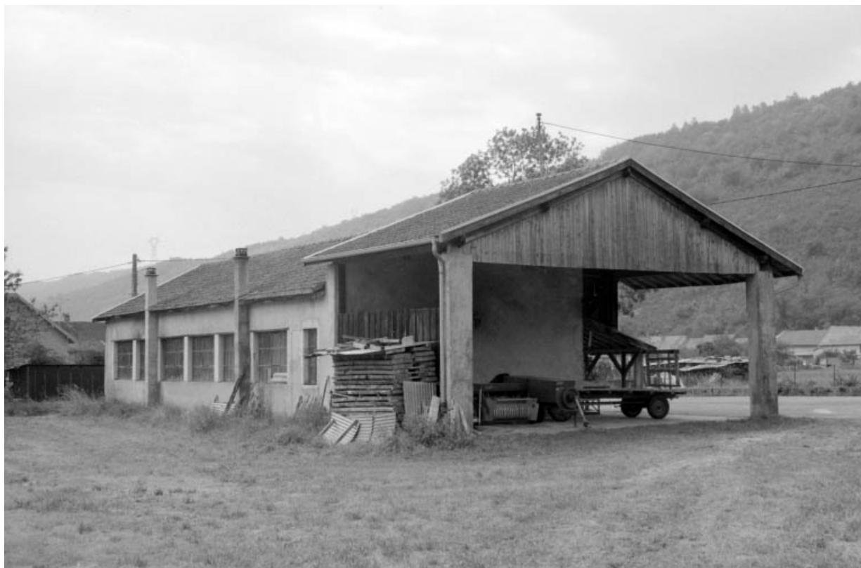
Façades postérieure et latérale gauche.
