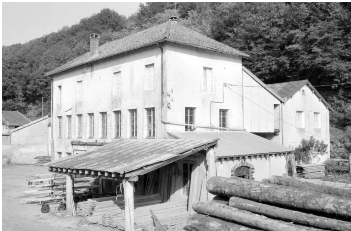
Ancienne tournerie, salle des machines et ancienne huilerie.
