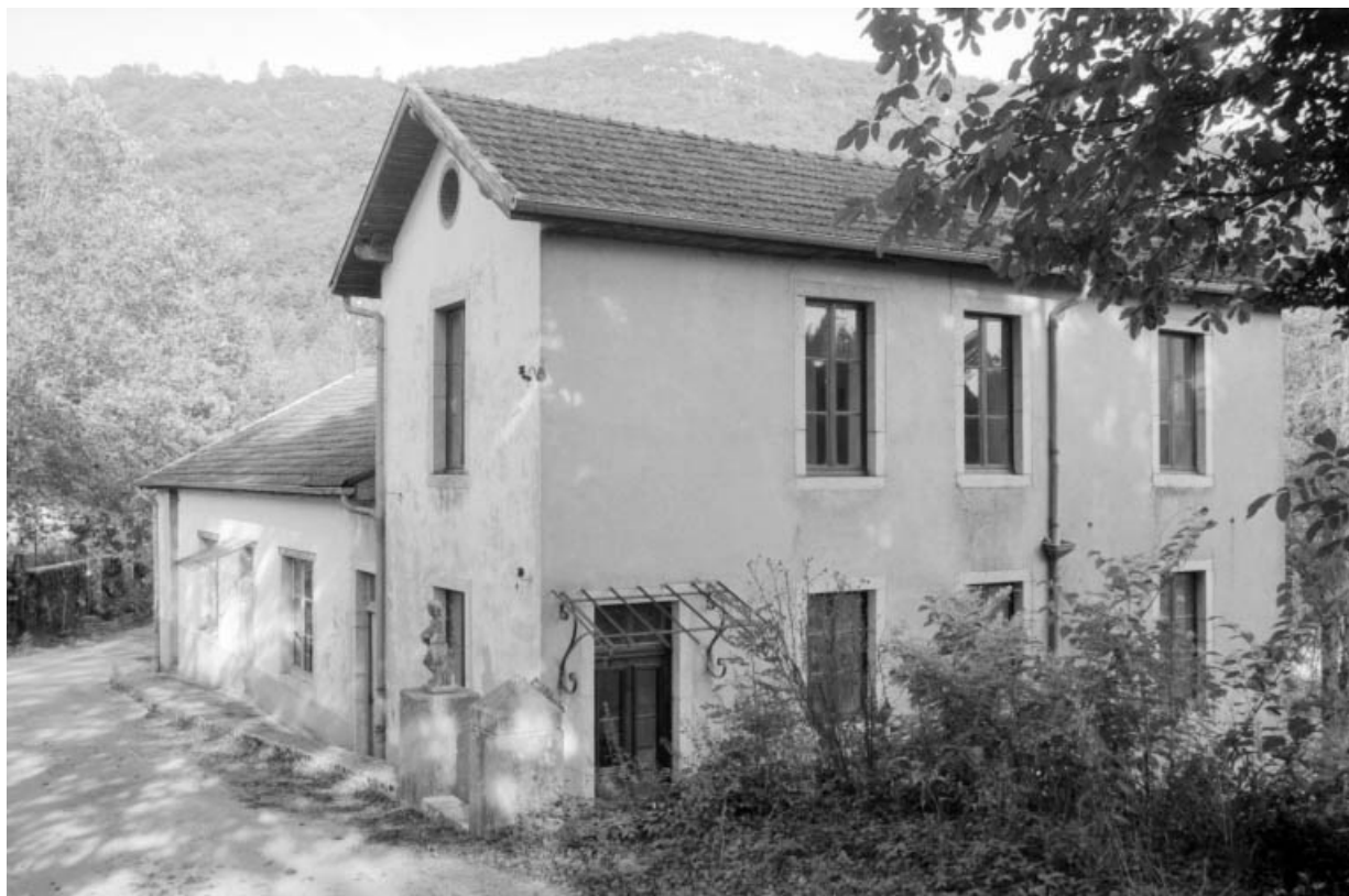
Ateliers de fabrication (C, D), vus de trois quarts droite.
