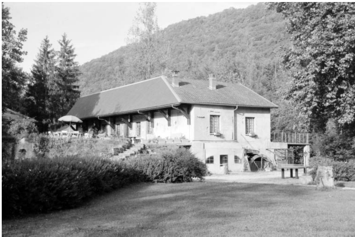
Bâtiment d'eau, vu de trois quarts droite.
