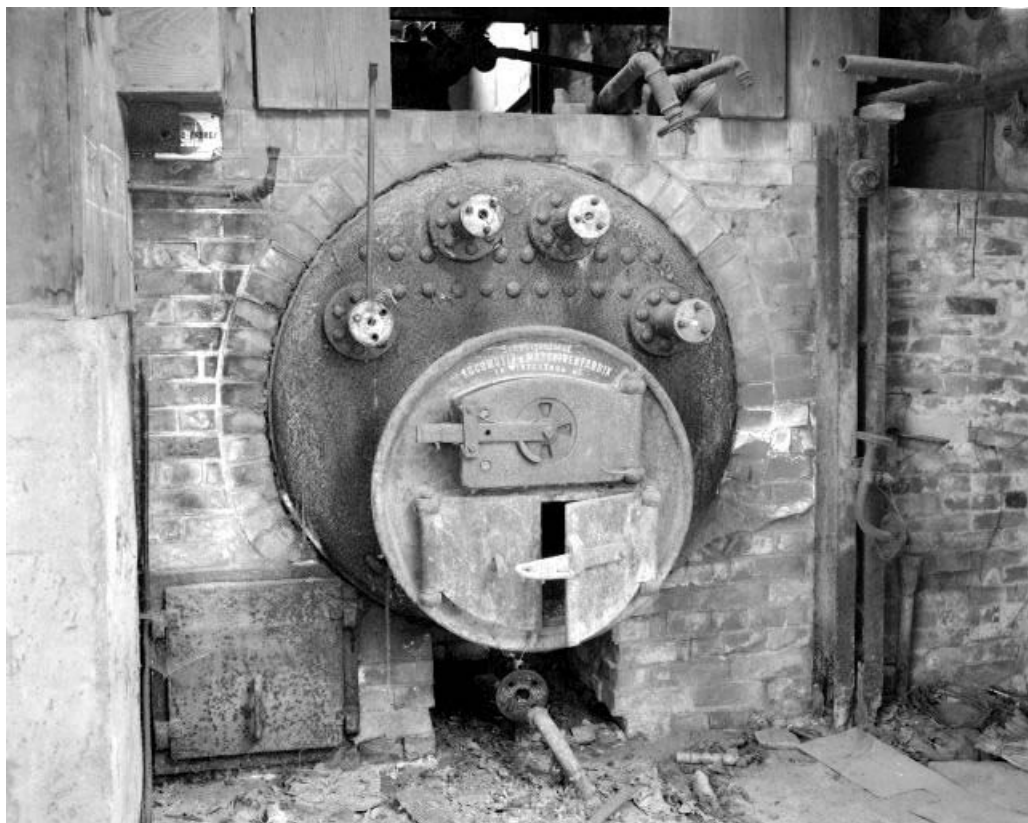
Intérieur de la chaufferie (Q) : chaudière.
