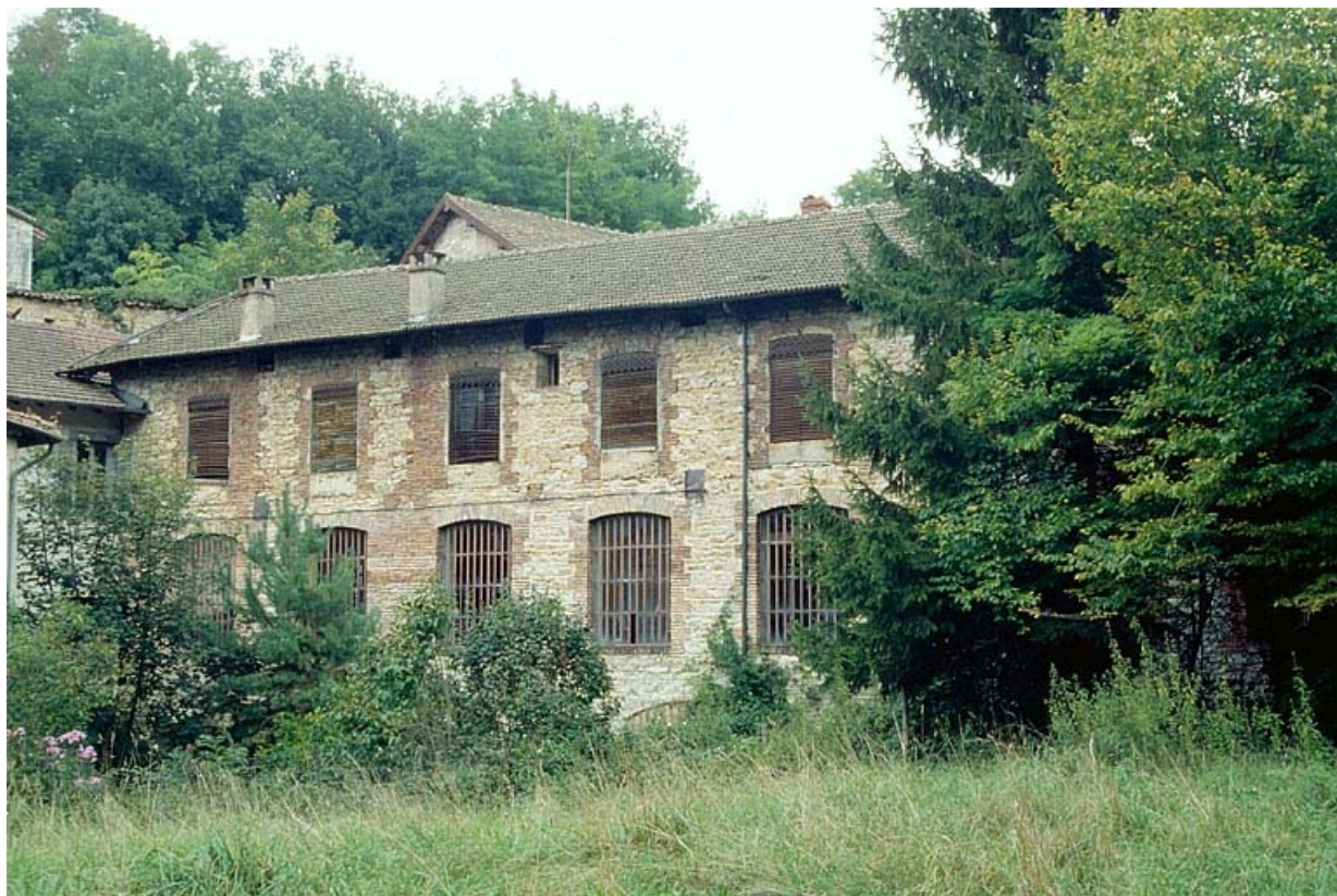
Atelier de fabrication (N) vu du sud.
