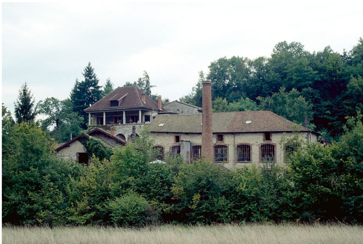
Ateliers de fabrication (J, N), vus du sud-est.
