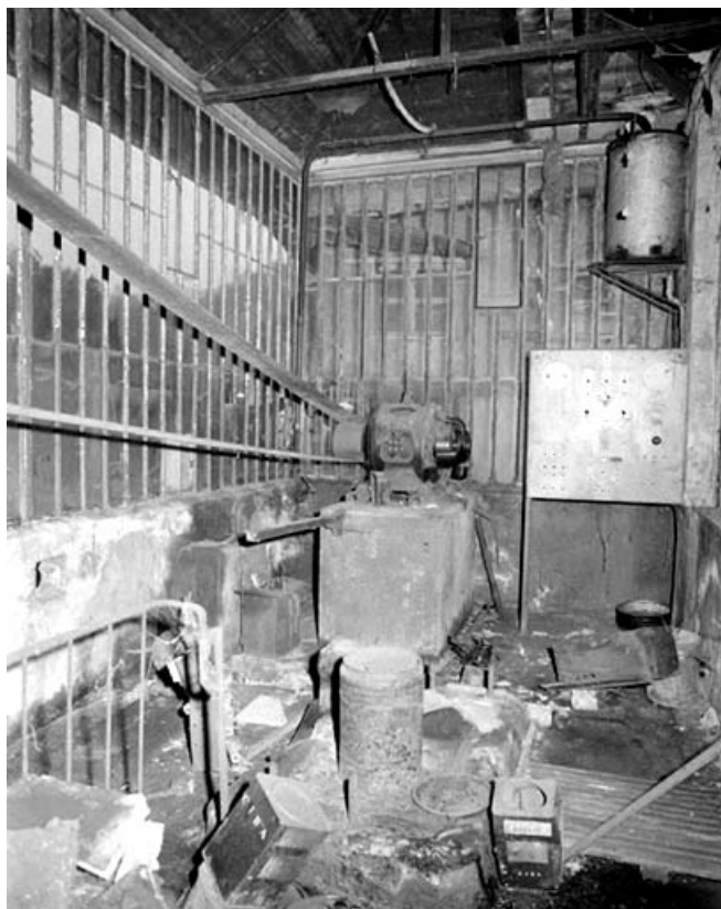
Moteur électrique Patay.
