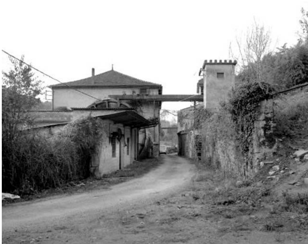
Vue d'ensemble depuis le nord-est.
