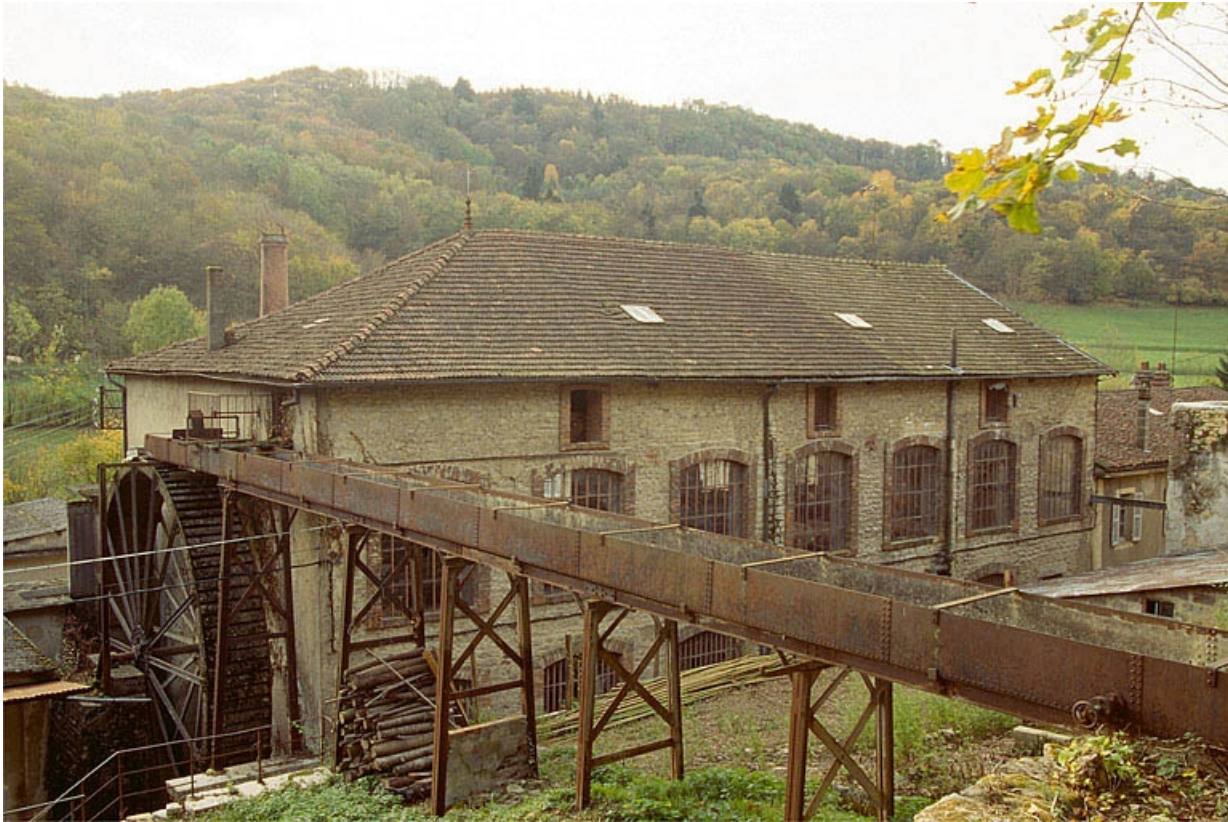
Grande roue hydraulique et atelier de fabrication (J).
