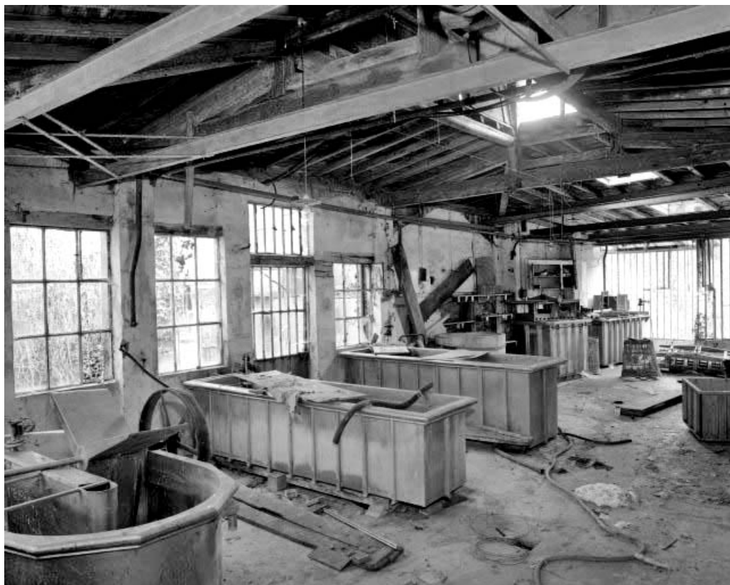
Intérieur de l'atelier de teinture (bâtiment P).
