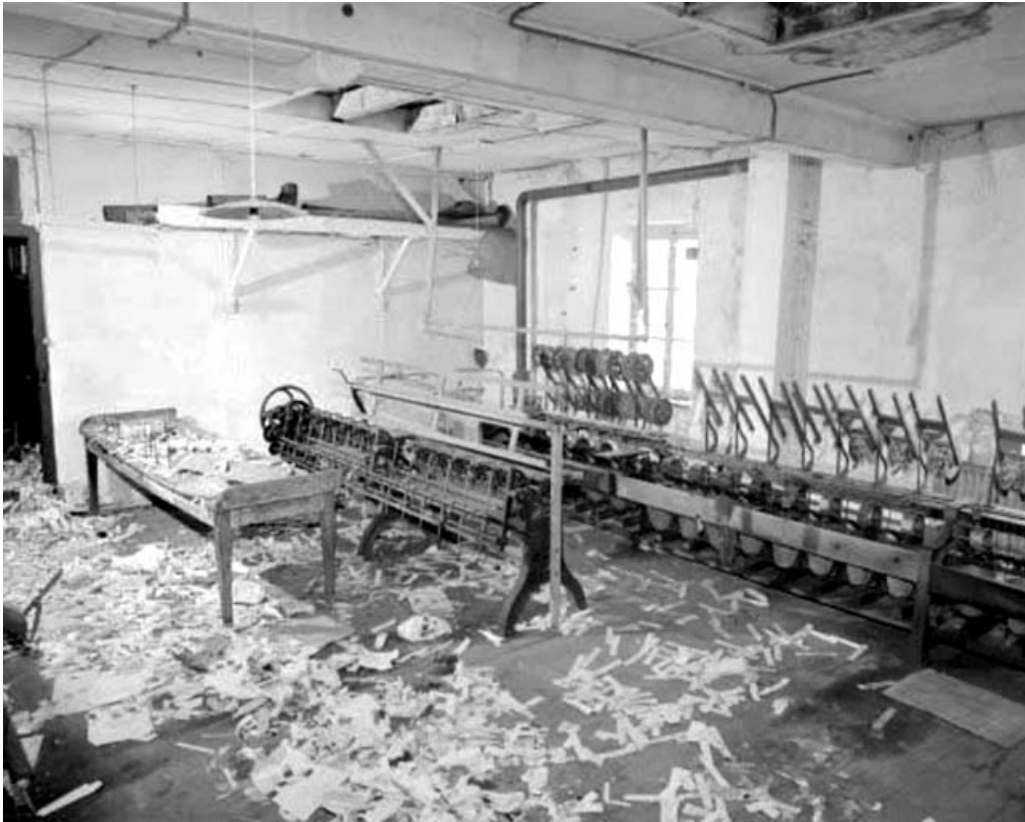
Intérieur de l'atelier de conditionnement (premier étage du bâtiment K).
