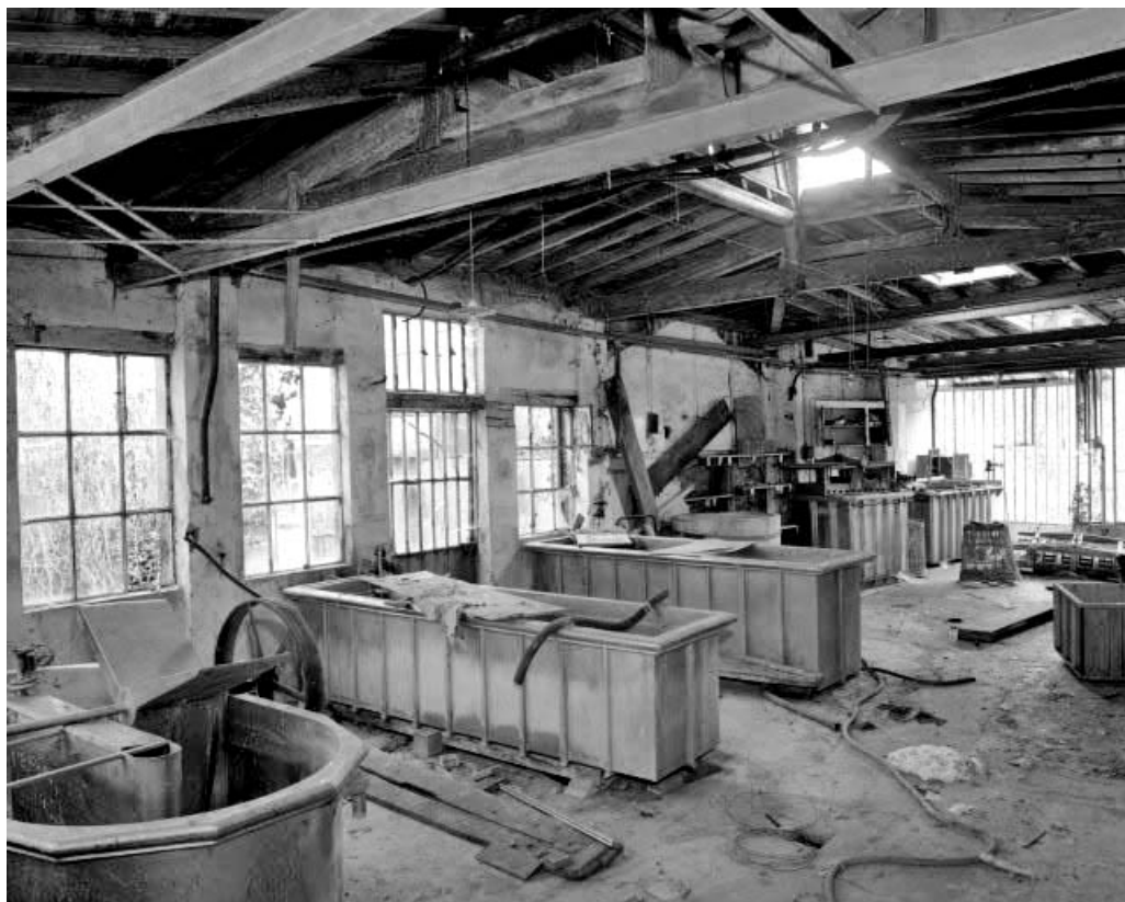
Intérieur de l'atelier de teinture (bâtiment P).
