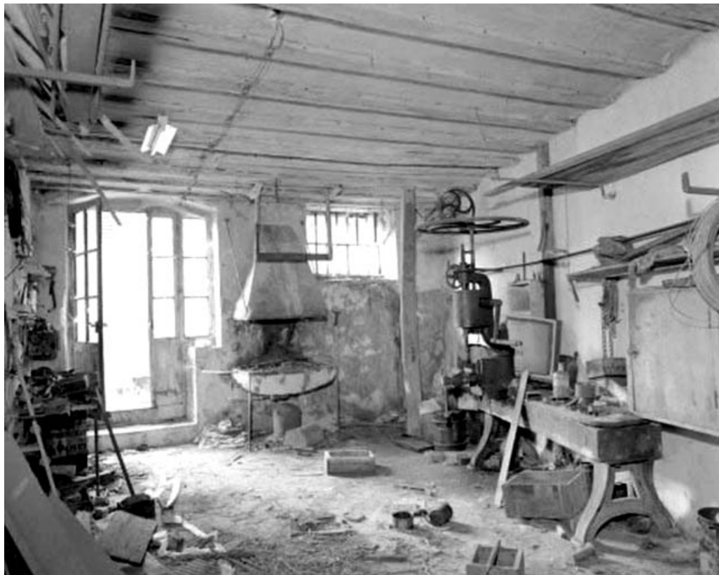
Intérieur de l'atelier de réparation (soubassement du bâtiment N).
