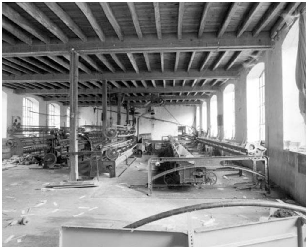
Intérieur de l'atelier de filature (premier étage du bâtiment J).
