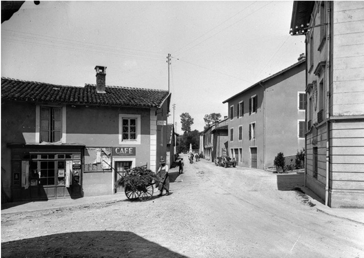
Café, logement patronal et logement d'ouvriers. 39, Balanod
