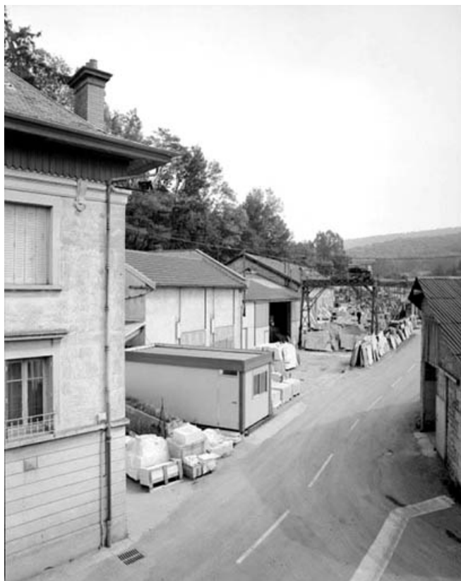
Atelier de fabrication, de trois quarts gauche.
