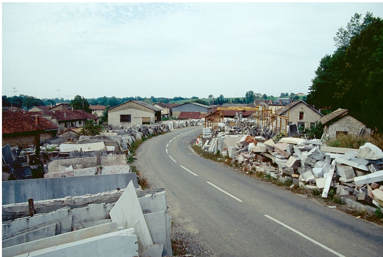
Vue d'ensemble depuis la route, à l'est.
