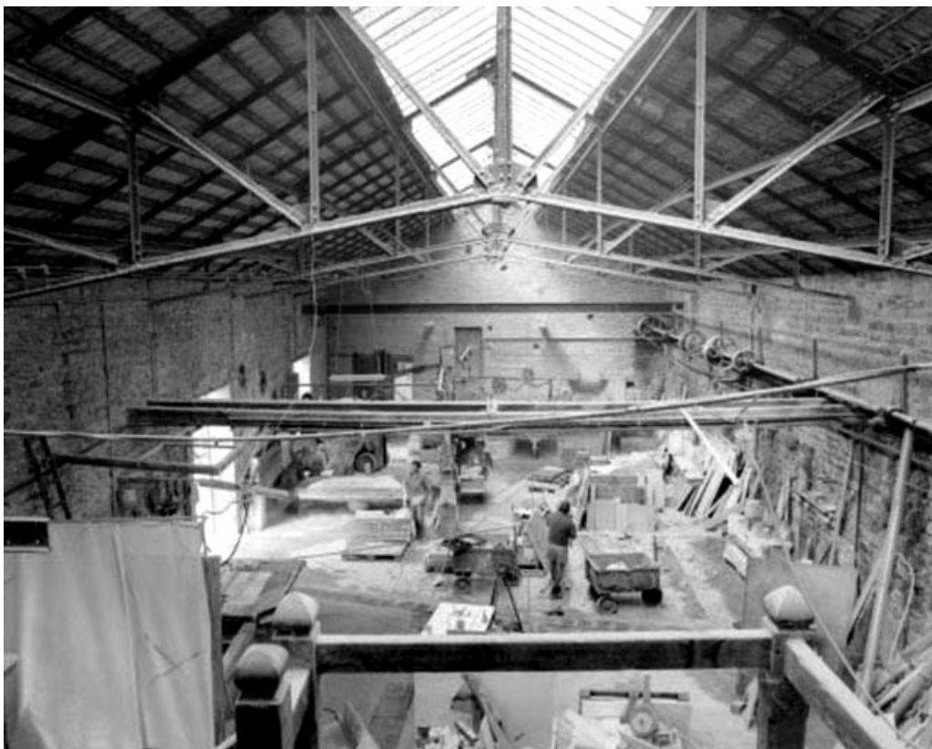
Intérieur de l'atelier central (débitage-polissage). 39, Balanod
