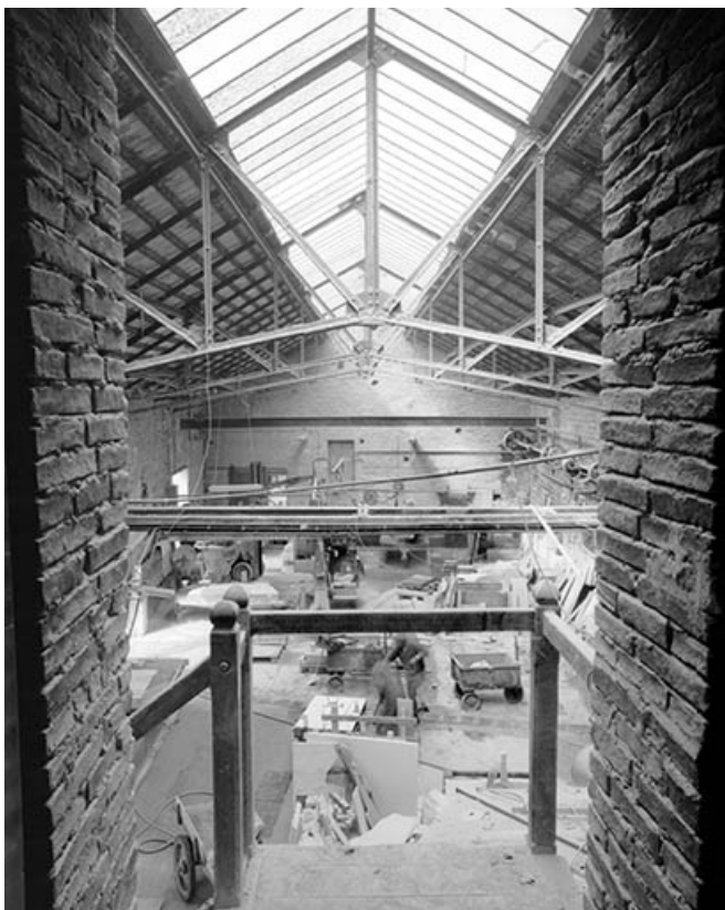
Intérieur de l'atelier central (débitage-polissage). 39, Balanod
