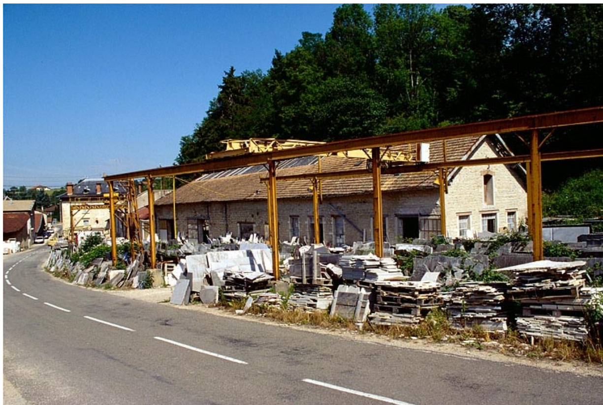
Atelier de fabrication, de trois quarts droite.
