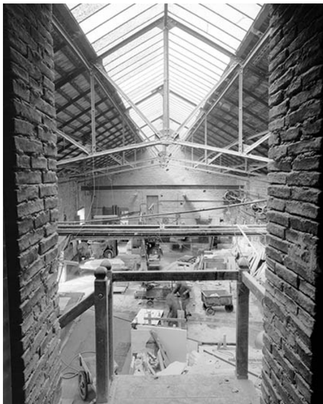
Intérieur de l'atelier central (débitage-polissage). 39, Balanod
