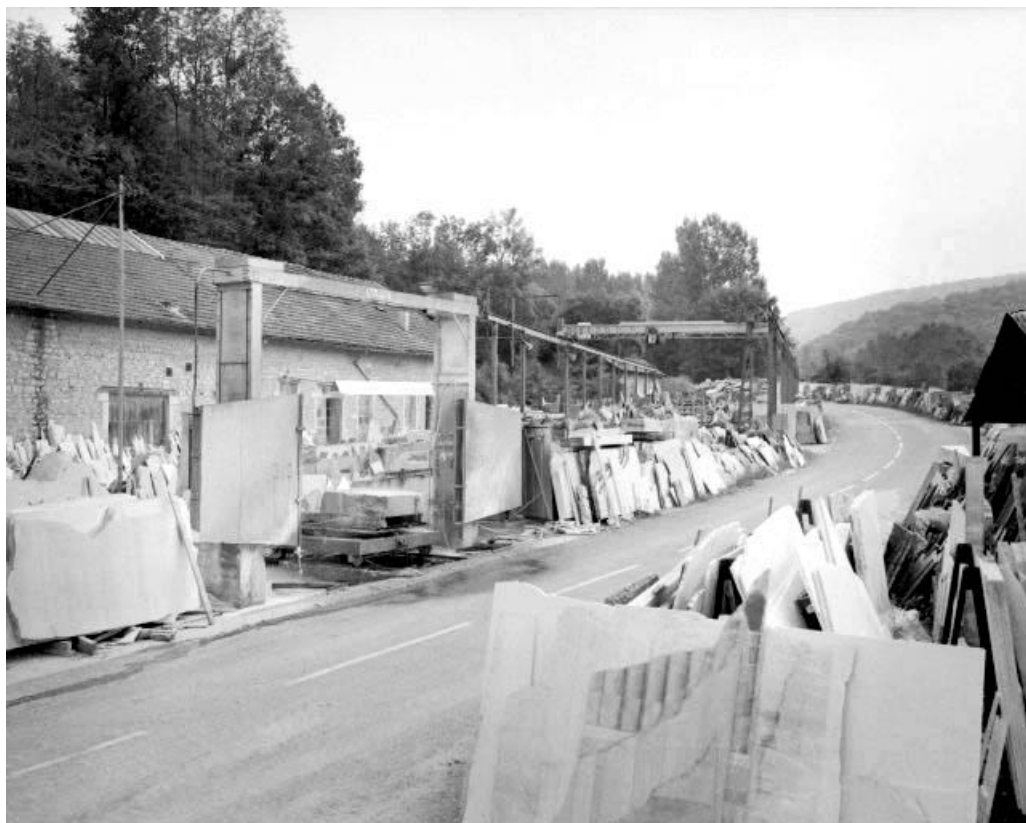
Atelier de fabrication, scie à fil et pont roulant. 39, Balanod
