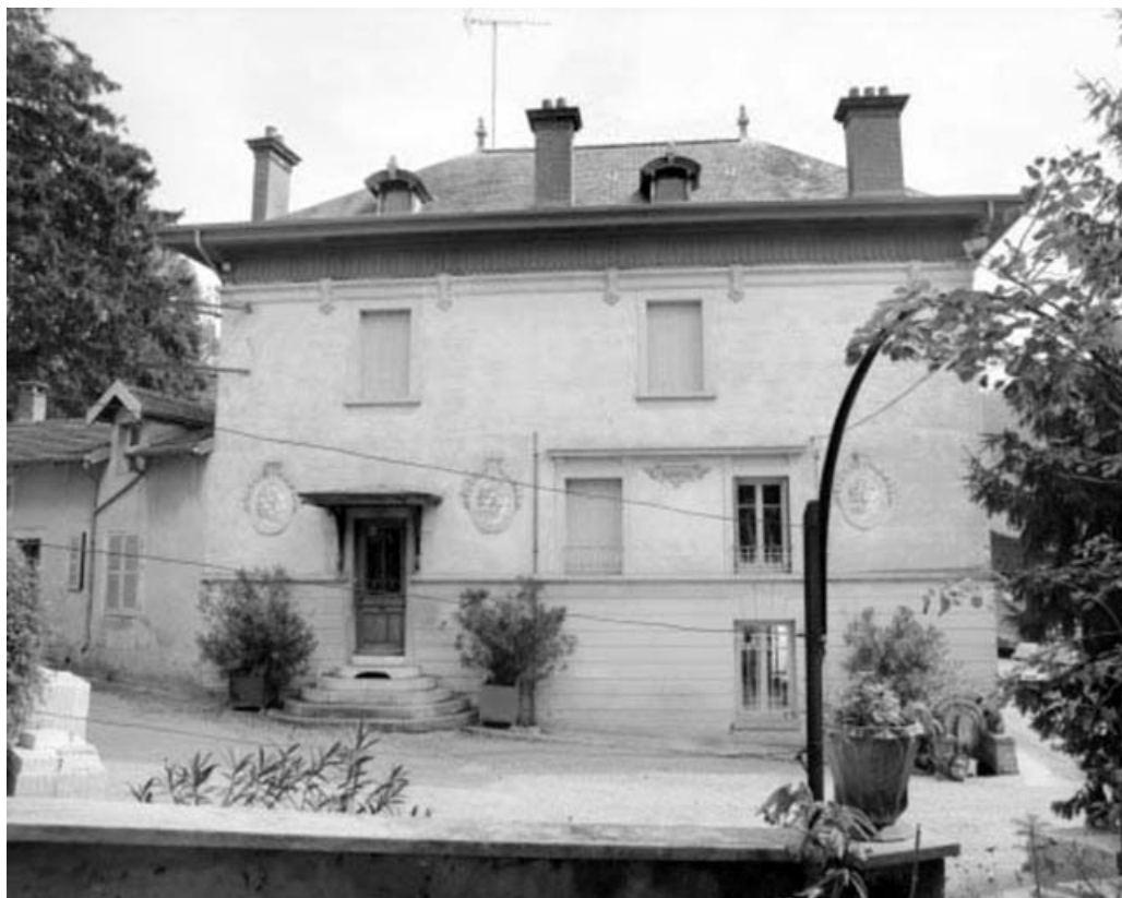
Façade latérale gauche du bureau.
