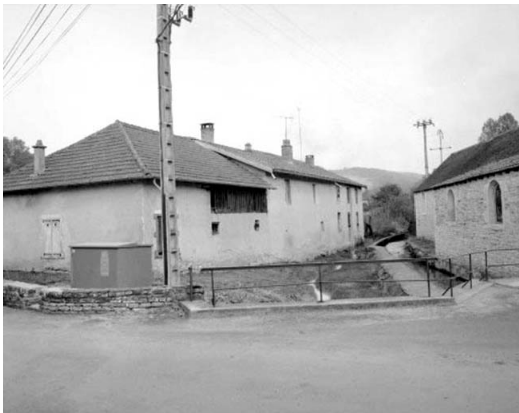
Logement d'ouvriers Q-R-S (ancien moulin Guyot) : façade postérieure. 39, Balanod
