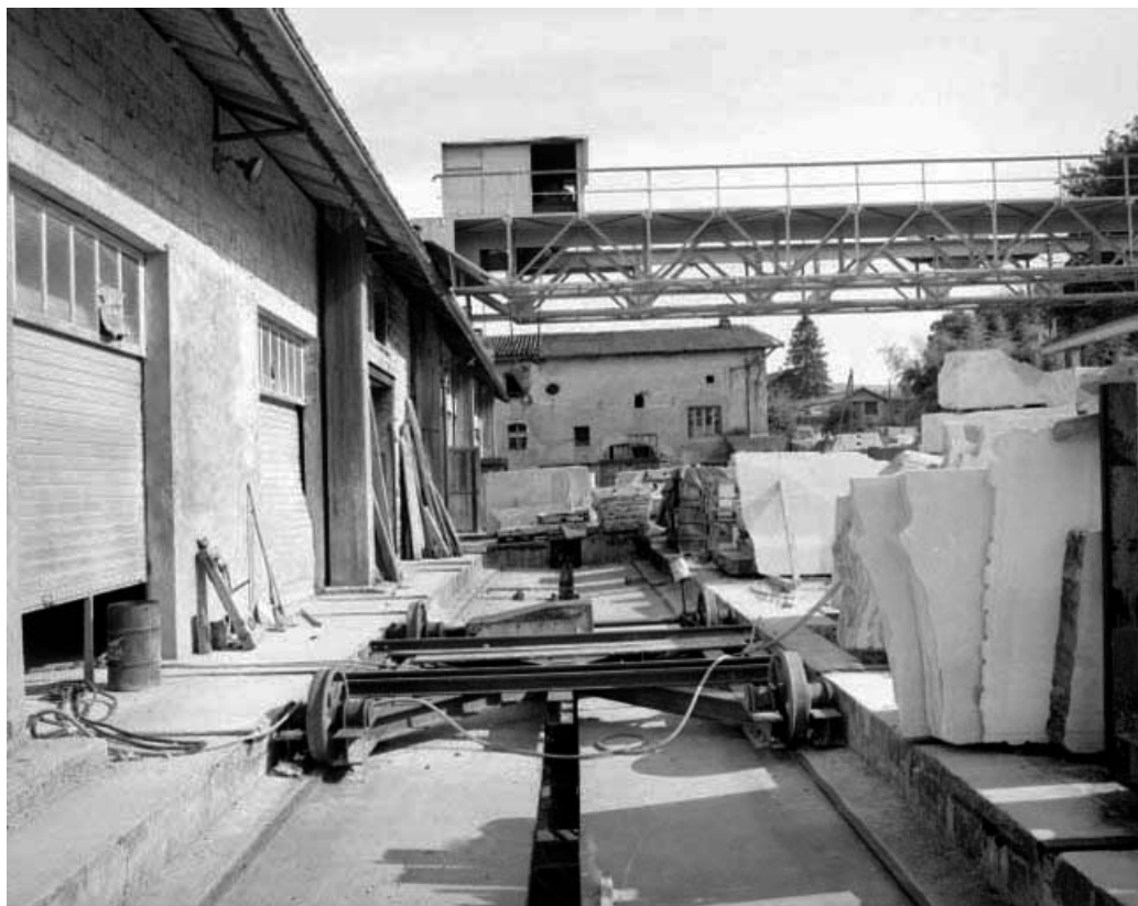
Chariot desservant l'atelier de fabrication.
