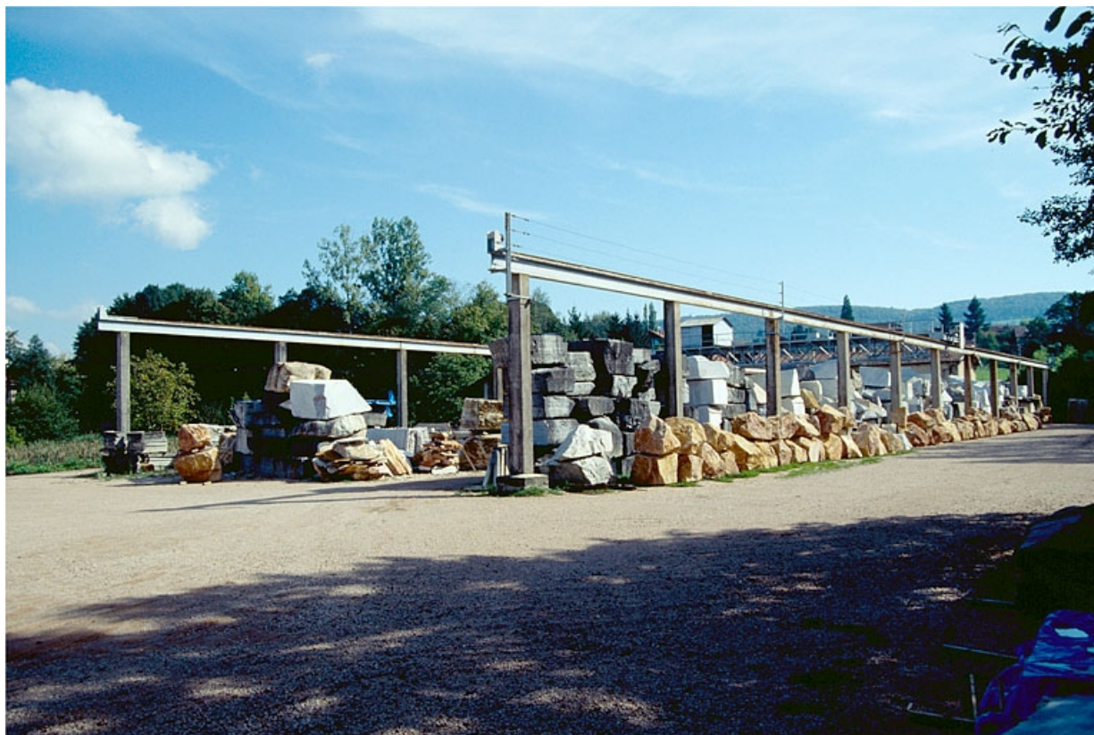
Pont roulant et aire des matières premières, vus de l'ouest.
