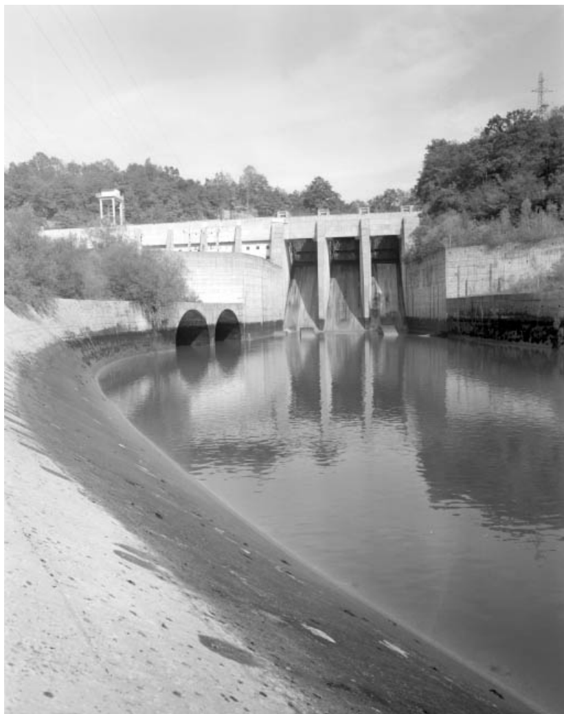
Evacuateur et bassin d'amortissement (cadrage vertical).
