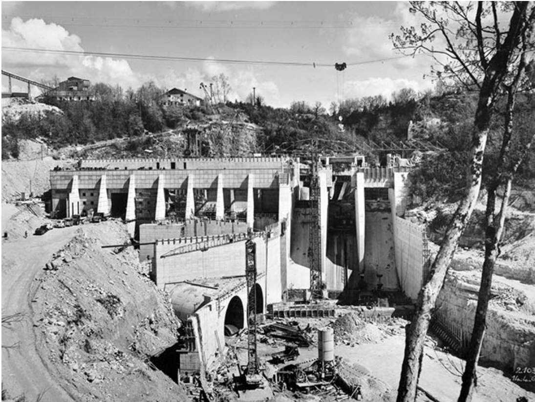
Vue du barrage - usine depuis la nouvelle route d'accès.
