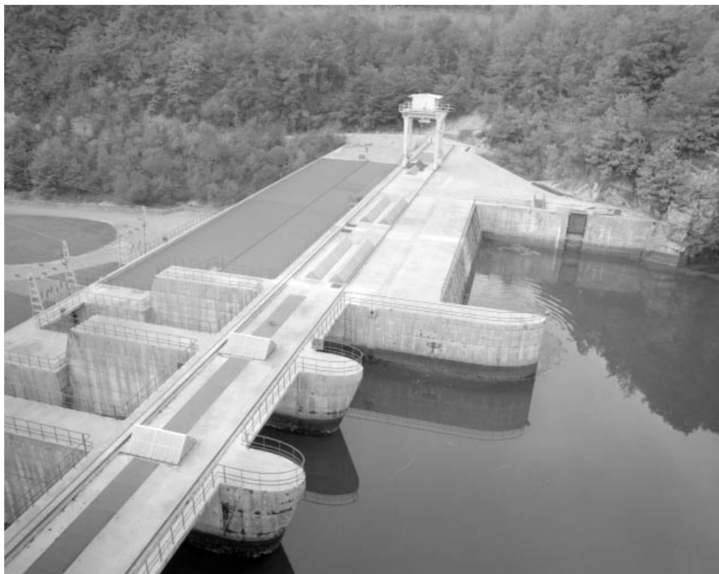
Evacuateur de crue et toiture de l'usine.
