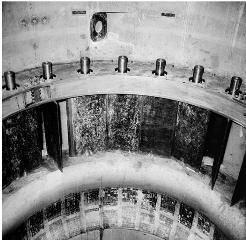
Turbine G.1 : distributeur en cours de montage.
