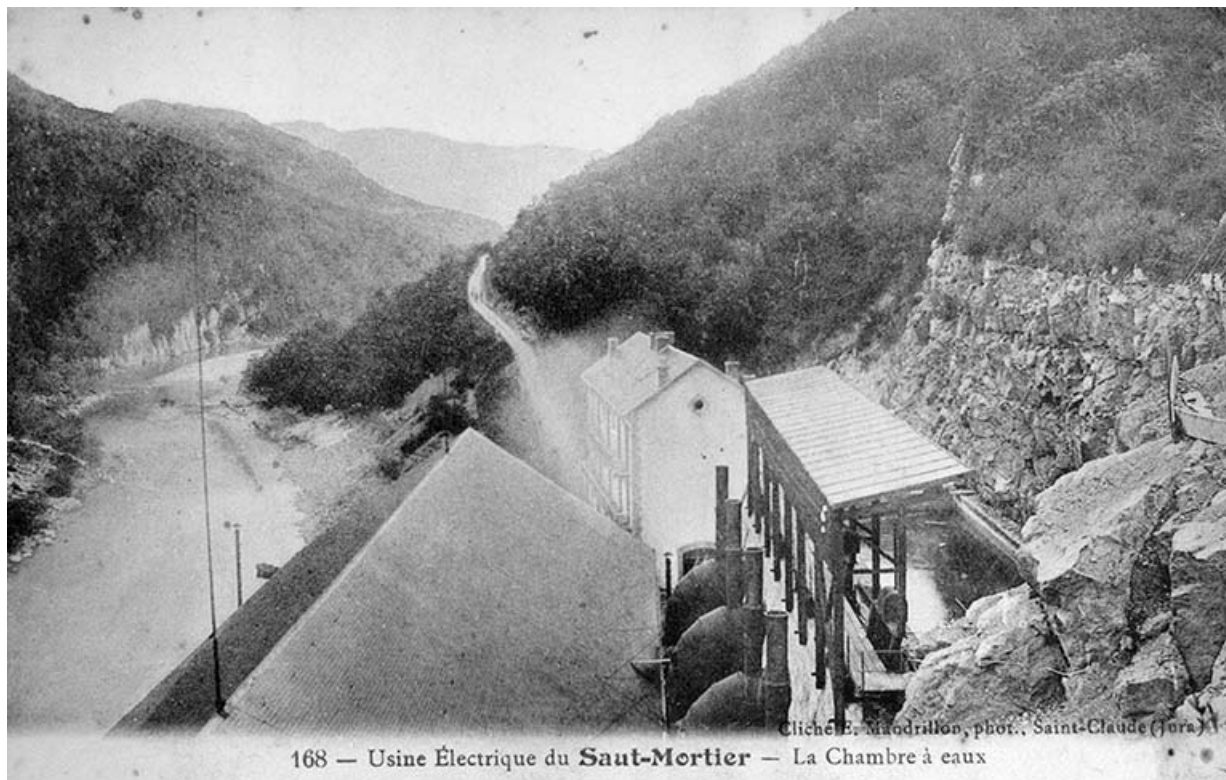
Usine Electrique du Saut-Mortier - La Chambre à eaux.
