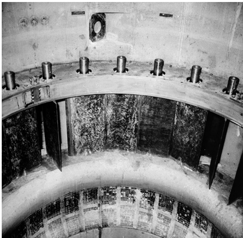
Turbine G.1 : distributeur en cours de montage.
