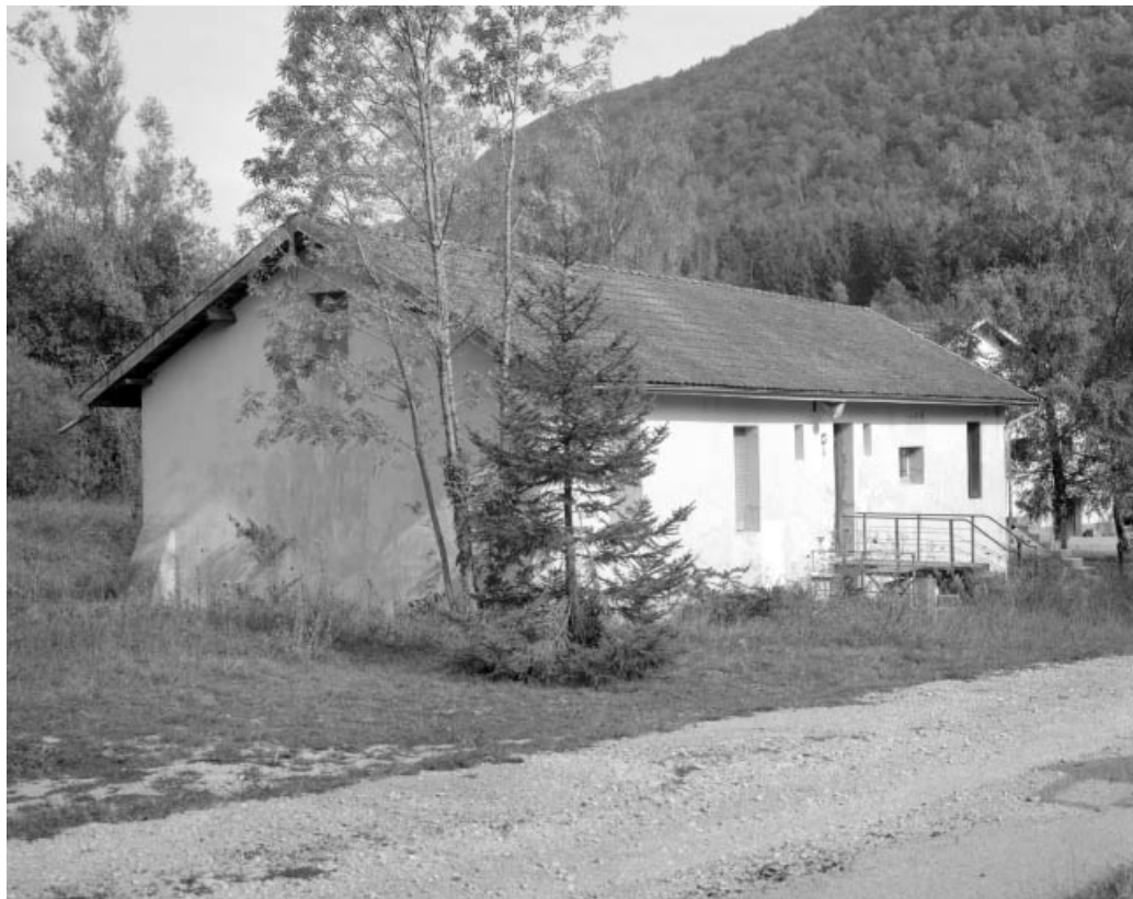
Logement d'ouvriers, vu de trois quarts gauche.
