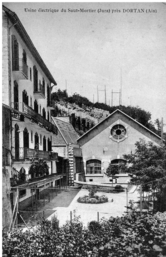
Usine électrique du Saut-Mortier (Jura) près Dortan (Ain). 39, Cernon, lieudit : le Saut-Mortier
