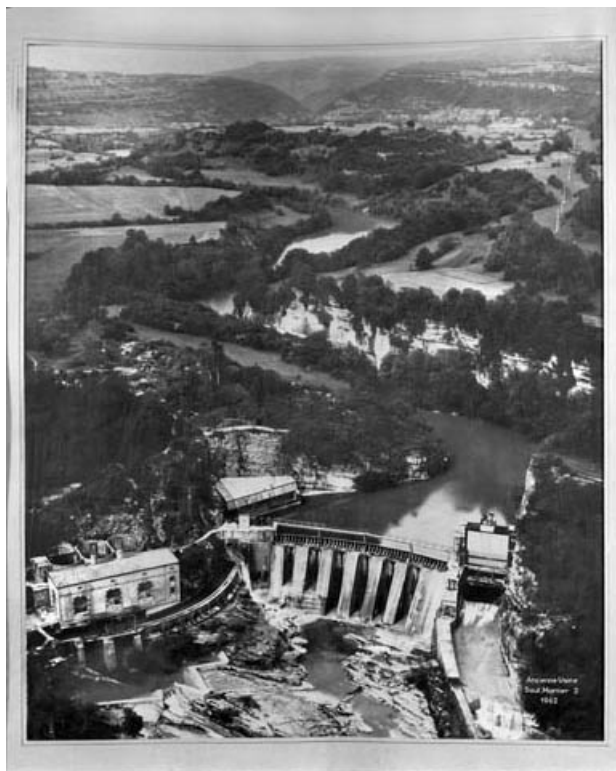
Ancienne Usine Saut-Mortier 2 [vue aérienne].
