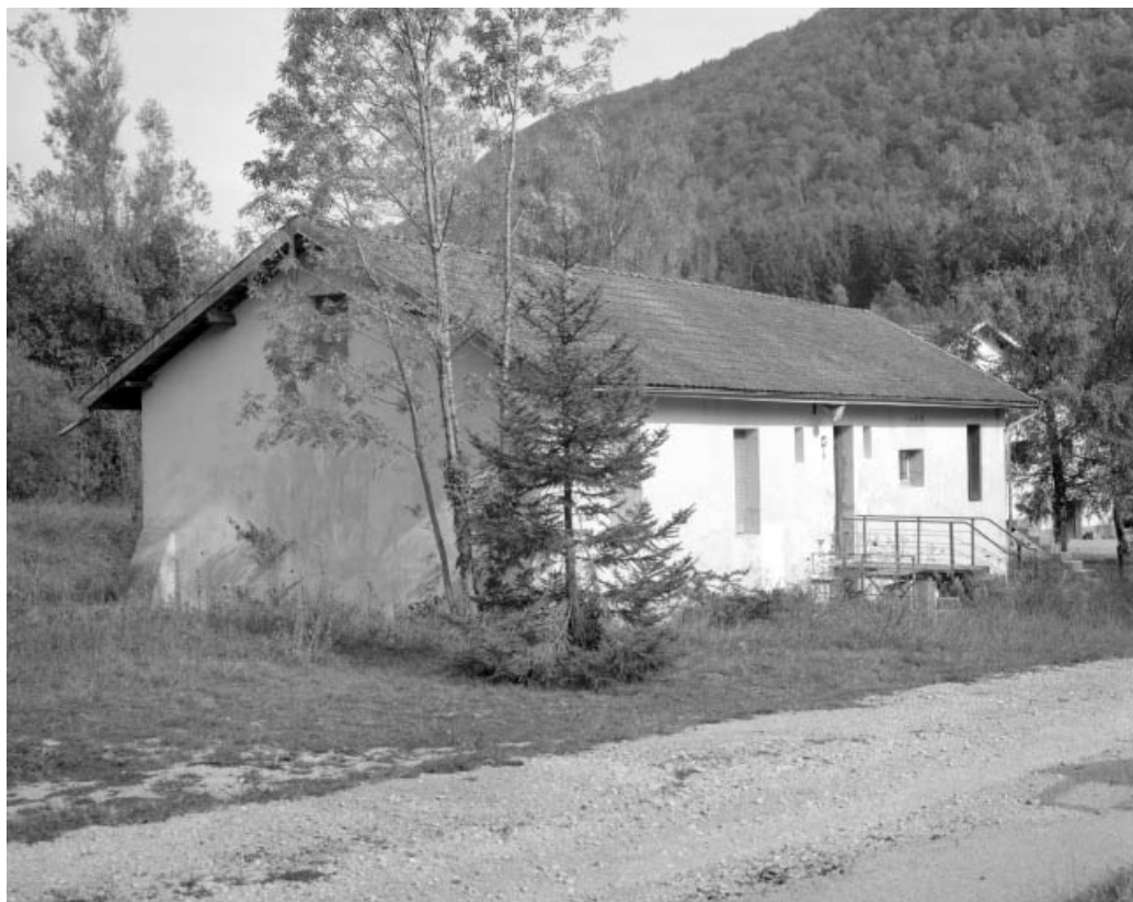
Logement d'ouvriers, vu de trois quarts gauche.
