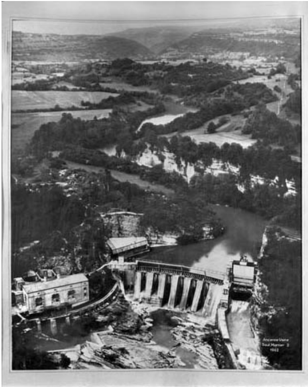
Ancienne Usine Saut-Mortier 2 [vue aérienne].
