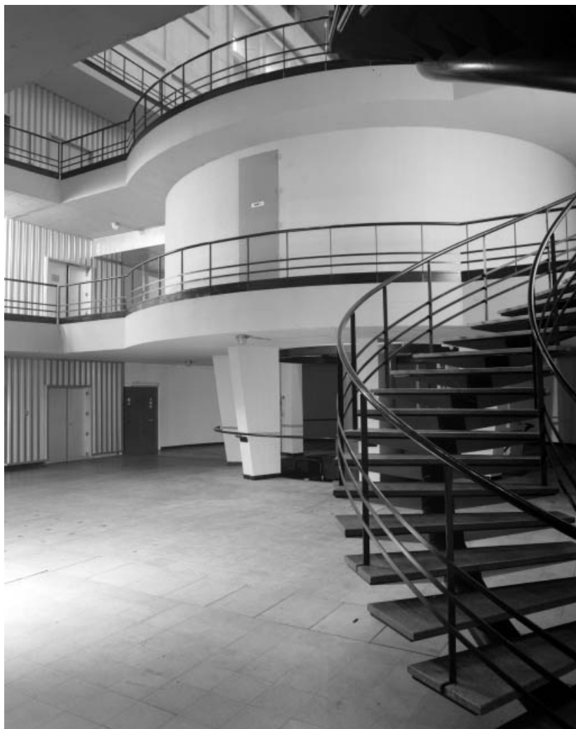
Intérieur de la centrale : escalier, pivoterie et alternateur du 2e groupe. 39, Cernon, lieudit : le Saut-Mortier
