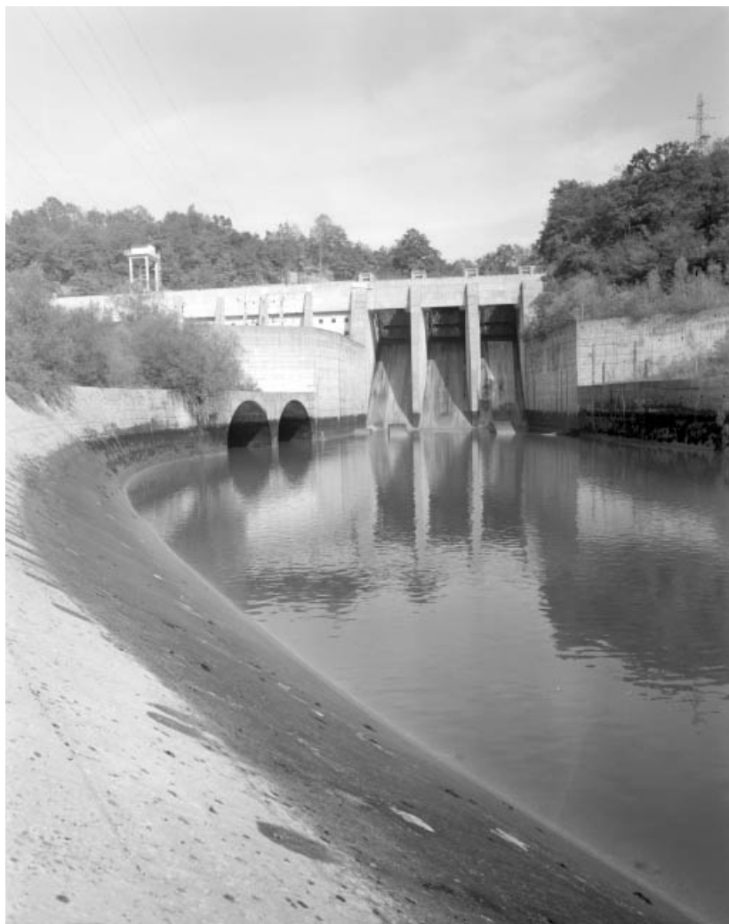
Evacuateur et bassin d'amortissement (cadrage vertical).
