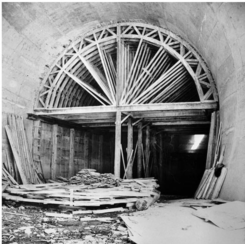
Canal de fuite G.2 - Dernière phase amont - Vue du coffrage.
