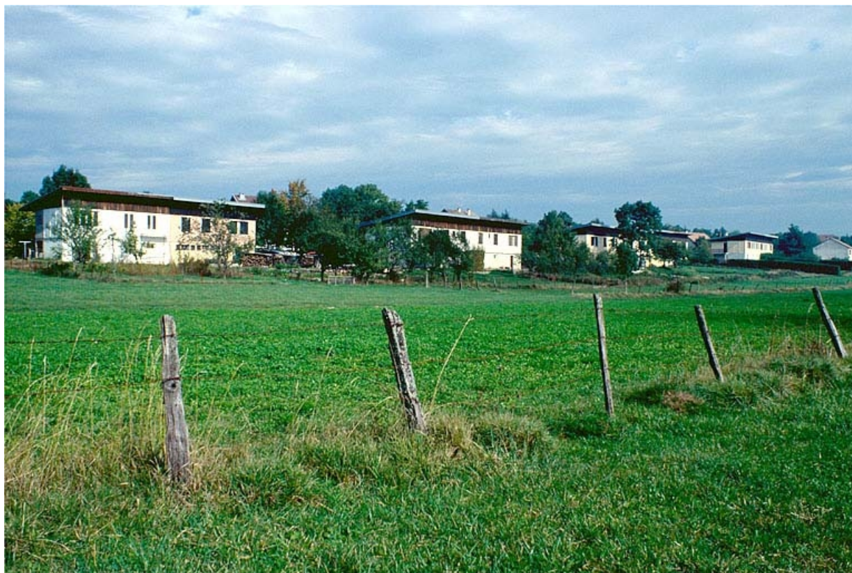
Vue d'ensemble de la maison et de la cité des Lattes, depuis le sud.
