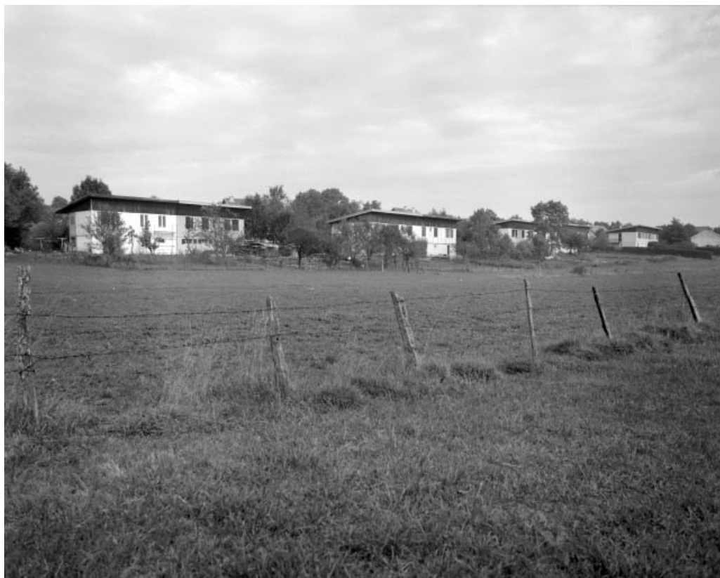
Vue d'ensemble de la maison et de la cité des Lattes, depuis le sud.
