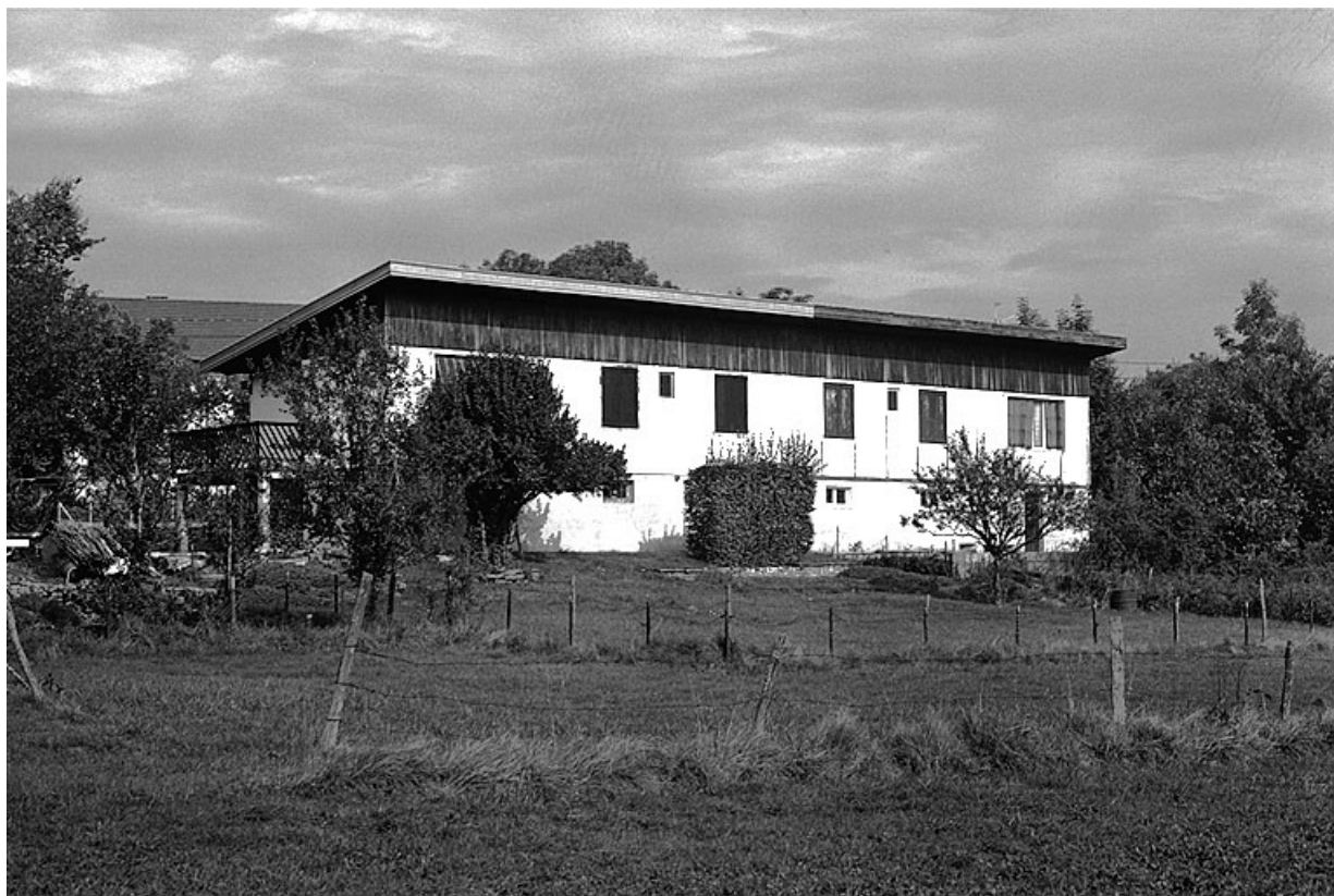
Façade postérieure d'une autre maison de la série. Maison cadastrée 1984 AC 347,349.
