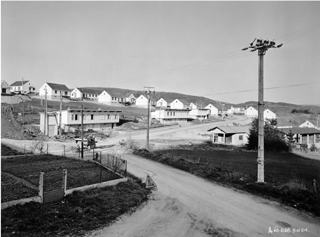
Cité du Closey à Orgelet. Vue générale.
