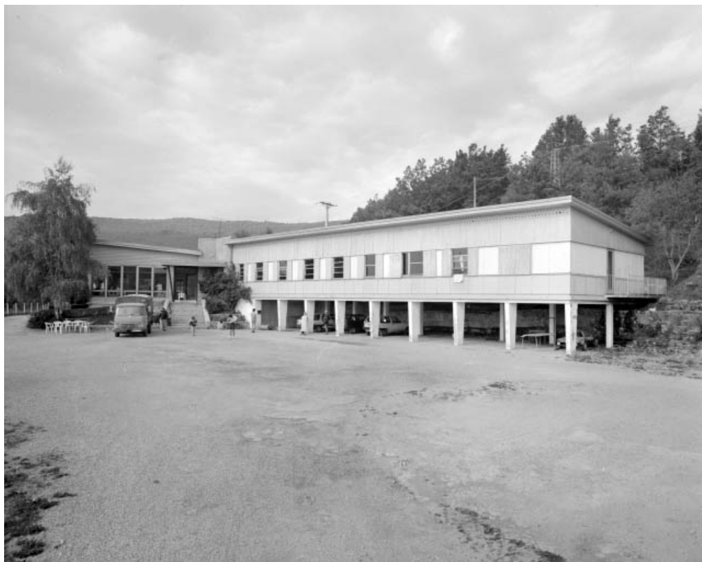
Ancienne cantine. Cantine-foyer à gauche, logement d'ouvriers à droite. 39, Cernon
