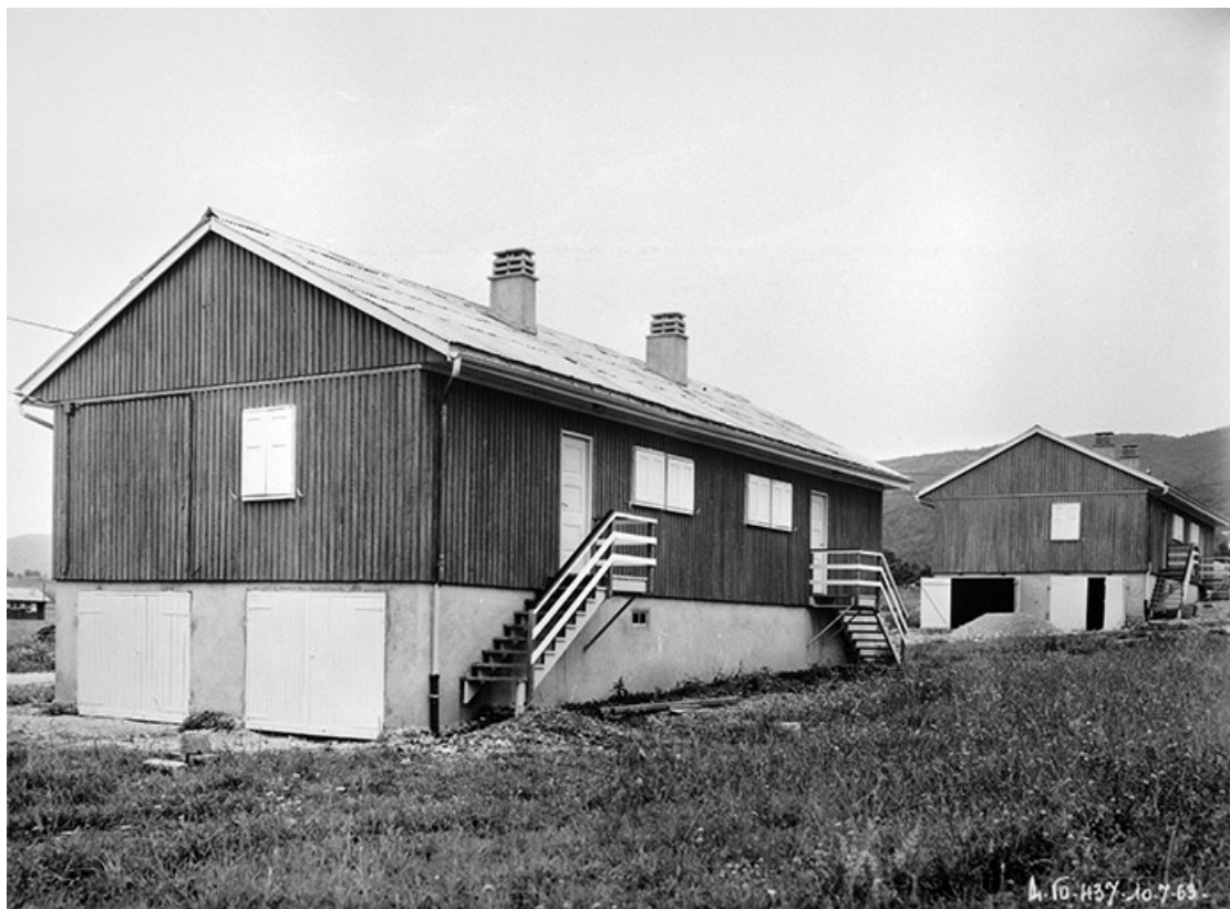
Cité de Vouglans. Logements R.B.M. 39, Cernon
