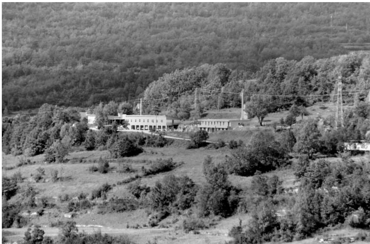
Vue d'ensemble de l'ancienne cantine et de l'ancien logement d'ouvriers. 39, Cernon
