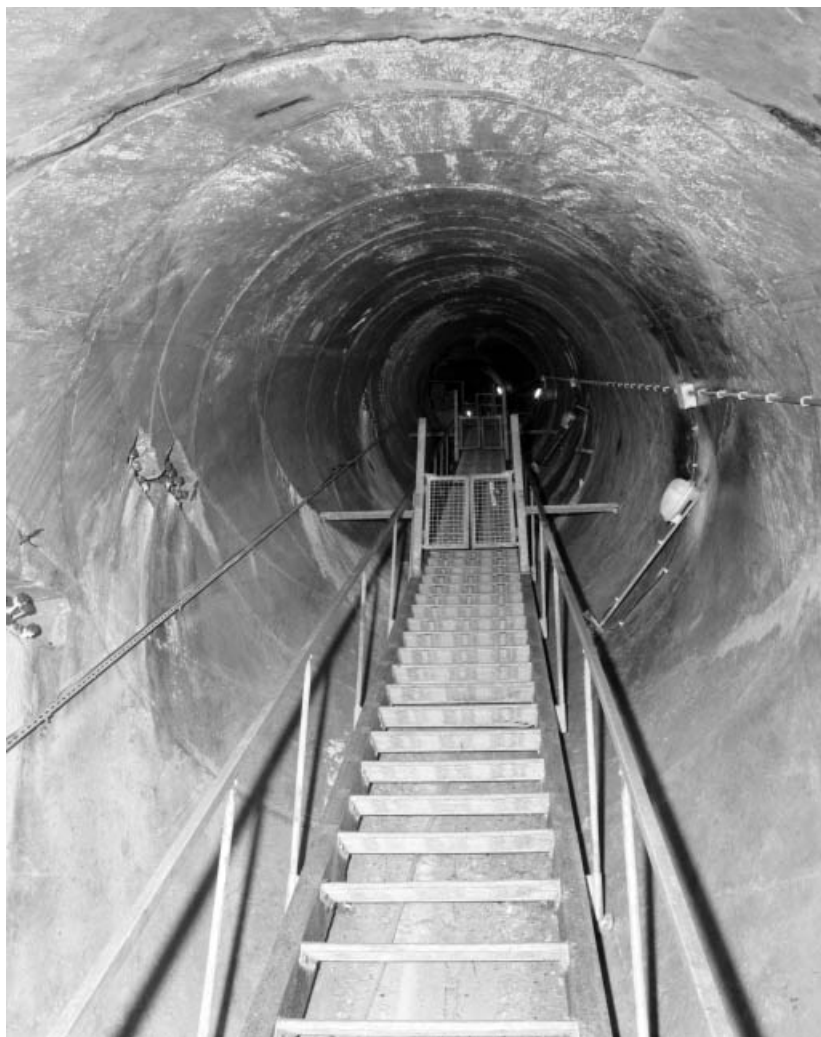
"Galerie de pied". Galerie de circulation longitudinale qui descend jusqu'à la base du barrage. 39, Cernon, lieudit : Barrage de Vouglans
