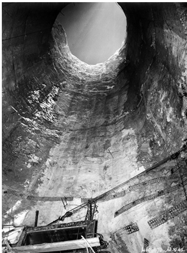
Puits 1-2, sommet entonnement 1.
