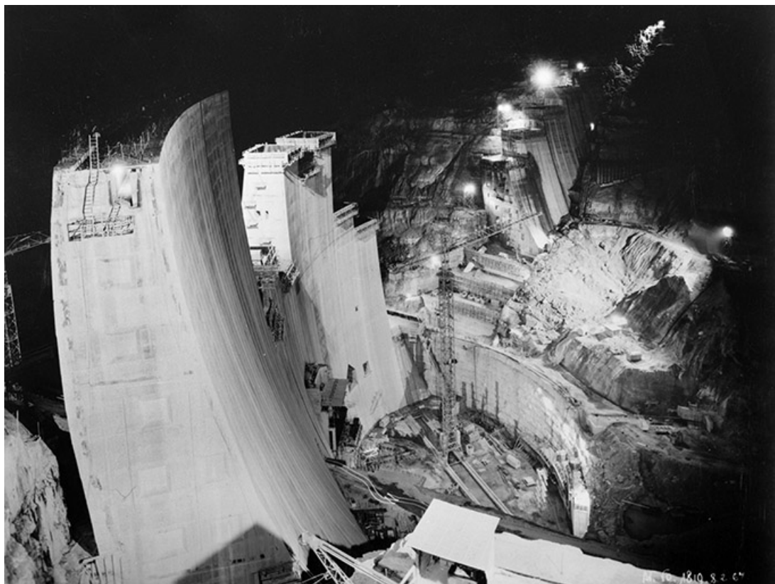
Barrage - Vue générale depuis R.D. aval des plots en cours de bétonnage (de nuit).
