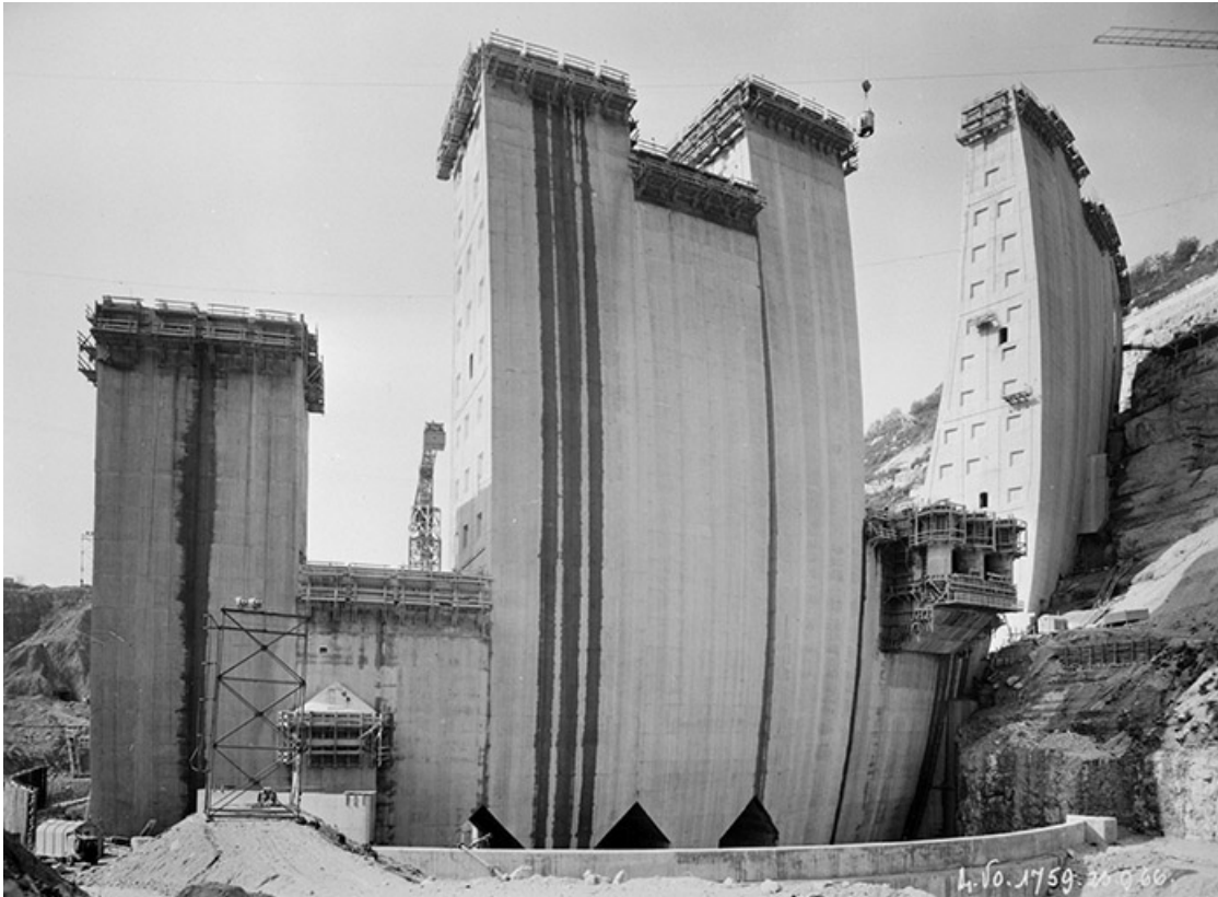
Barrage - Vue d'ensemble des plots PQ à CD - Vue de l'amont.
