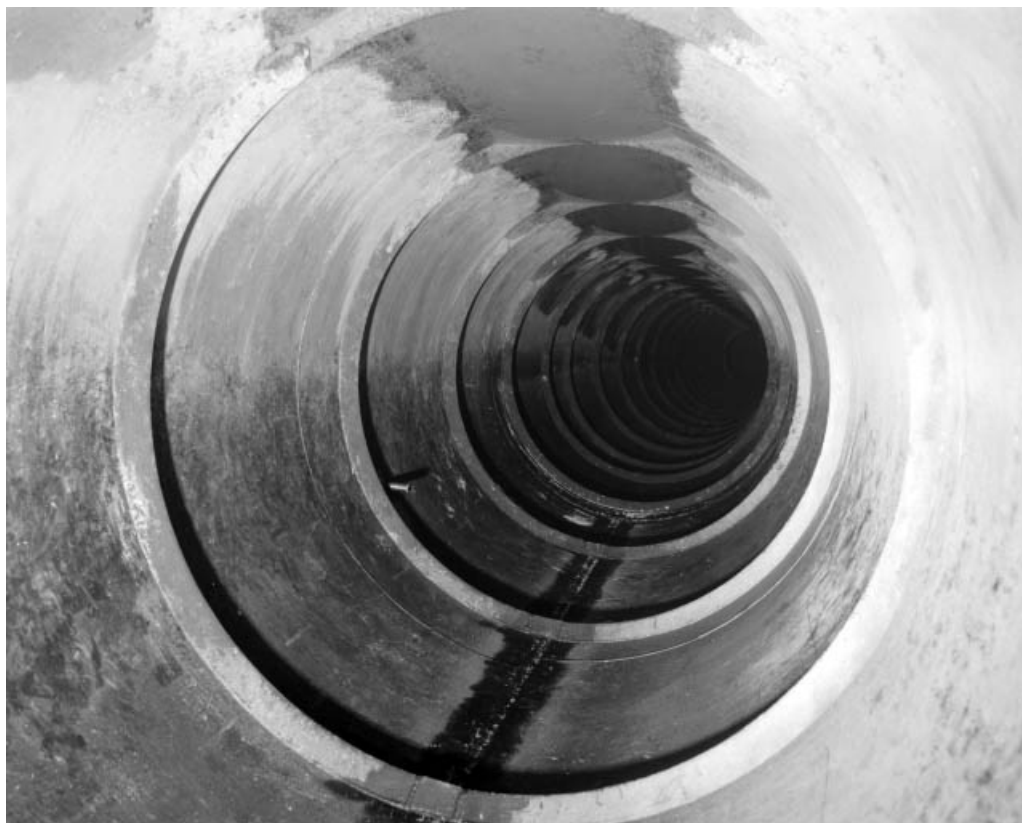
Tunnel de jonction du barrage avec la rive droite.
