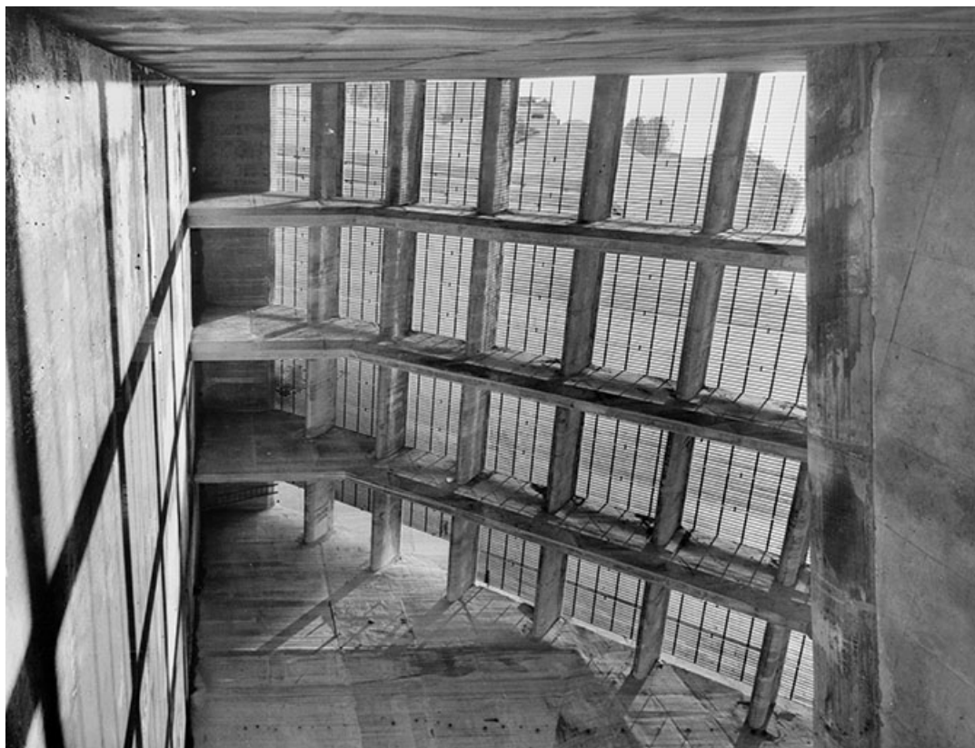
Prise d'eau - Grilles - Poutres et vannes - Vue de l'intérieur.
