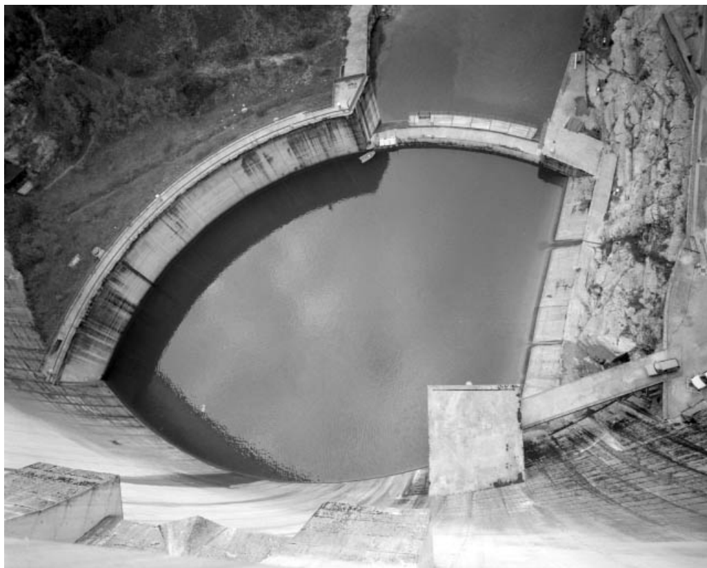
Vue plongeante sur le bassin d'amortissement.
