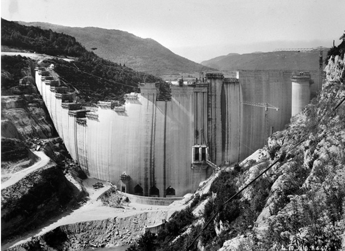
Barrage - Vue générale amont.
