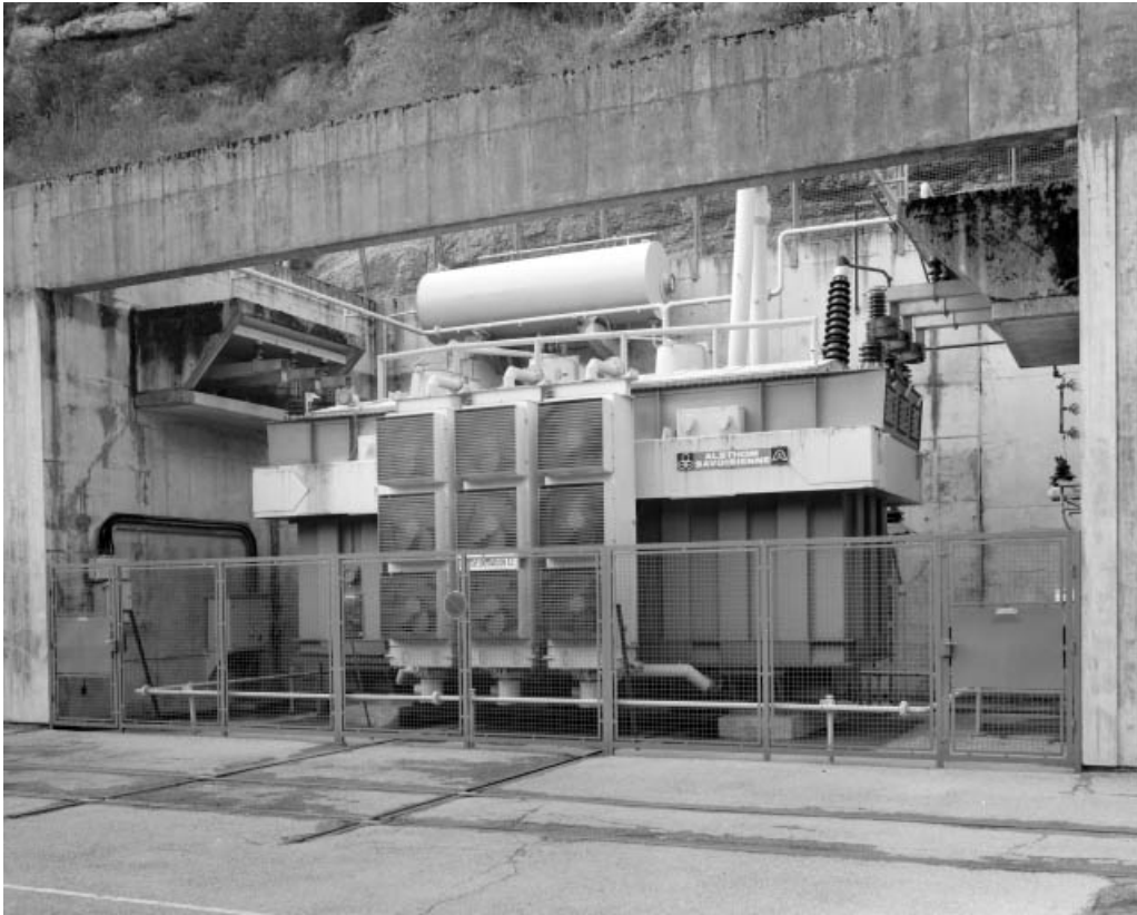
Transformateur Alsthom de 160 MVA.
