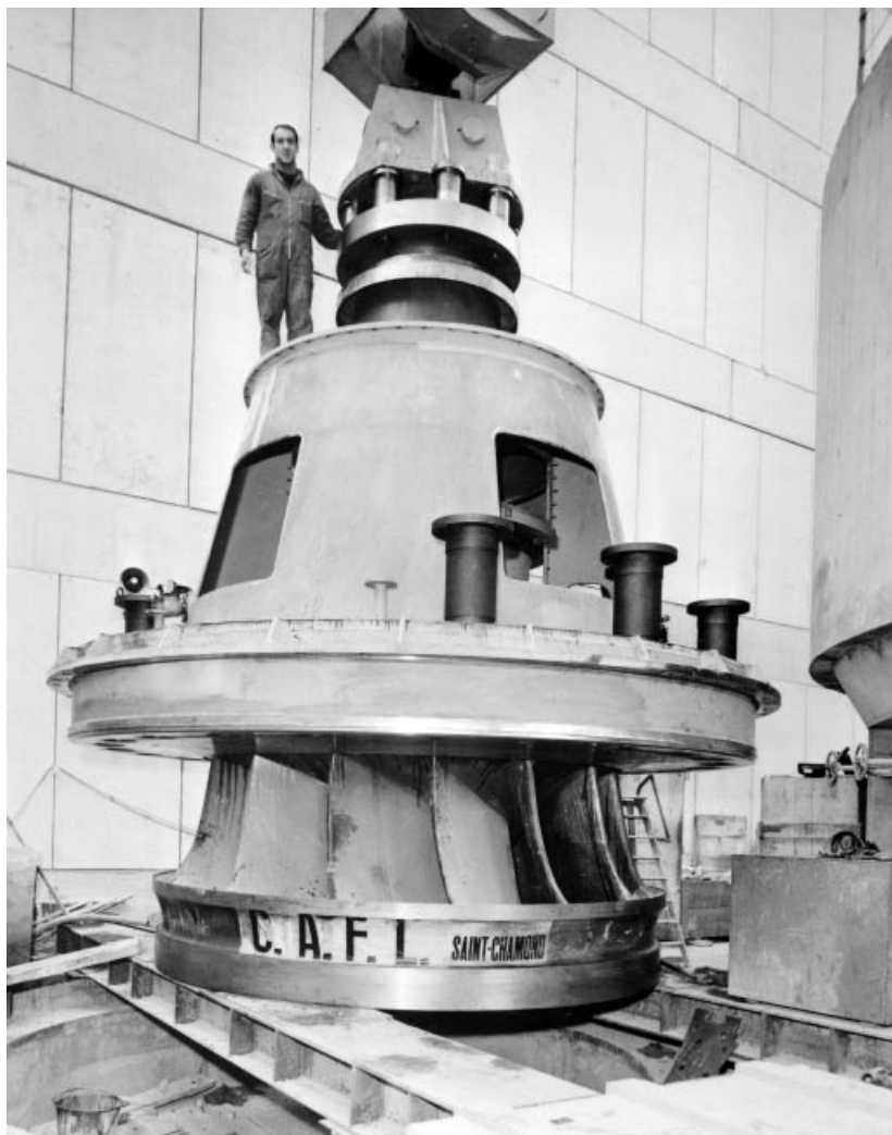
Roue turbine : support pivoterie en cours de montage.
