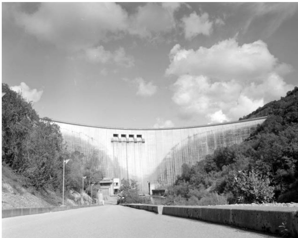
Le barrage, vu d'aval et au grand angle.
