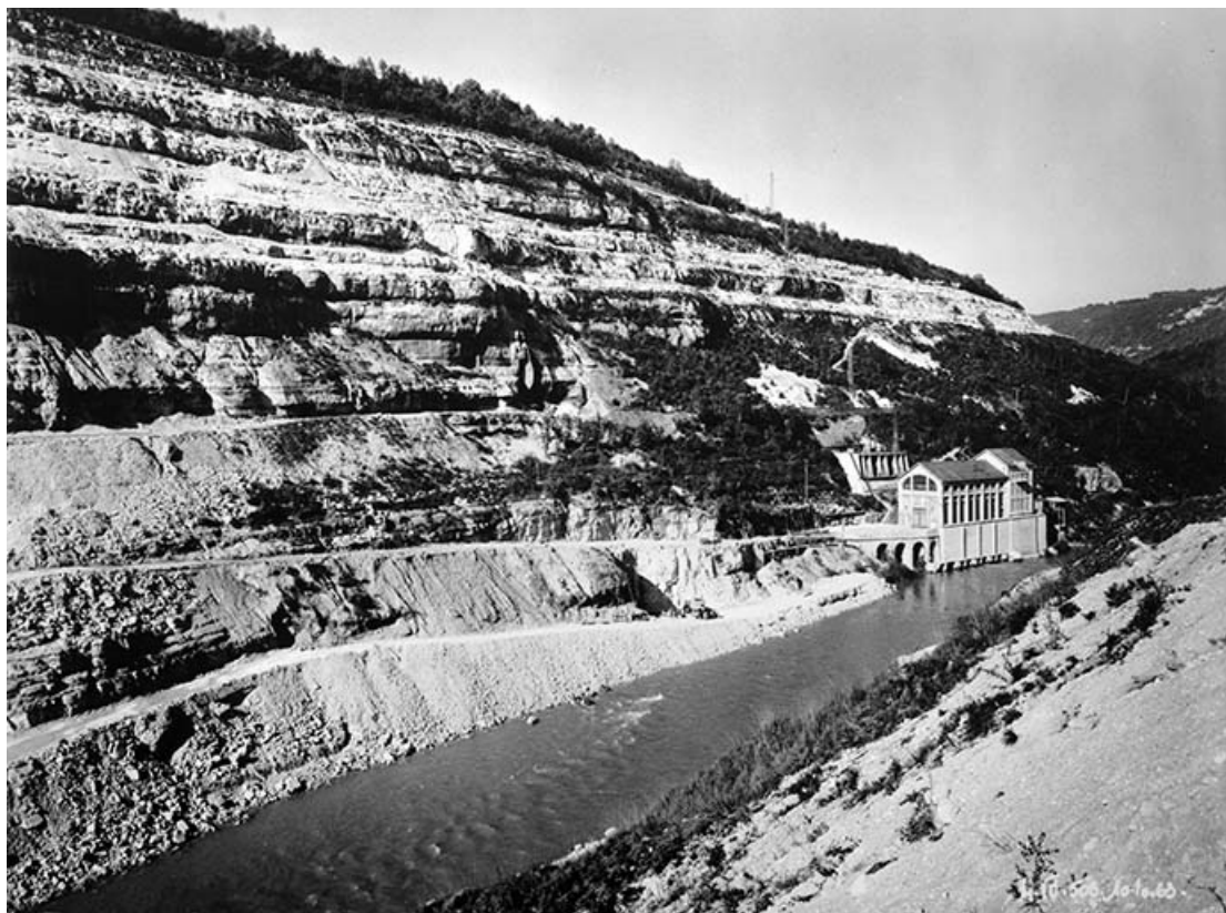
Amont de l'appui rive droite. Tête amont de la dérivation provisoire [et centrale de la chartreuse de Vaucluse]. 39, Cernon, lieudit : Barrage de Vouglans
