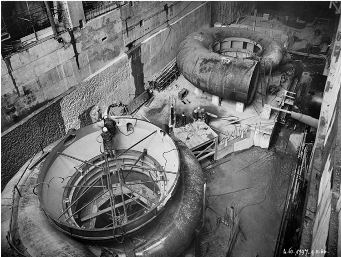
Centrale - Bâches groupe I et II.
