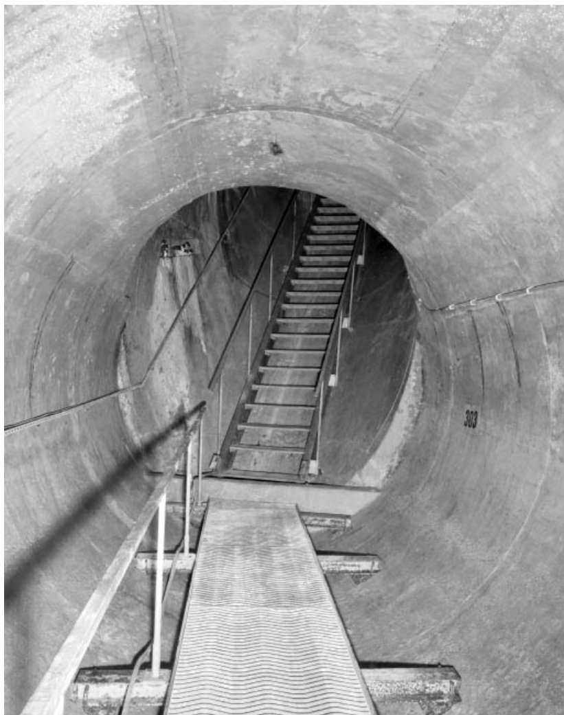
Extrémité inférieure de la "galerie de pied".
