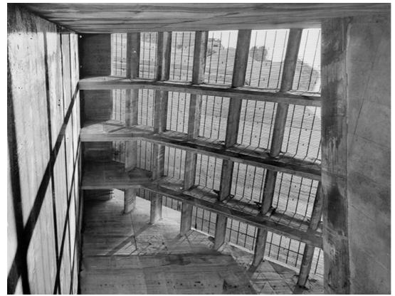
Prise d'eau - Grilles - Poutres et vannes - Vue de l'intérieur.
