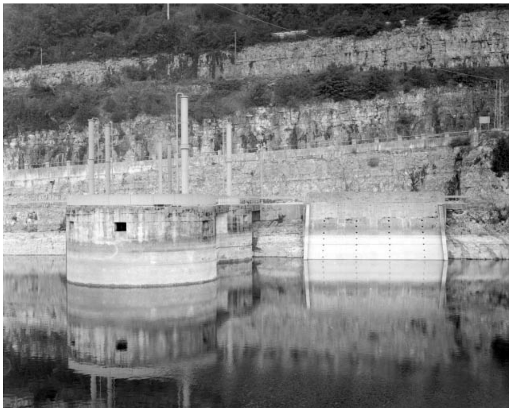
Tours et dalle de béton surmontant la grille de prise d'eau.
