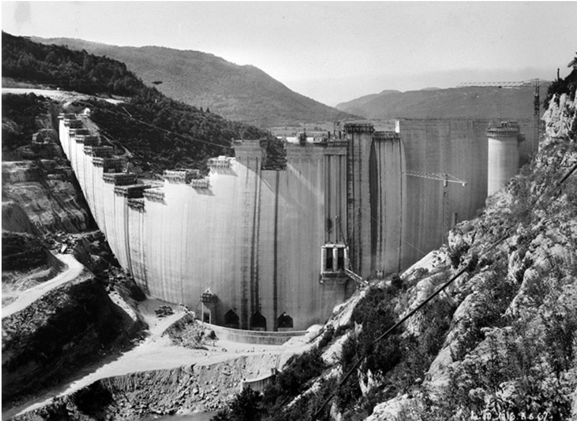
Barrage - Vue générale amont.
