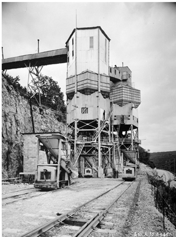
Tour à béton et silobus.
