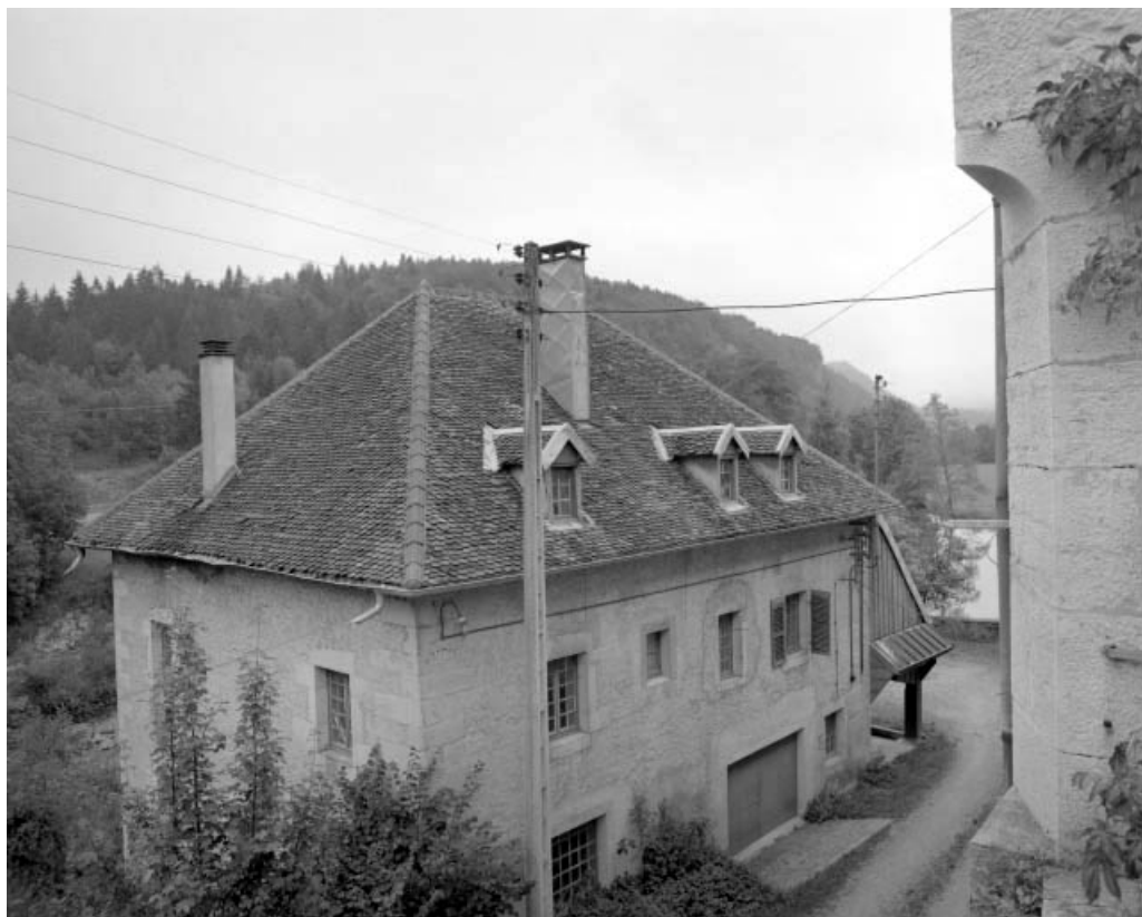
Moulin : façades antérieure et latérale droite, vues en plongée.
