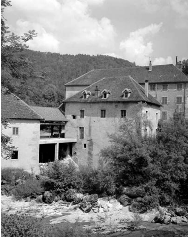
Moulin : façade latérale gauche.
