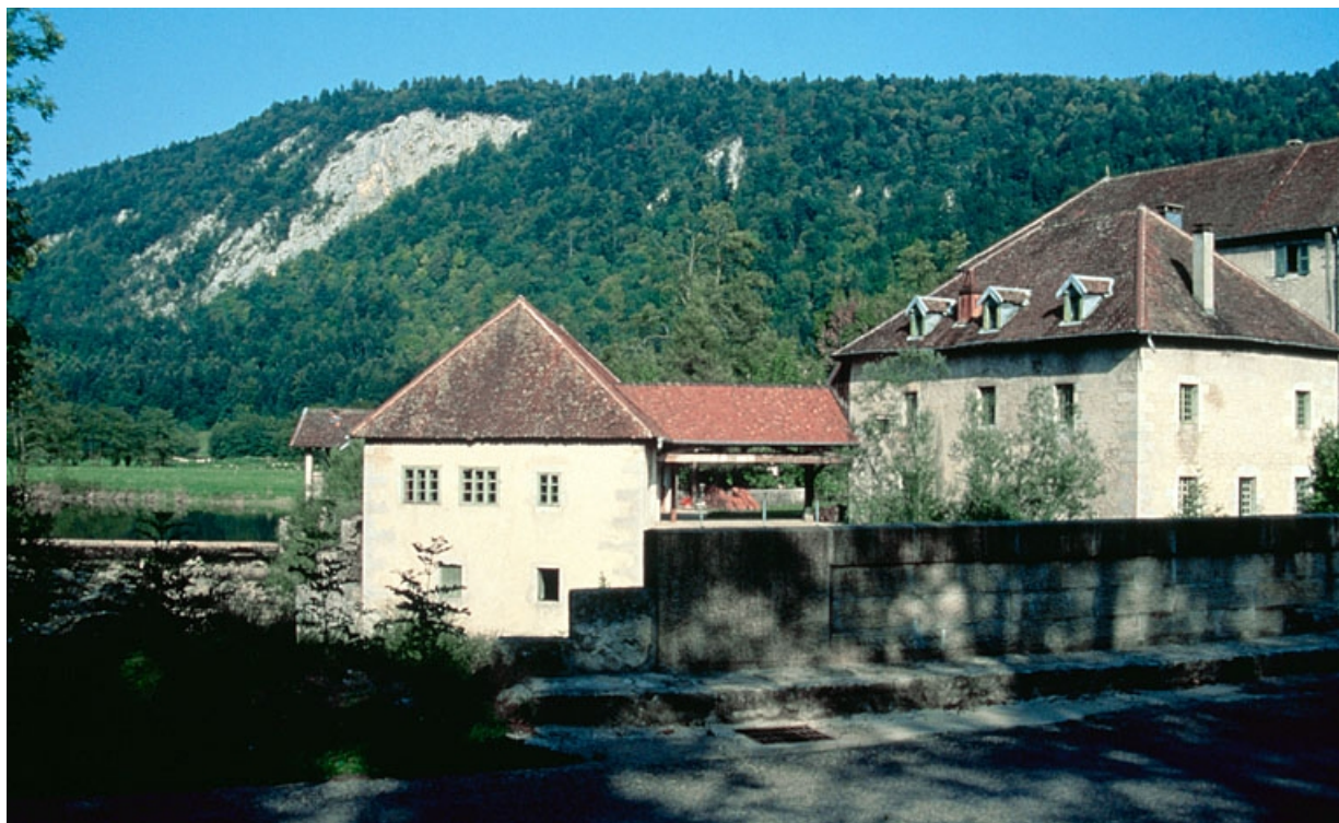
Vue d'ensemble depuis le pont, à l'ouest.
