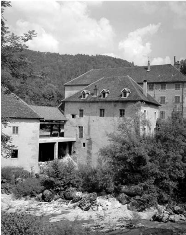
Moulin : façade latérale gauche.
