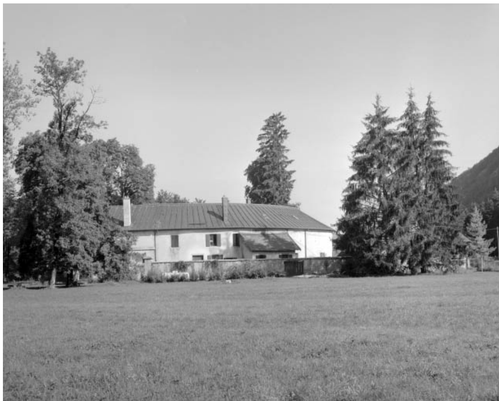
Vue rapprochée de la façade postérieure de la ferme.
