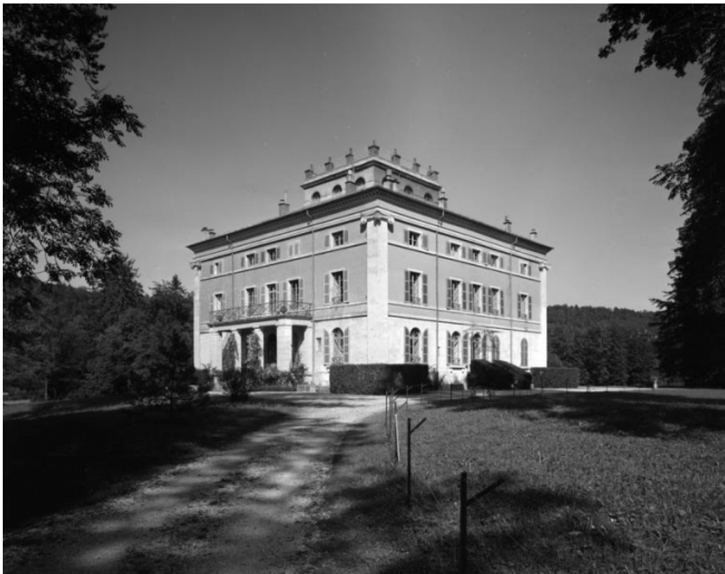
Vue éloignée des façades sud et est depuis l'allée sud-est du parc.
