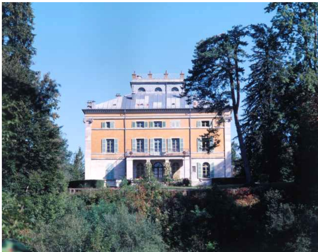
Vue de la façade sud depuis le parc, de face.
