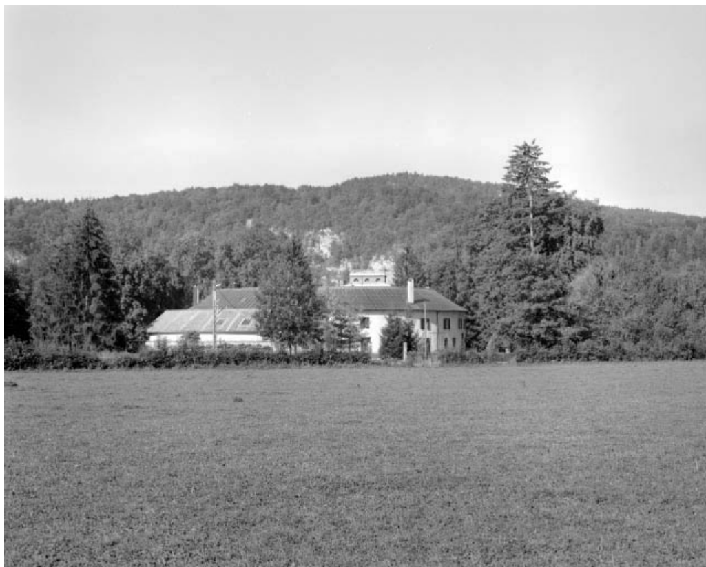
Vue éloignée de la façade postérieure de la ferme.
