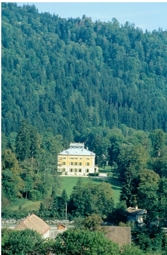
Vue d'ensemble de la demeure, depuis la voie ferrée.
