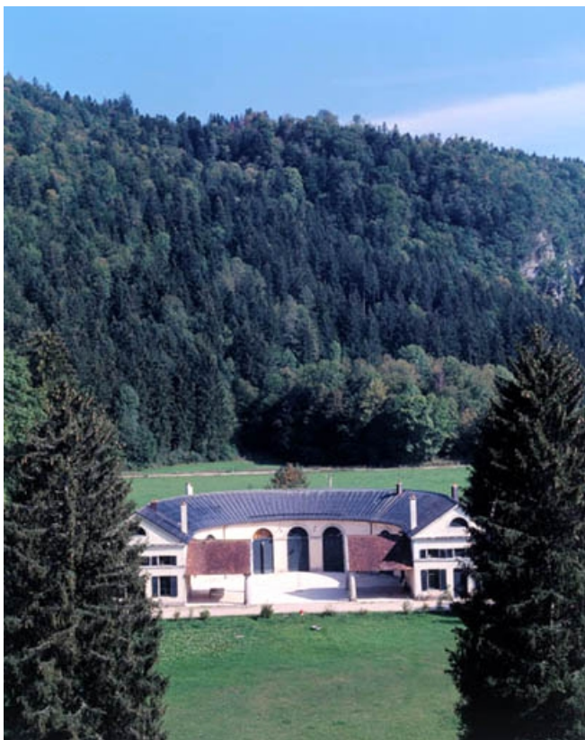
Vue rapprochée de la ferme depuis le toit de la demeure.
