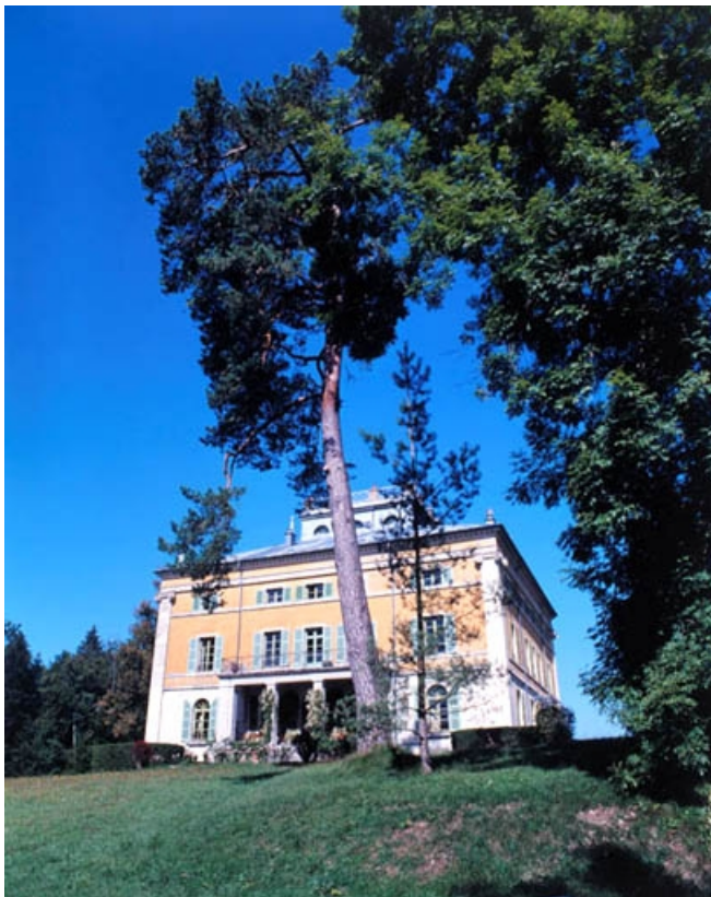
Vue de la façade sud en contre-plongée depuis le parc.
