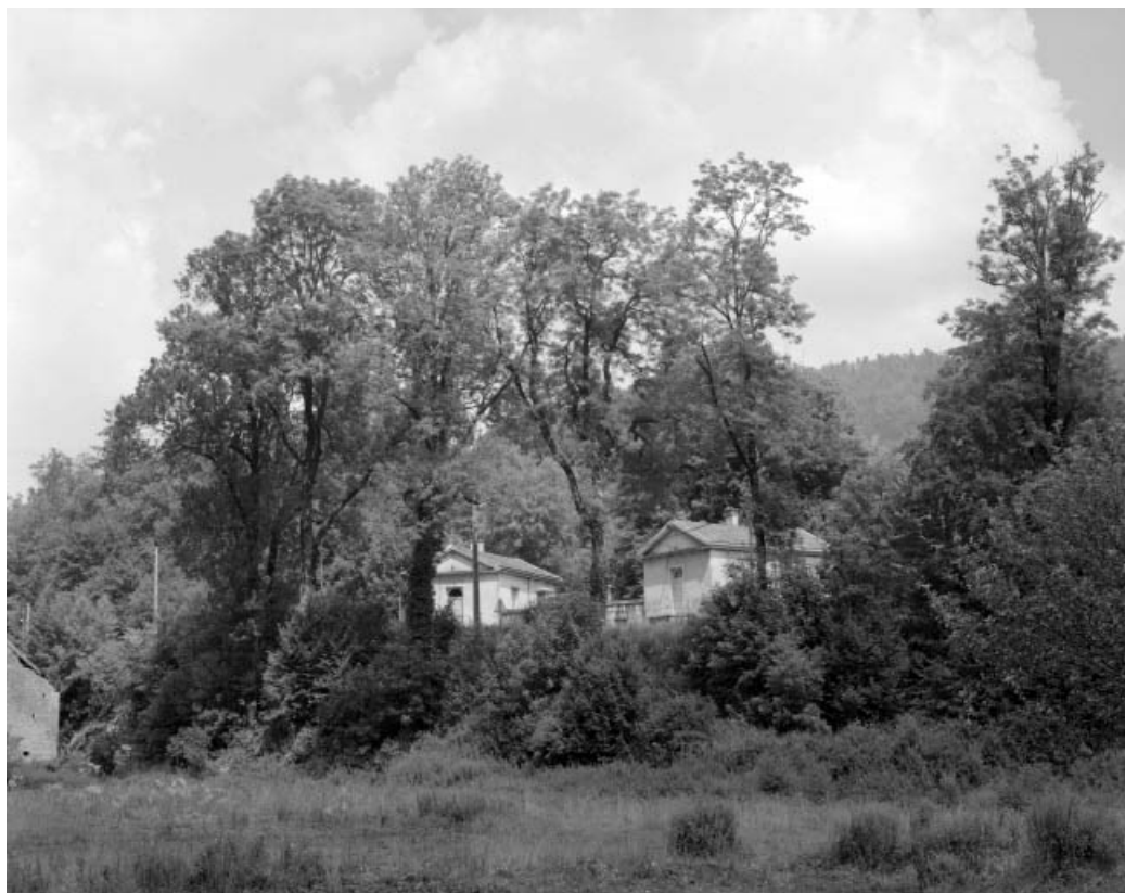
Vue éloignée des pavillons d'entrée, de trois quarts droit.
