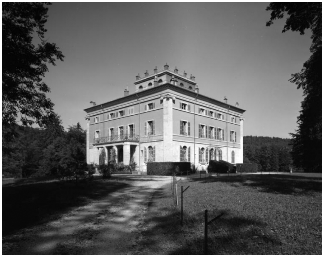
Vue éloignée des façades sud et est depuis l'allée sud-est du parc.
