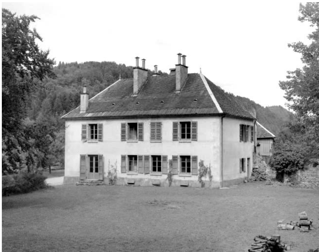
Façade latérale droite de l'habitation, vue rapprochée.
