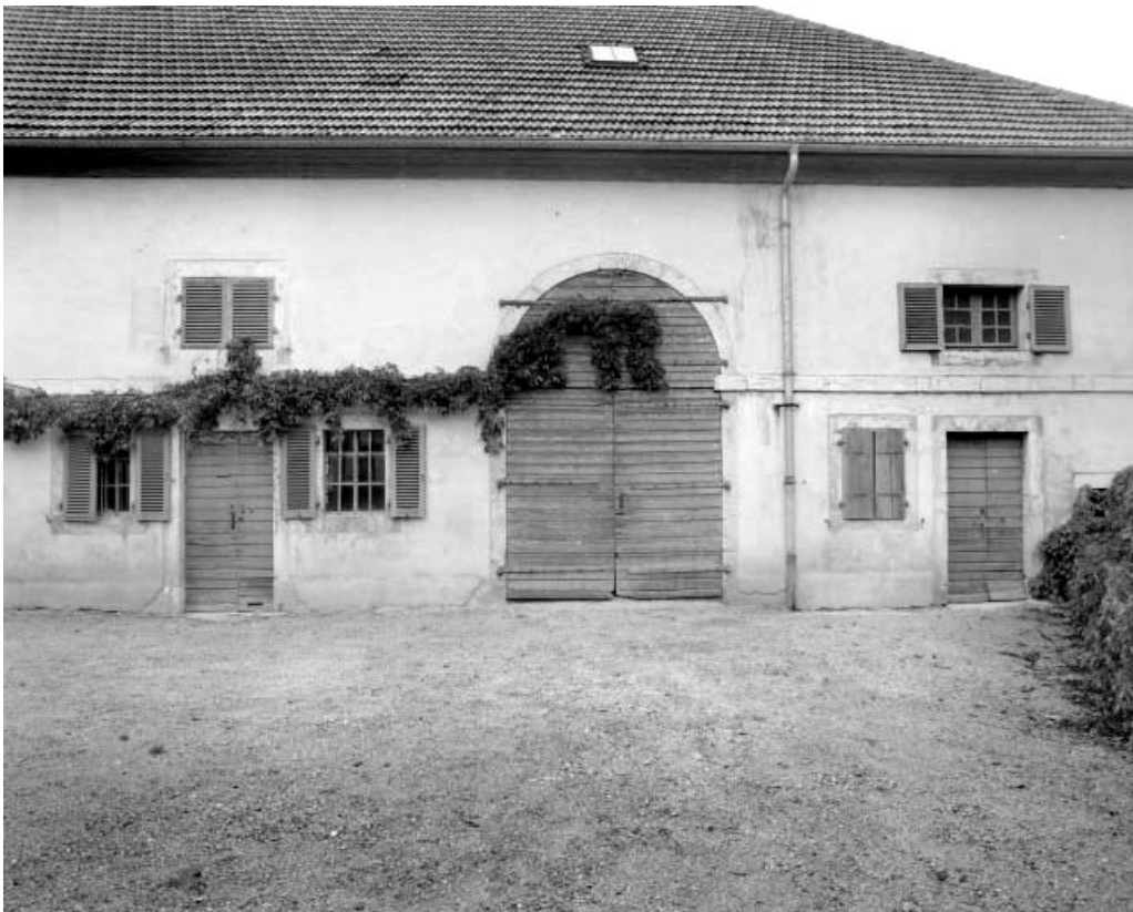
Bâtiment des communs : détail d'une partie de la façade antérieure.
