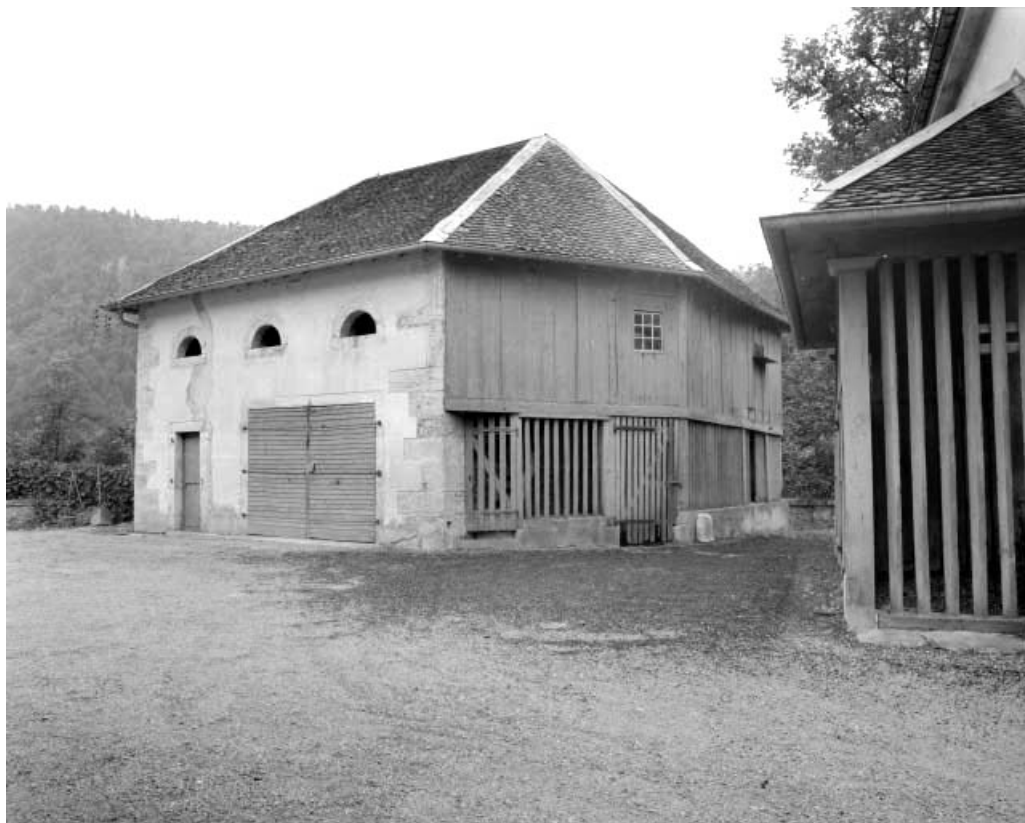
Vue d'ensemble de trois quarts droit du bâtiment regroupant remise, pigeonnier et bûcher.
