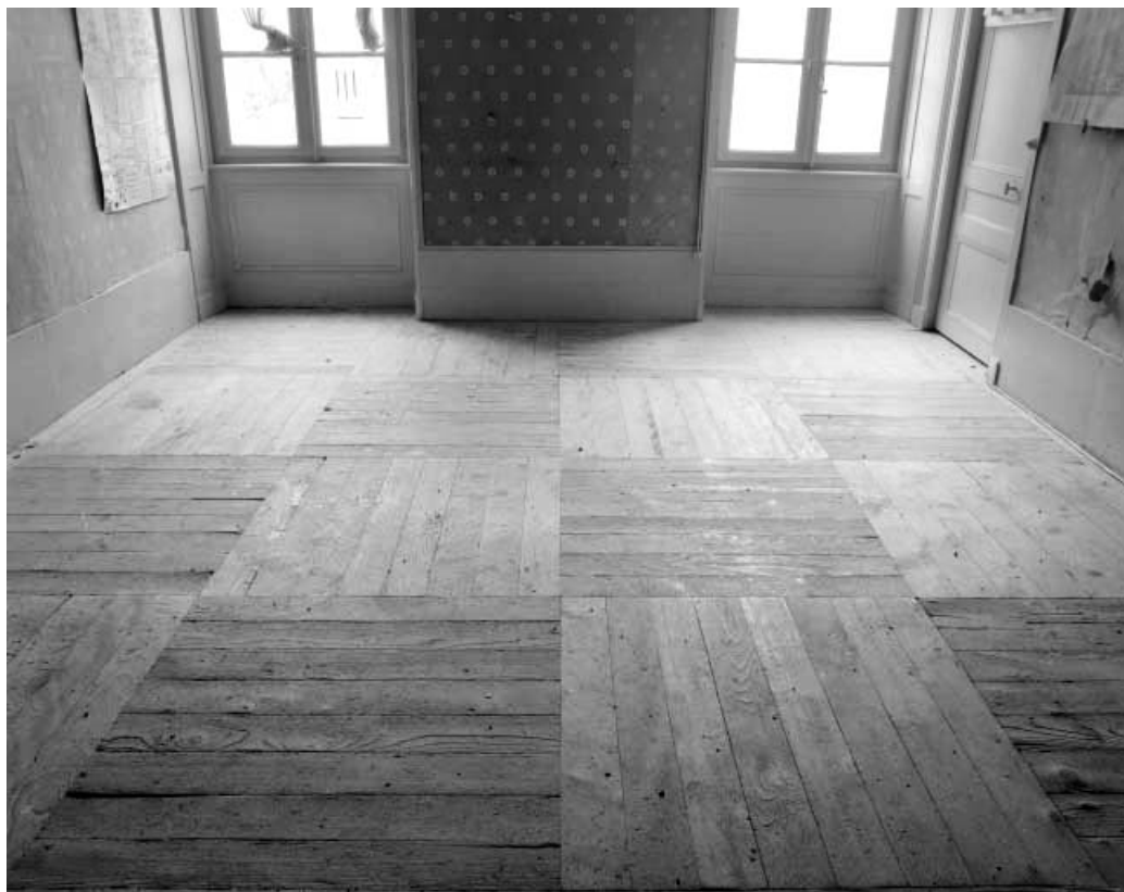
Intérieur de l'habitation : pièce en rez de chaussée à droite de l'escalier : détail du plancher.
