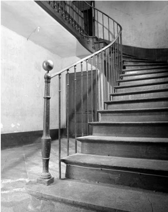
Intérieur de l'habitation : détail du départ de l'escalier principal. 39, Syam 1ère demeure d'industriel, lieudit : les Forges
