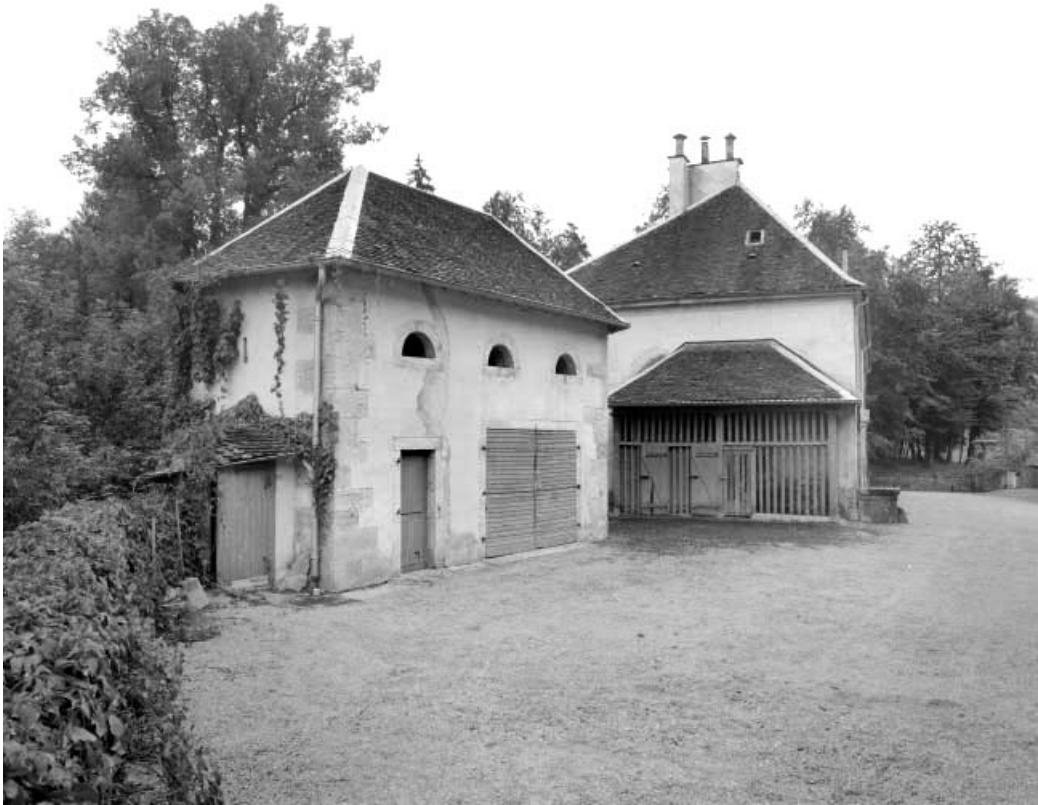
Remise pigeonnier et bûcher de trois quarts gauche depuis le fond de la cour des communs. 39, Syam 1ère demeure d'industriel, lieudit : les Forges
