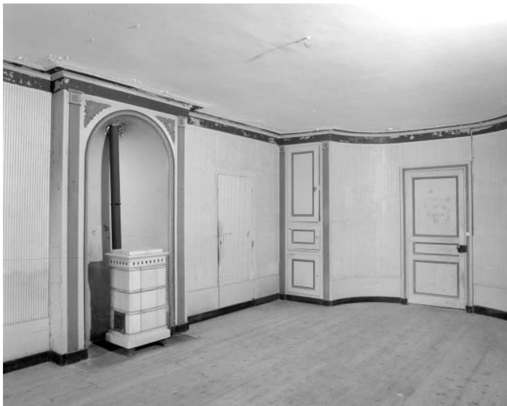
Intérieur de l'habitation : salle à manger, mur nord. 39, Syam 1ère demeure d'industriel, lieudit : les Forges
