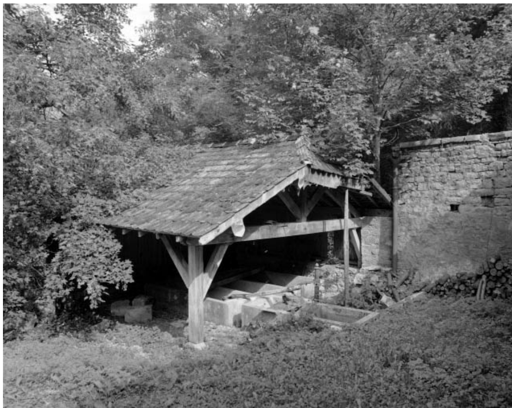
Vue d'ensemble du lavoir de trois quarts gauche.
