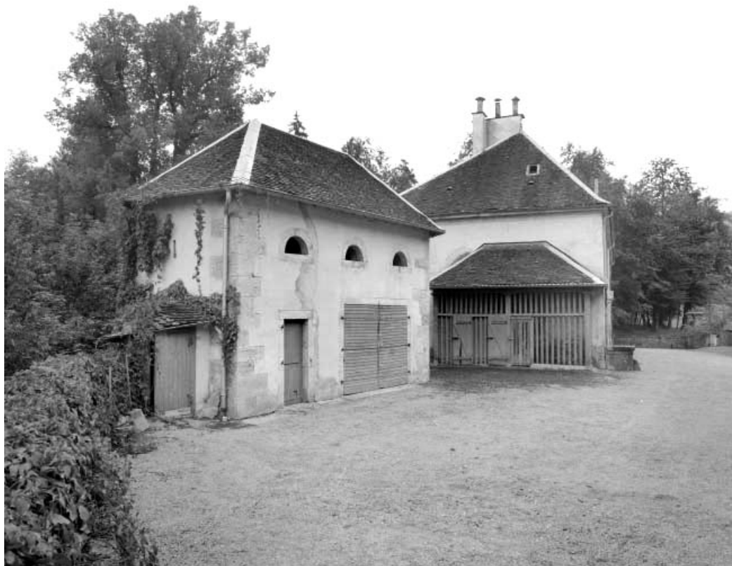
Remise pigeonnier et bûcher de trois quarts gauche depuis le fond de la cour des communs.
