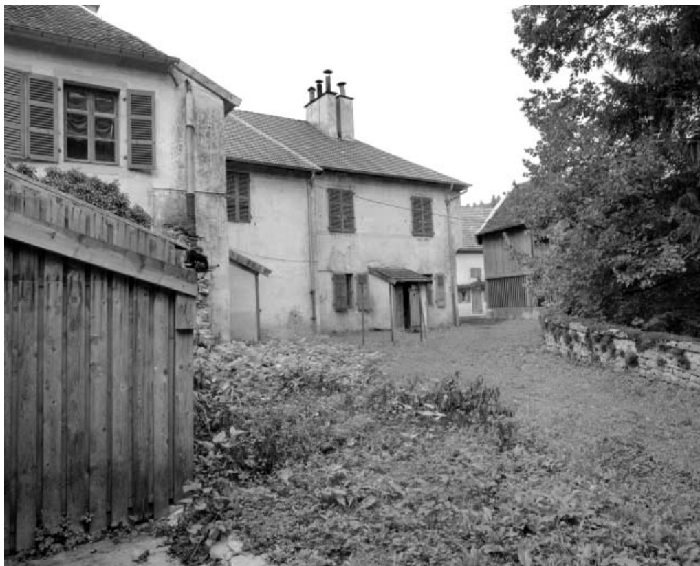
Partie droite de la façade postérieure de l'habitation, vue de trois quarts gauche.
