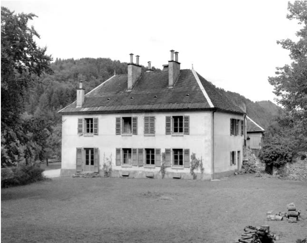
Façade latérale droite de l'habitation, vue rapprochée.
