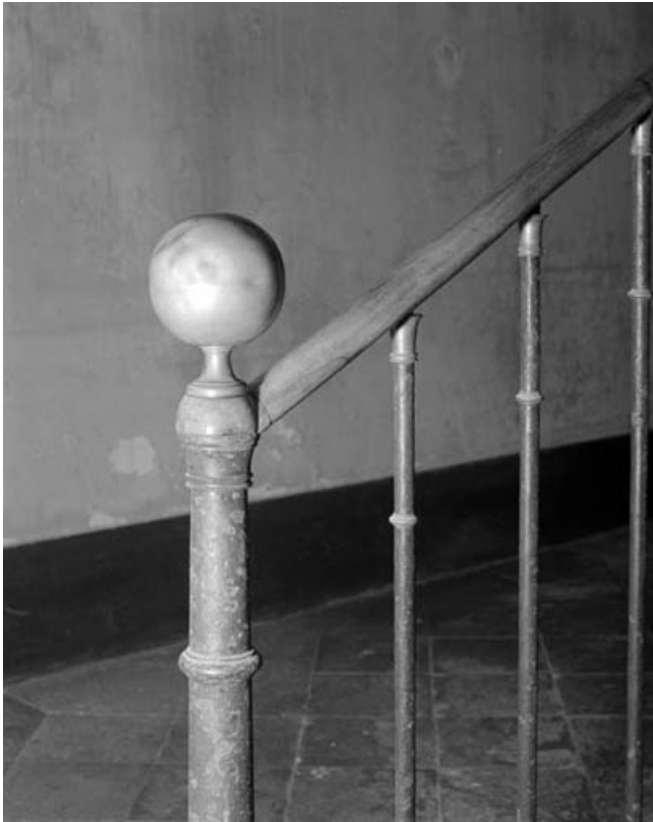
Intérieur de l'habitation : détail du départ de la rampe d'appui de l'escalier principal. 39, Syam 1ère demeure d'industriel, lieudit : les Forges
