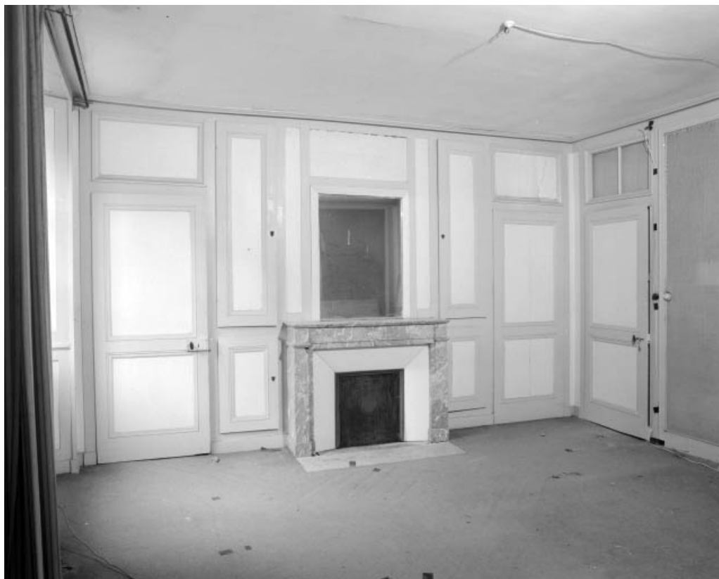
Intérieur de l'habitation : chambre du premier étage donnant au sud, détail de la cheminée. 39, Syam 1ère demeure d'industriel, lieudit : les Forges
