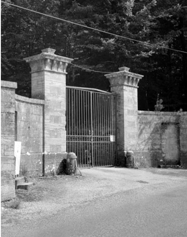
Vue du portail d'entrée, de trois quarts gauche.
