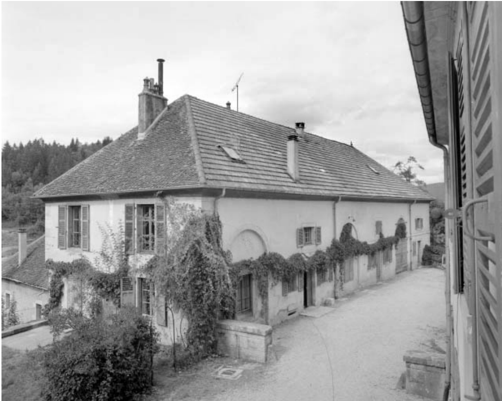
Vue d'ensemble du bâtiment des communs depuis le premier étage de l'habitation.
