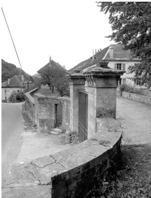
Vue du portail d'entrée et du mur d'enceinte depuis l'intérieur de la propriété.
