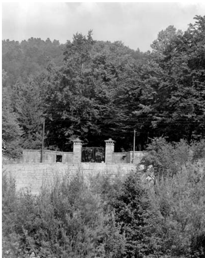
Vue éloignée du portail d'entrée, de face.
