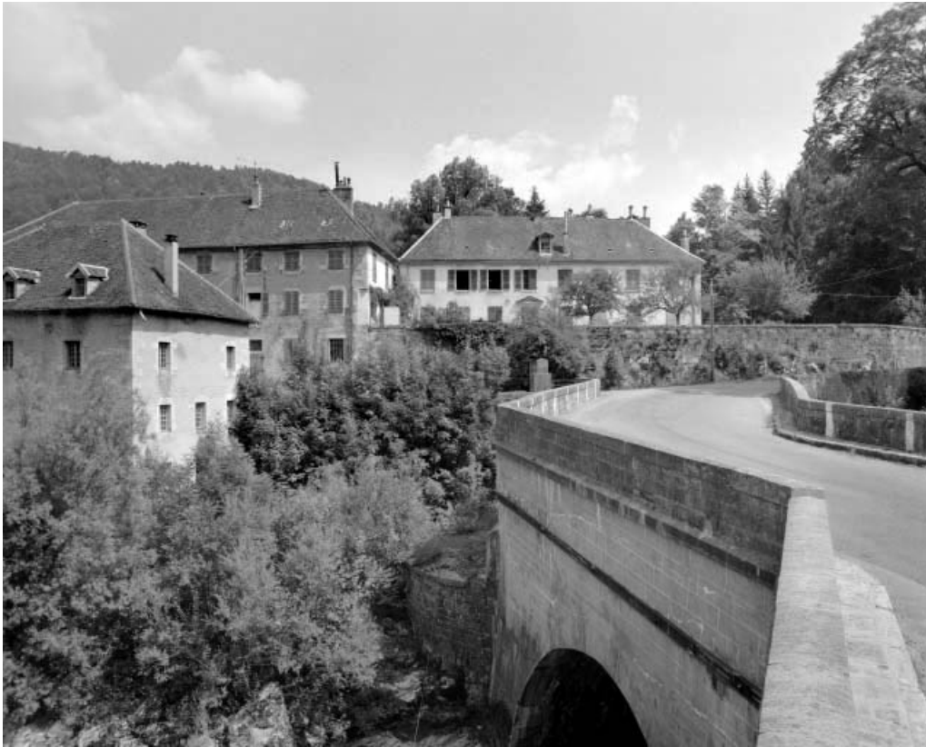
Vue d'ensemble depuis le pont, avec les bâtiments du martinet.
