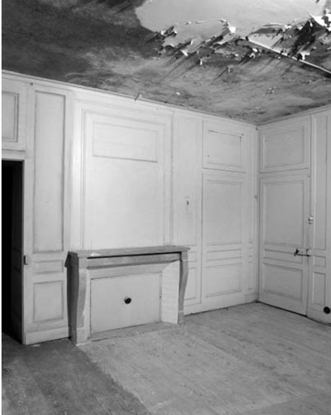
Intérieur de l'habitation : pièce en rez de chaussée, à l'angle sud-est de l'édifice. 39, Syam 1ère demeure d'industriel, lieudit : les Forges
