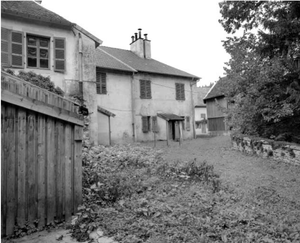
Partie droite de la façade postérieure de l'habitation, vue de trois quarts gauche.
