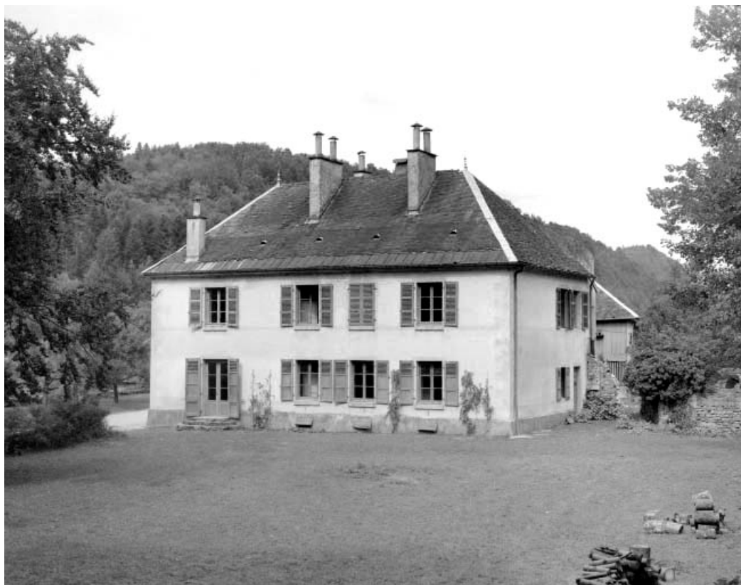
Façade latérale droite de l'habitation, vue rapprochée.
