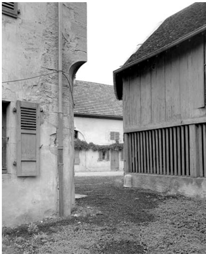
Façade postérieure de l'habitation : détail de l'angle droite, en face du bûcher. 39, Syam 1ère demeure d'industriel, lieudit : les Forges
