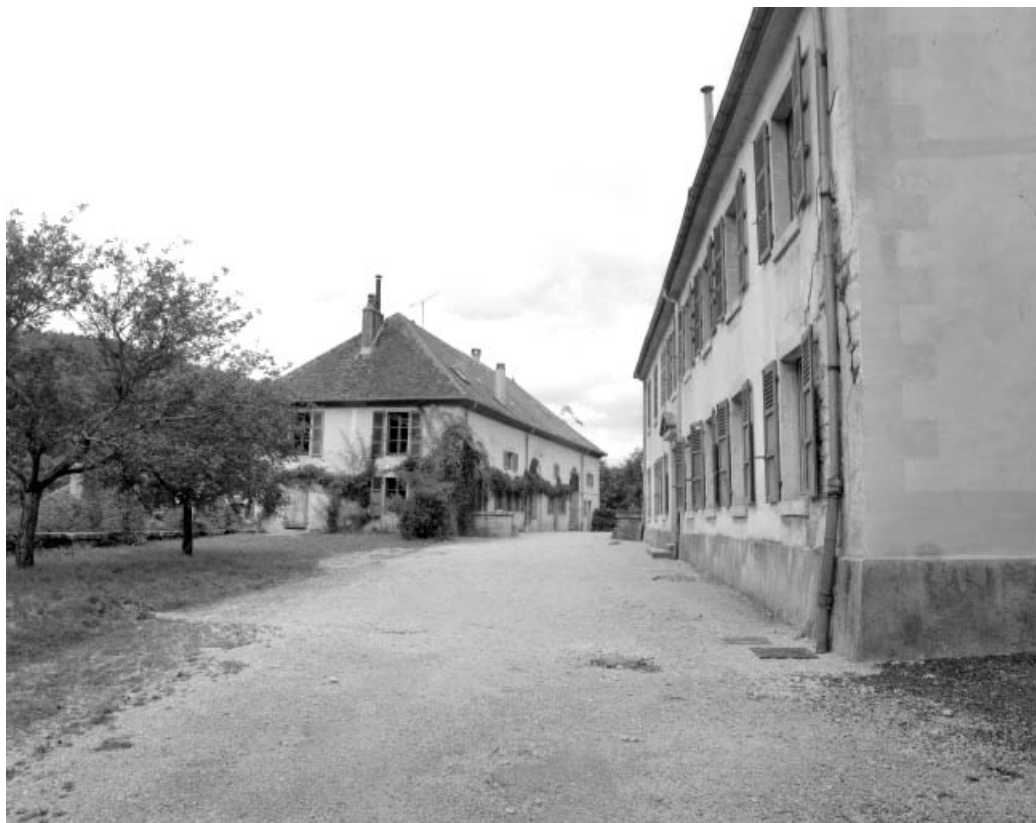
Façade antérieure de l'habitation et des communs depuis l'entrée de la cour. 39, Syam 1ère demeure d'industriel, lieudit : les Forges
