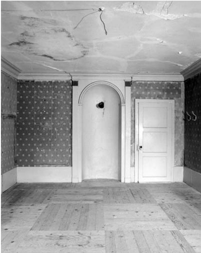
Intérieur de l'habitation : pièce en rez de chaussée, à droite de l'escalier principal, vue de la niche. 39, Syam 1ère demeure d'industriel, lieudit : les Forges
