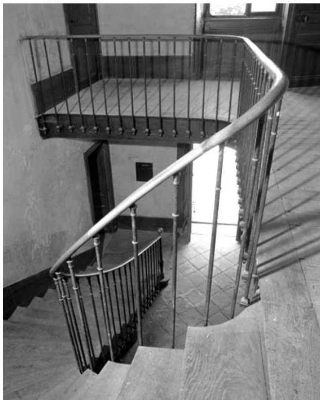
Intérieur de l'habitation : vue d'ensemble de l'escalier principal.
