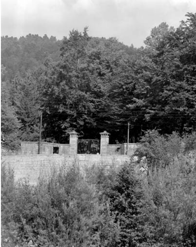
Vue éloignée du portail d'entrée, de face.
