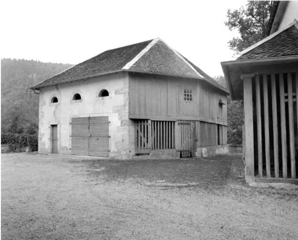
Vue d'ensemble de trois quarts droit du bâtiment regroupant remise, pigeonnier et bûcher. 39, Syam 1ère demeure d'industriel, lieudit : les Forges
