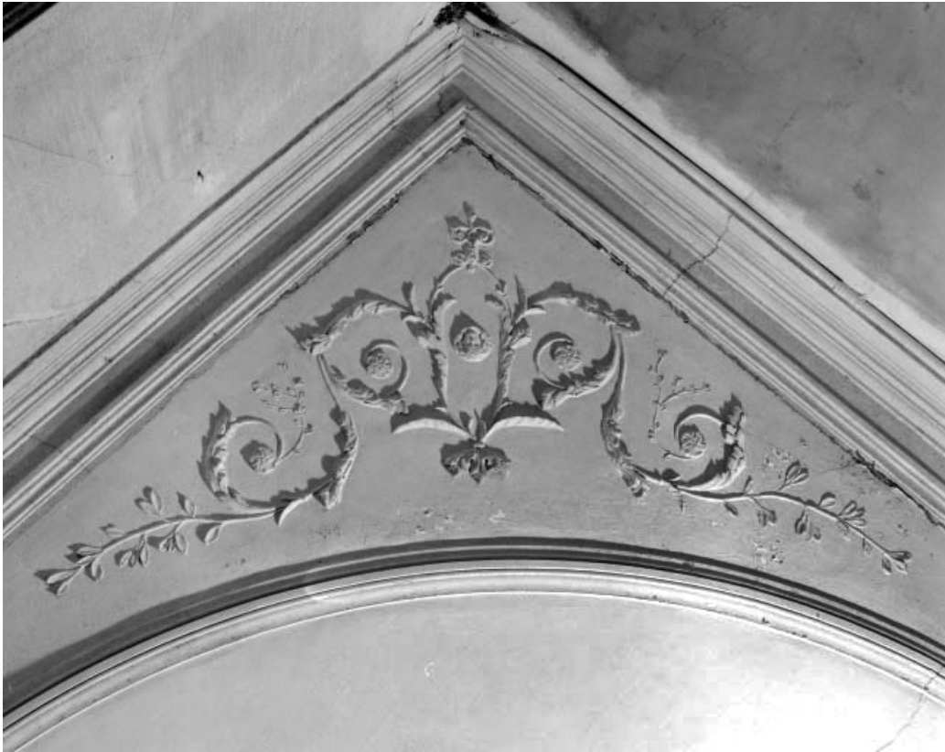
Intérieur de l'habitation : détail du décor du plafond de la cage d'escalier principale. 39, Syam 1ère demeure d'industriel, lieudit : les Forges
