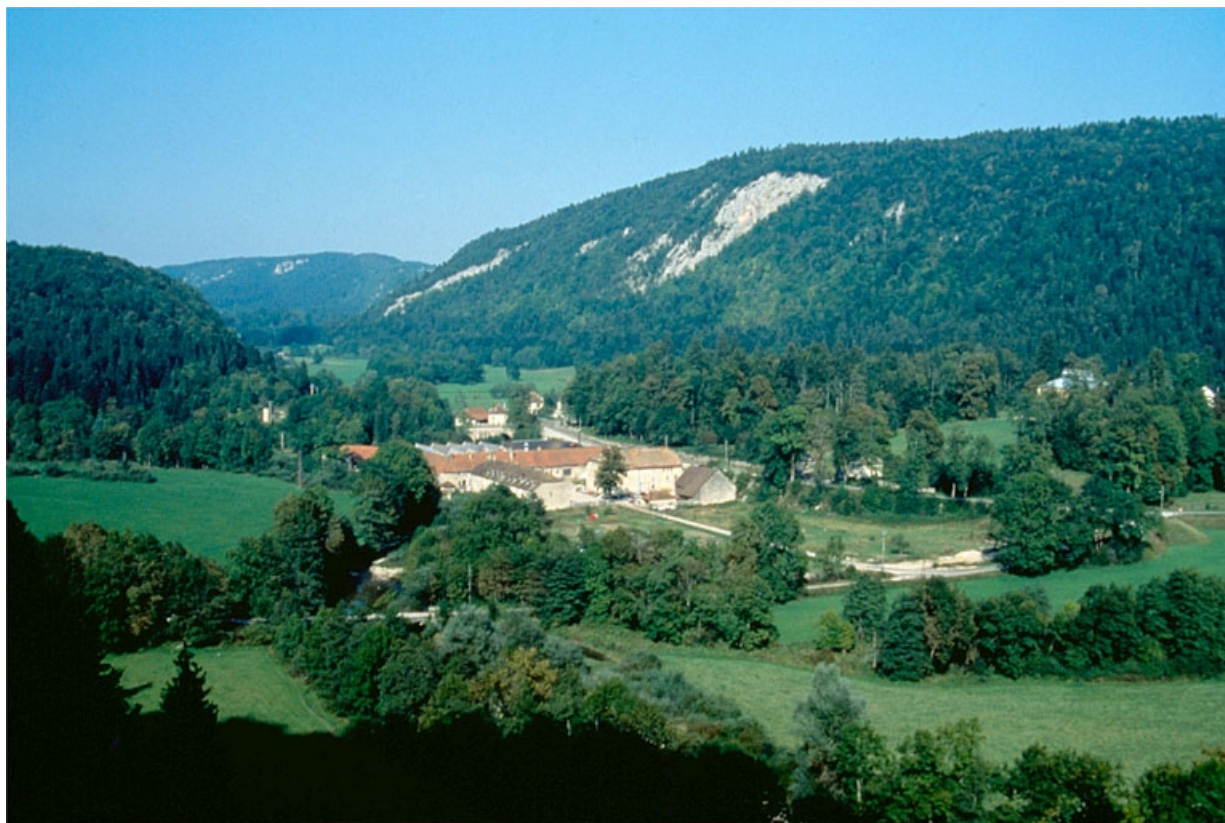
Vue d'ensemble de l'usine depuis le sud.
