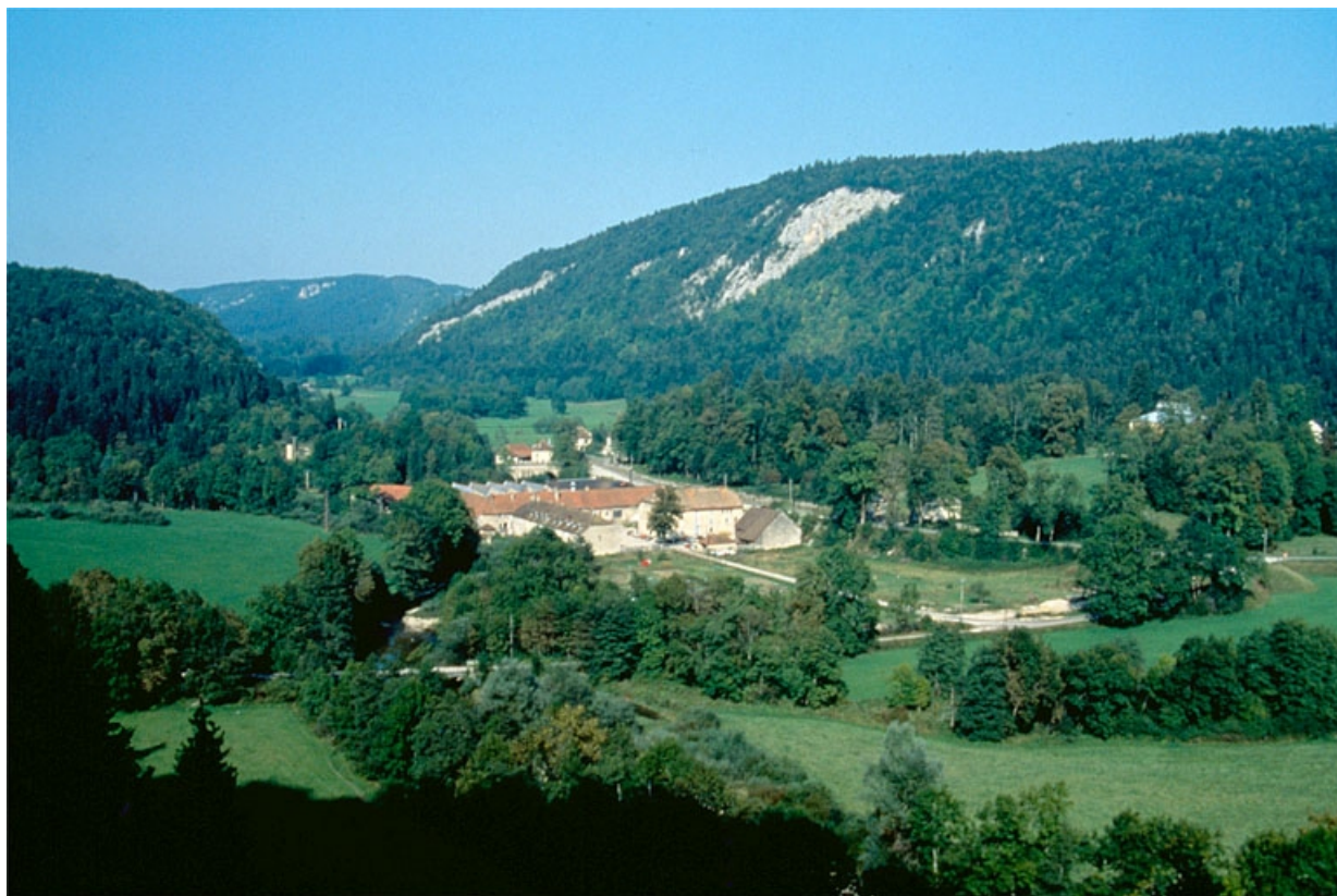
Vue d'ensemble de l'usine depuis le sud.
