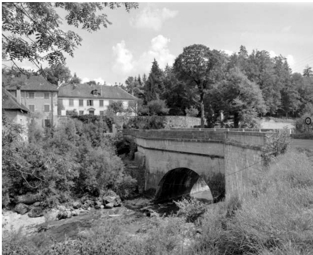
Pont sur l'Ain et 1ère demeure d'industriel ("ancien château").
