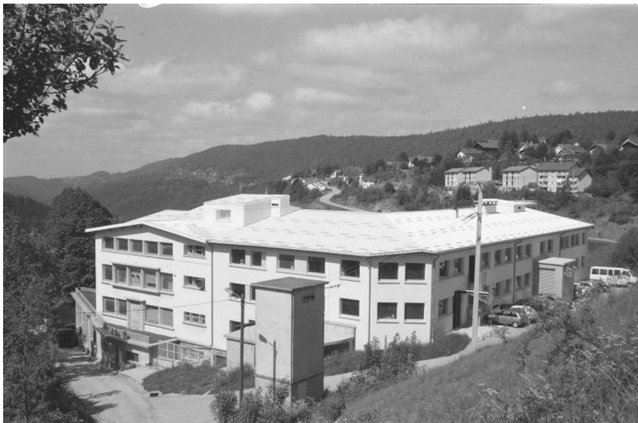
Façade postérieure des ailes nord et est.
