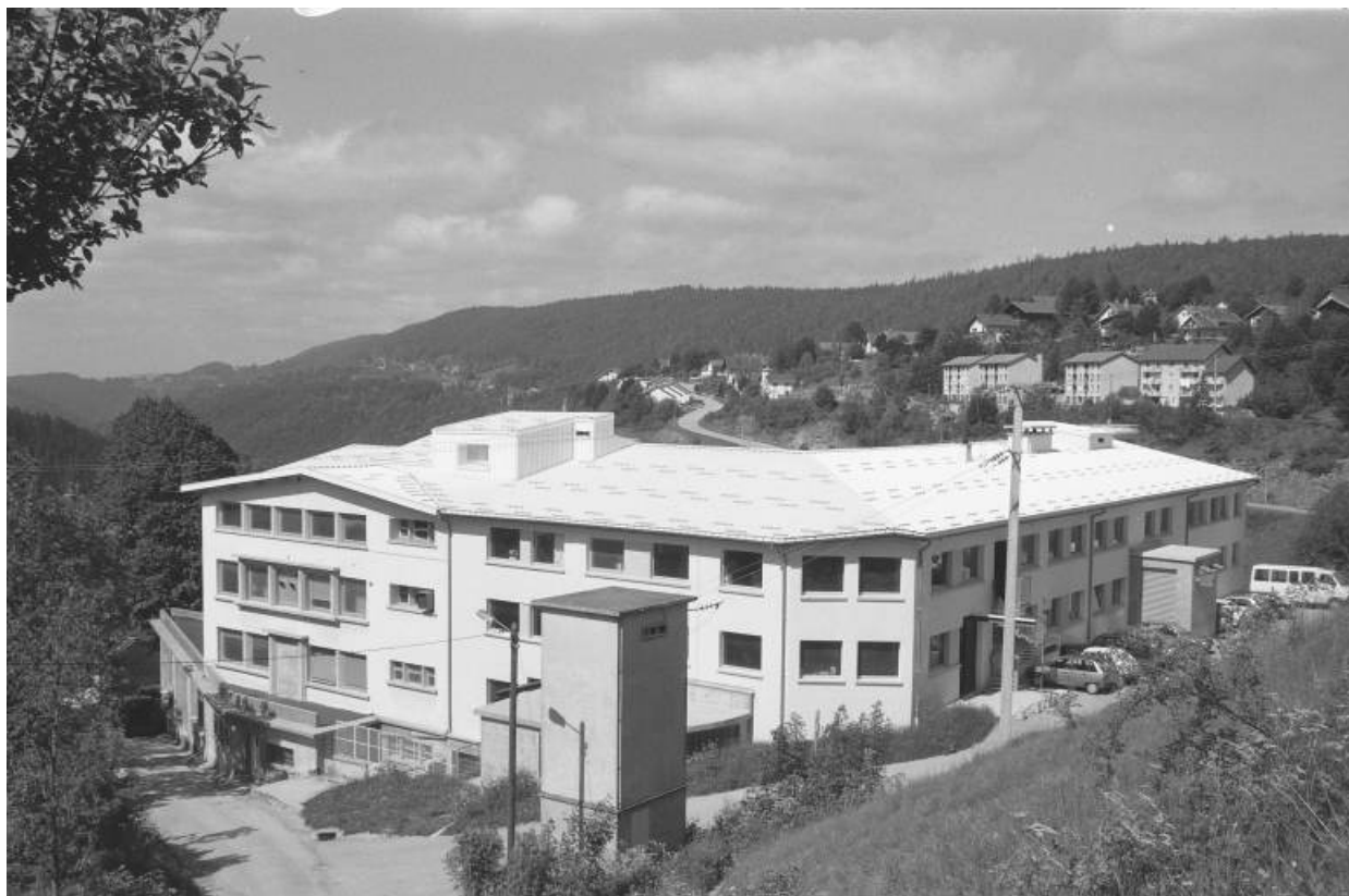
Façade postérieure des ailes nord et est.
