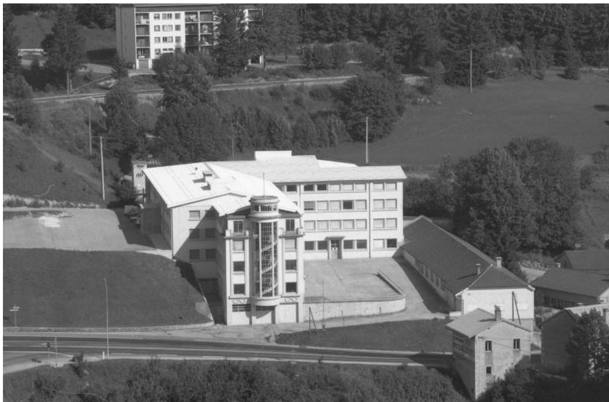
Vue d'ensemble plongeante sur l'usine, depuis l'ouest.
