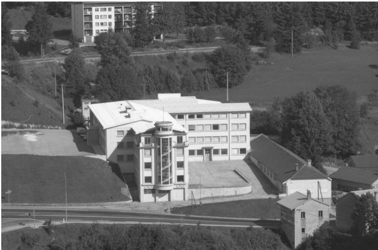
Vue d'ensemble plongeante sur l'usine, depuis l'ouest.
