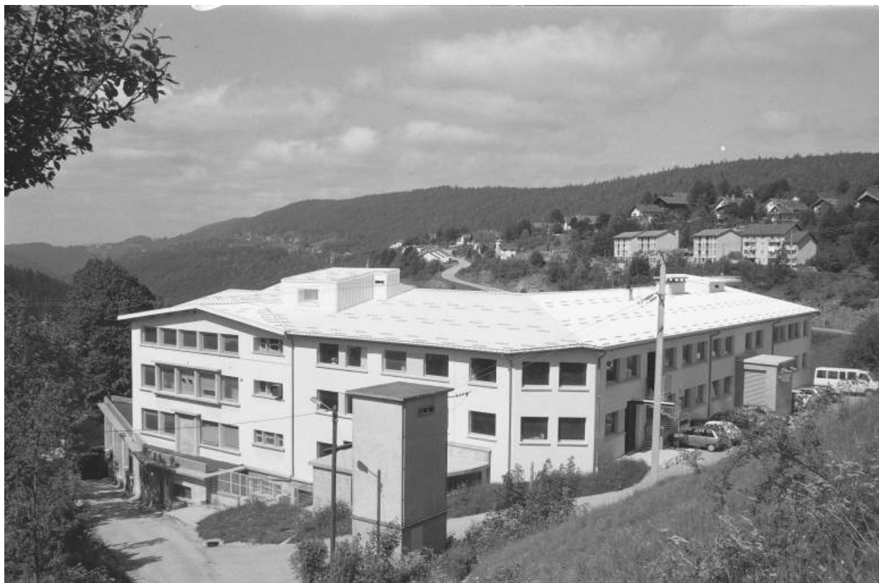
Façade postérieure des ailes nord et est.
