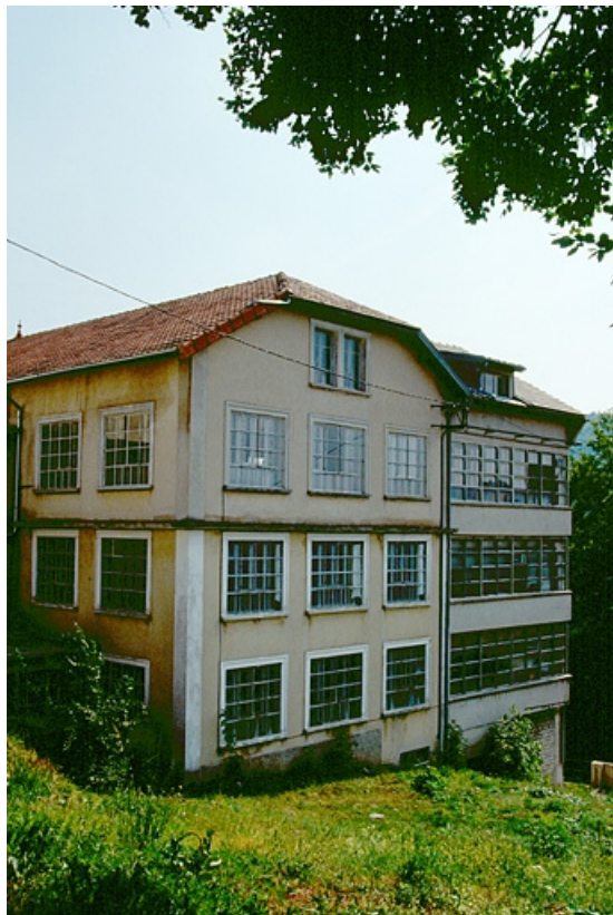
Façades postérieure et latérale droite des ateliers de fabrication (vue verticale). 39, Morbier, 11 route de Tancua
