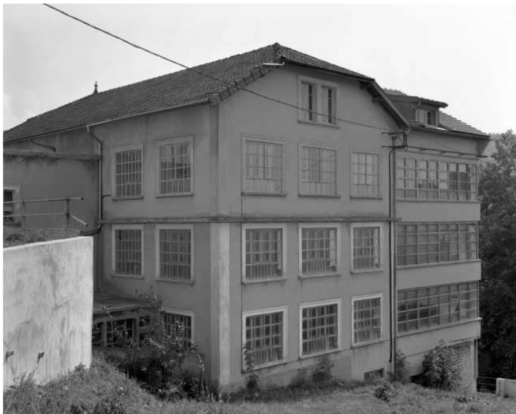
Façades postérieure et latérale droite des ateliers de fabrication.
