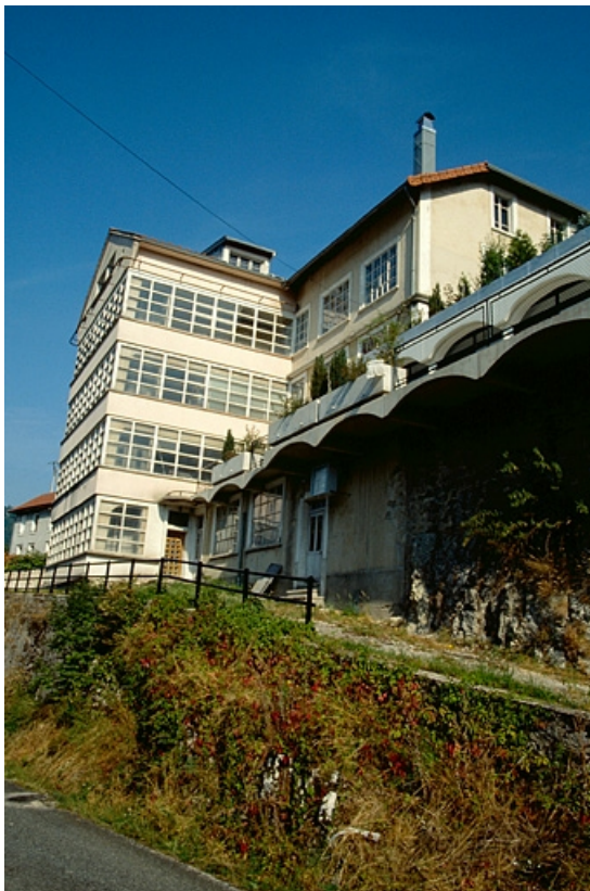
Façades antérieure et latérale gauche des ateliers de fabrication.
