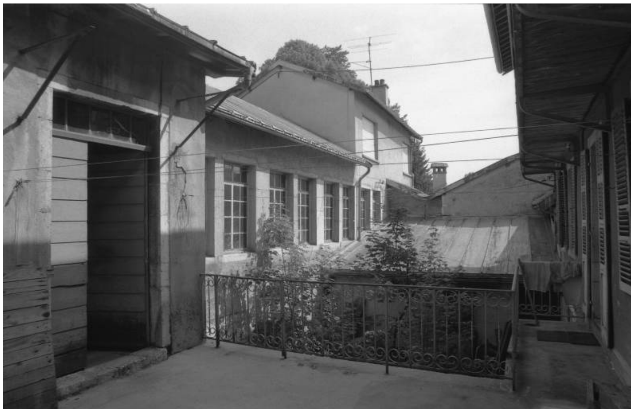
Façade antérieure de l'atelier de fabrication et bureau.
