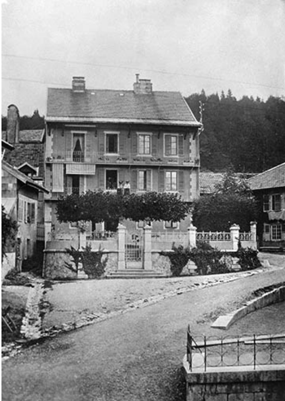
Façade antérieure du logement patronal.
