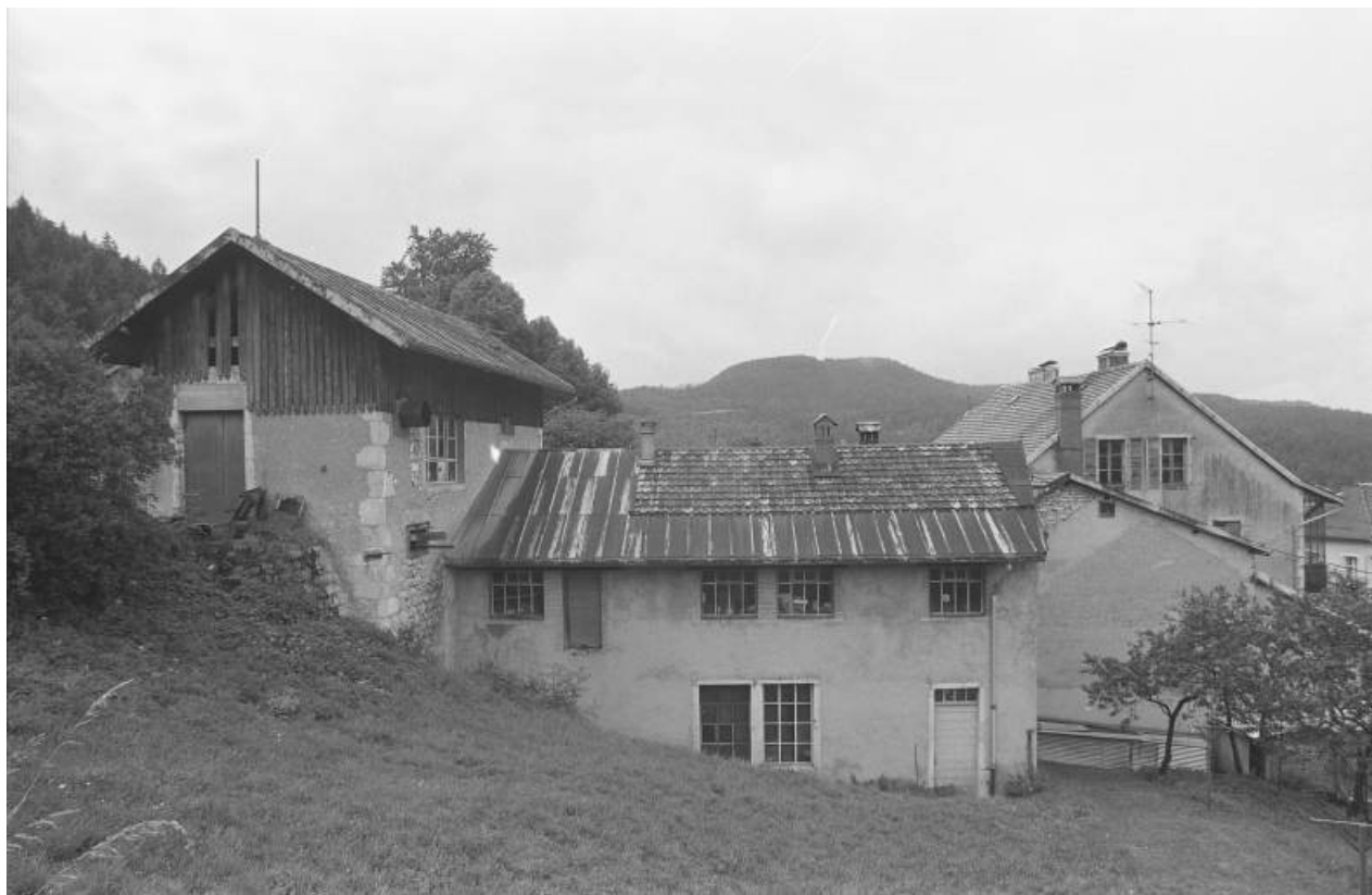
Ateliers de fabrication (polissage et peinture) depuis le nord.
