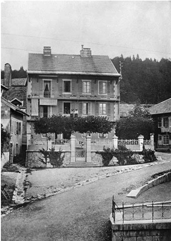
Façade antérieure du logement patronal.
