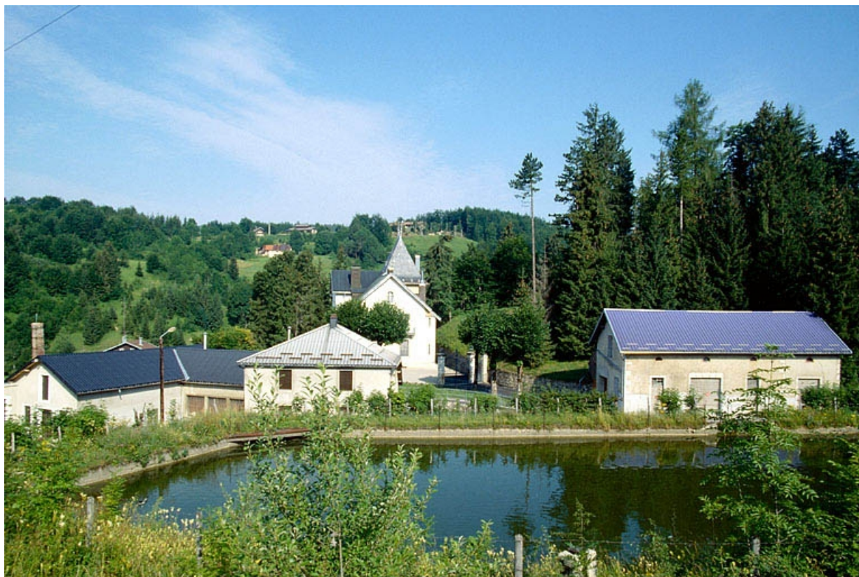
Bassin de retenue et façades sur rue.
