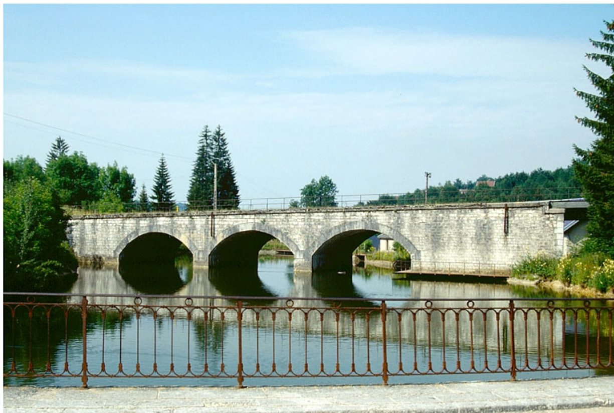
Bassin de retenue et pont du chemin de fer.
