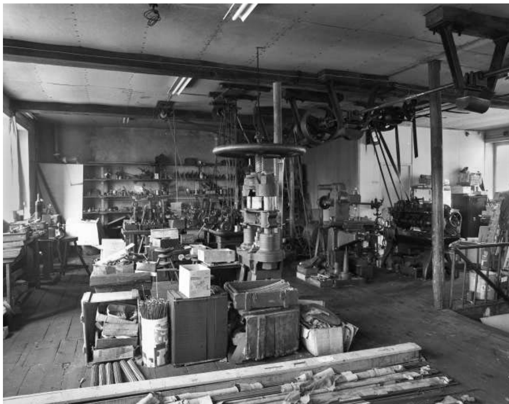
Intérieur de l'atelier à l'étage et machines.
