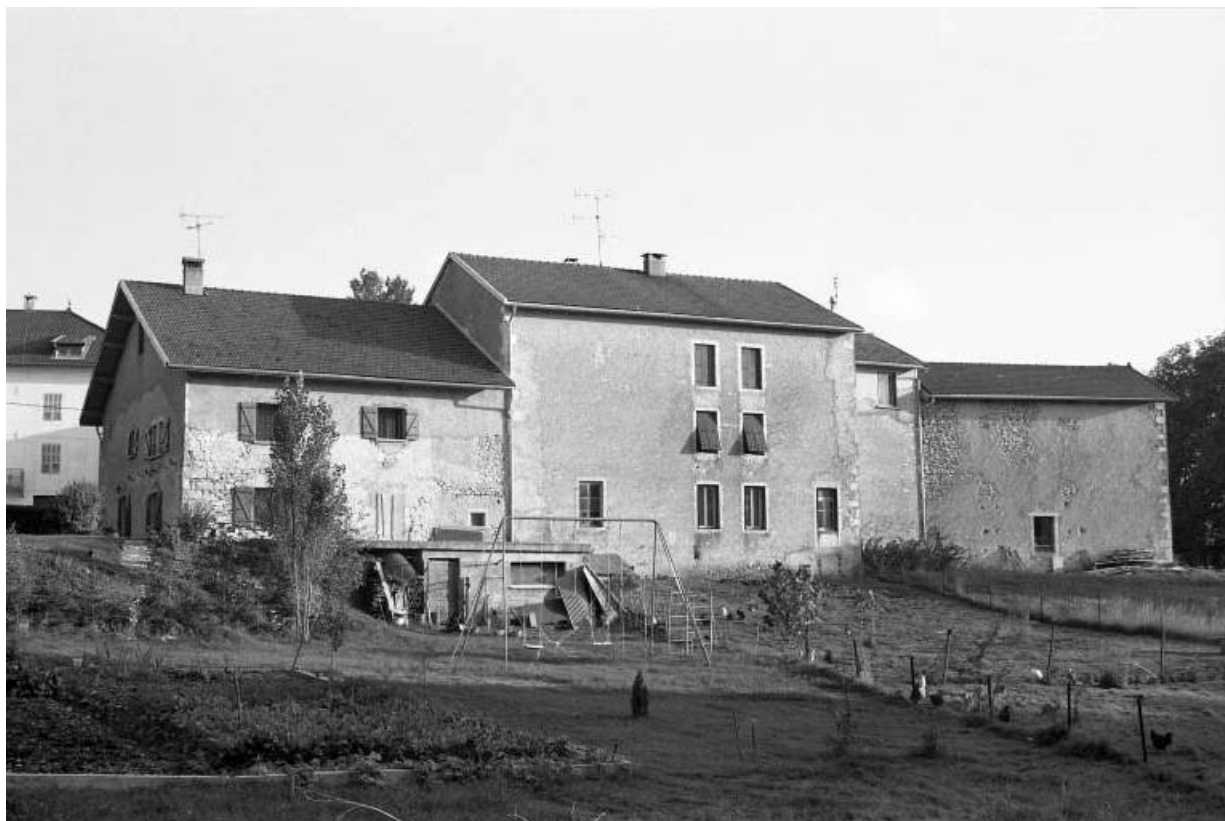
Façade postérieure de l'ensemble maison, fabrique de mètres et ferme.
