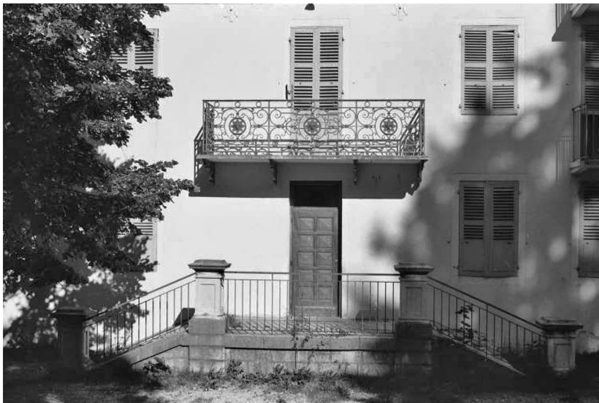
Façade postérieure du logement patronal : porte d'entrée et balcon.
