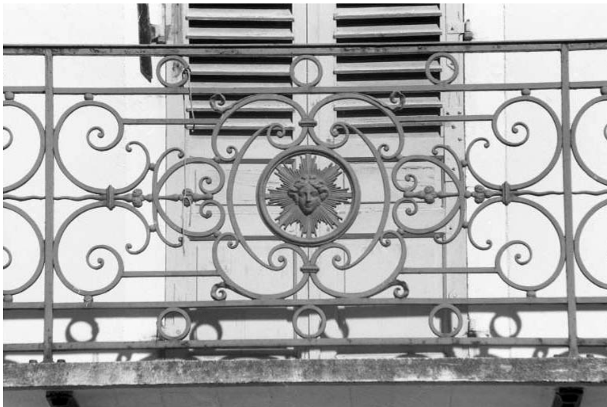
Façade postérieure du logement patronal : détail de la grille du balcon.
