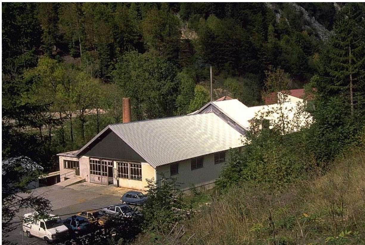
Vue plongeante sur la façade antérieure.
