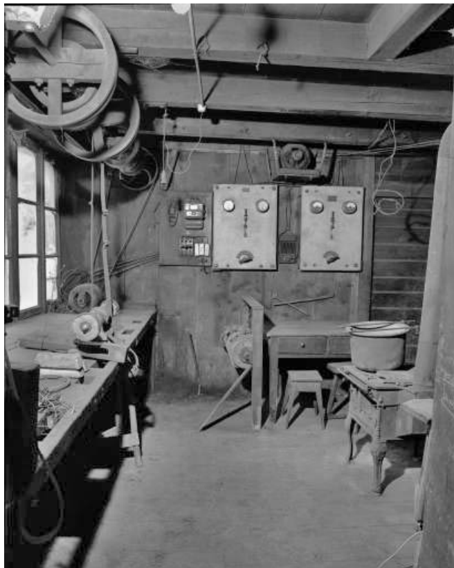
Intérieur : vue d'ensemble montrant le fond de l'atelier.
