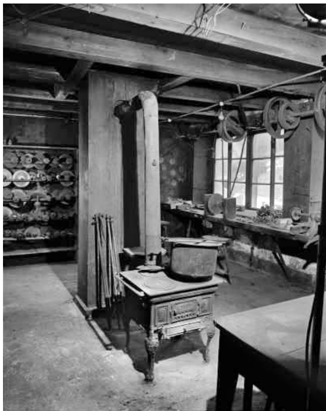
Intérieur : vue d'ensemble depuis le fond de l'atelier.
