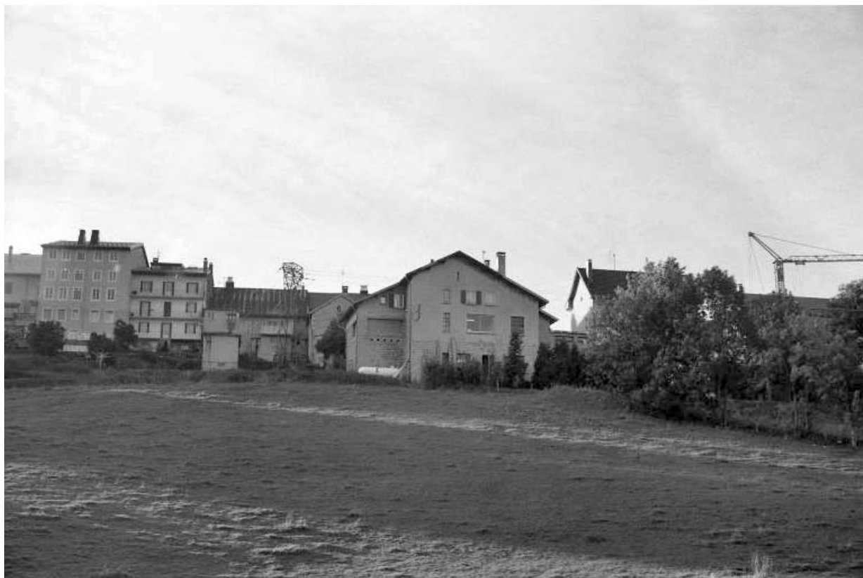
Vue d'ensemble : façade postérieure.
