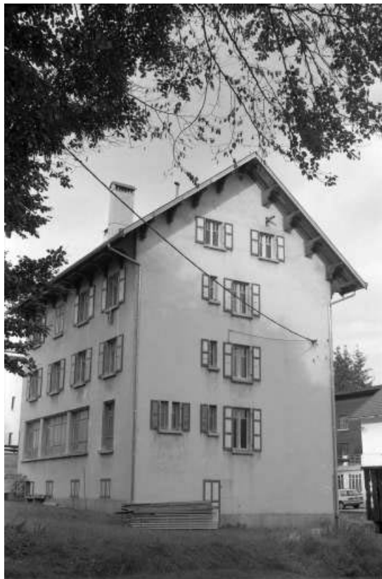
Façades antérieure et latérale droite.
