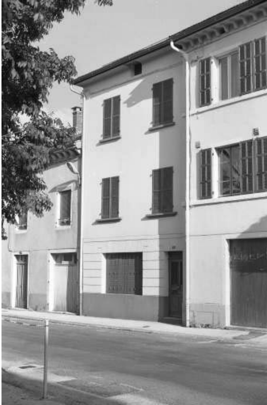
Façade antérieure du logement patronal (28, Grande Rue).
