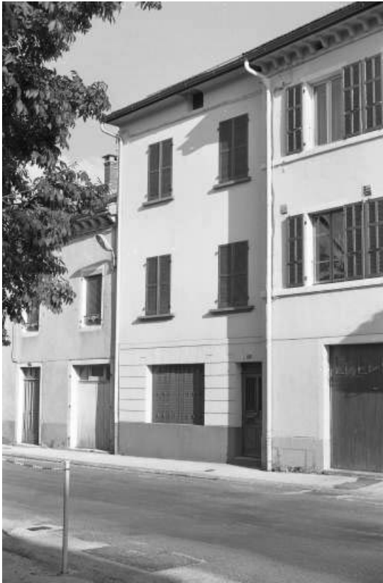
Façade antérieure du logement patronal (28, Grande Rue).
