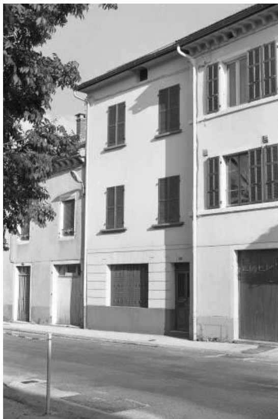
Façade antérieure du logement patronal (28, Grande Rue).
