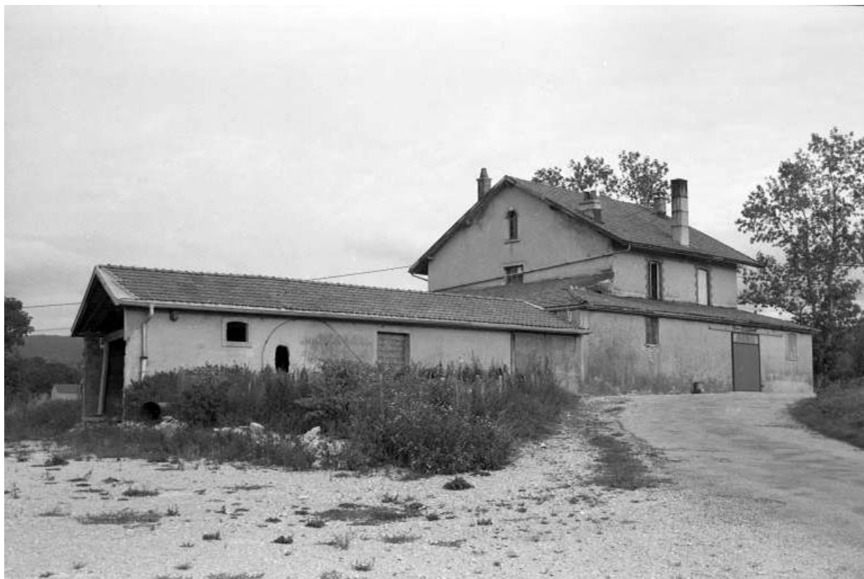
Façades postérieure et latérale gauche, et bûcher.
