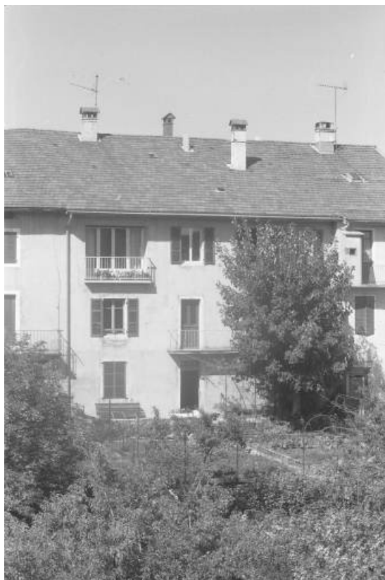
Vue rapprochée de la façade postérieure.
