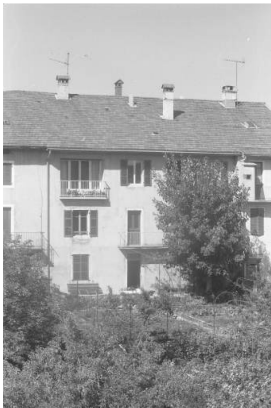
Vue rapprochée de la façade postérieure.
