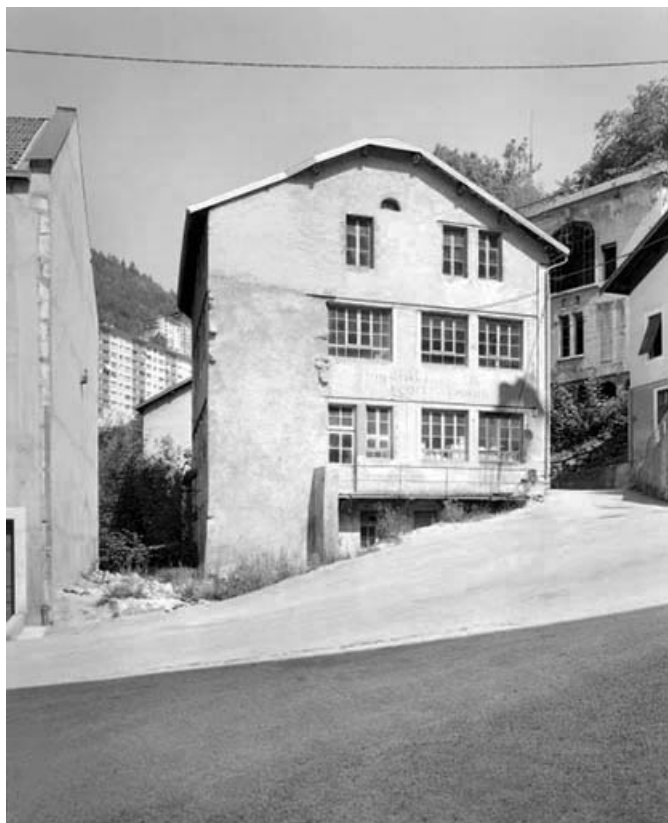
Atelier de fabrication Hostache (anciennement Cottet-Emard) et immeuble : façade antérieure. 39, Saint-Claude, 3 à 6 chemin de la Coupe
