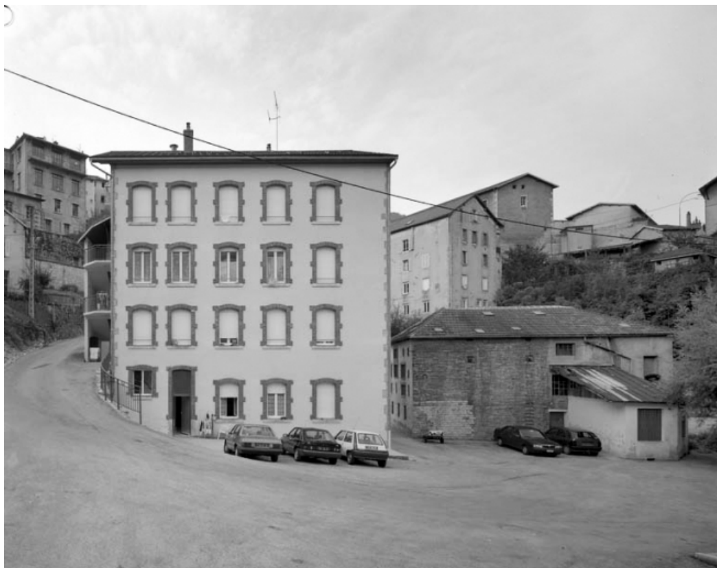
Immeuble (ancienne maison Vuillard) et atelier de fabrication Martena : façade antérieure. 39, Saint-Claude, 3 à 6 chemin de la Coupe
