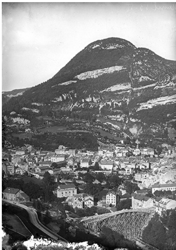
Vue d'ensemble de la ville depuis le sud-ouest, avec le Pont central en construction.
