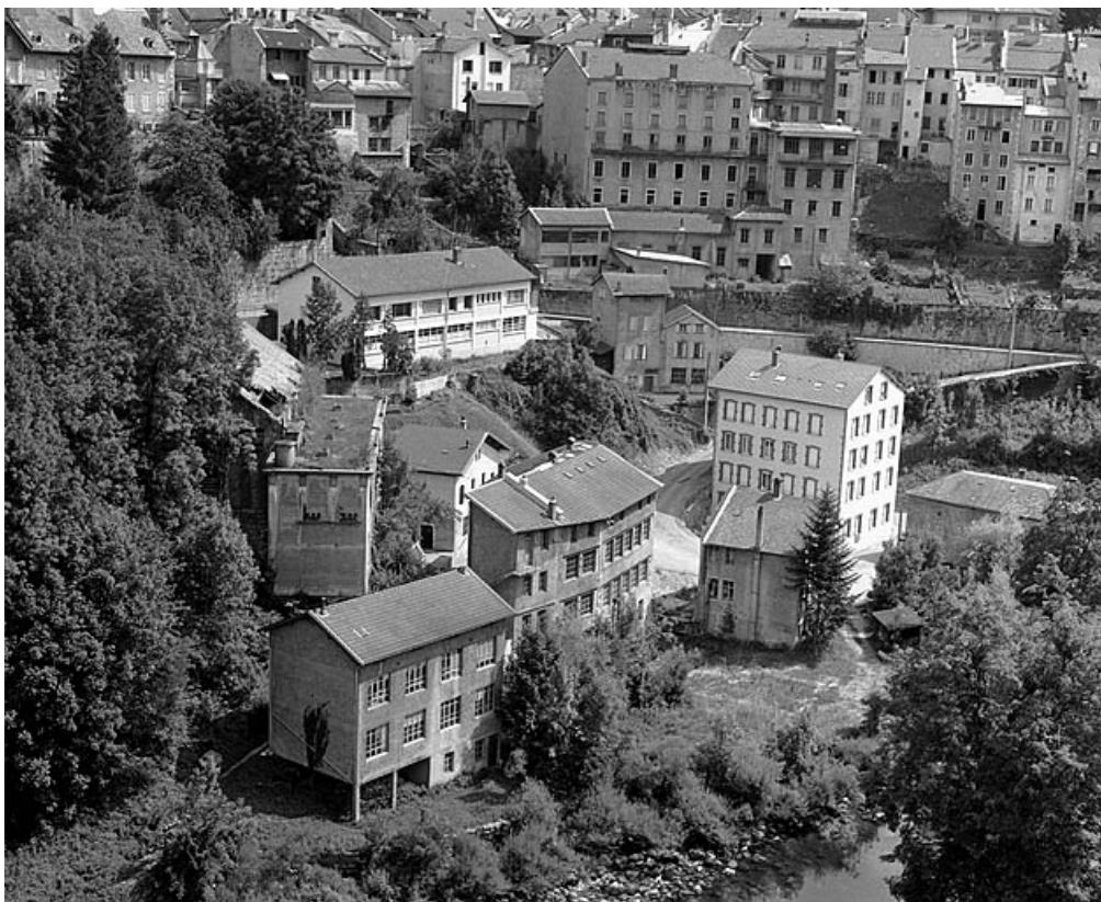
Vue d'ensemble rapprochée depuis le nord-ouest.
