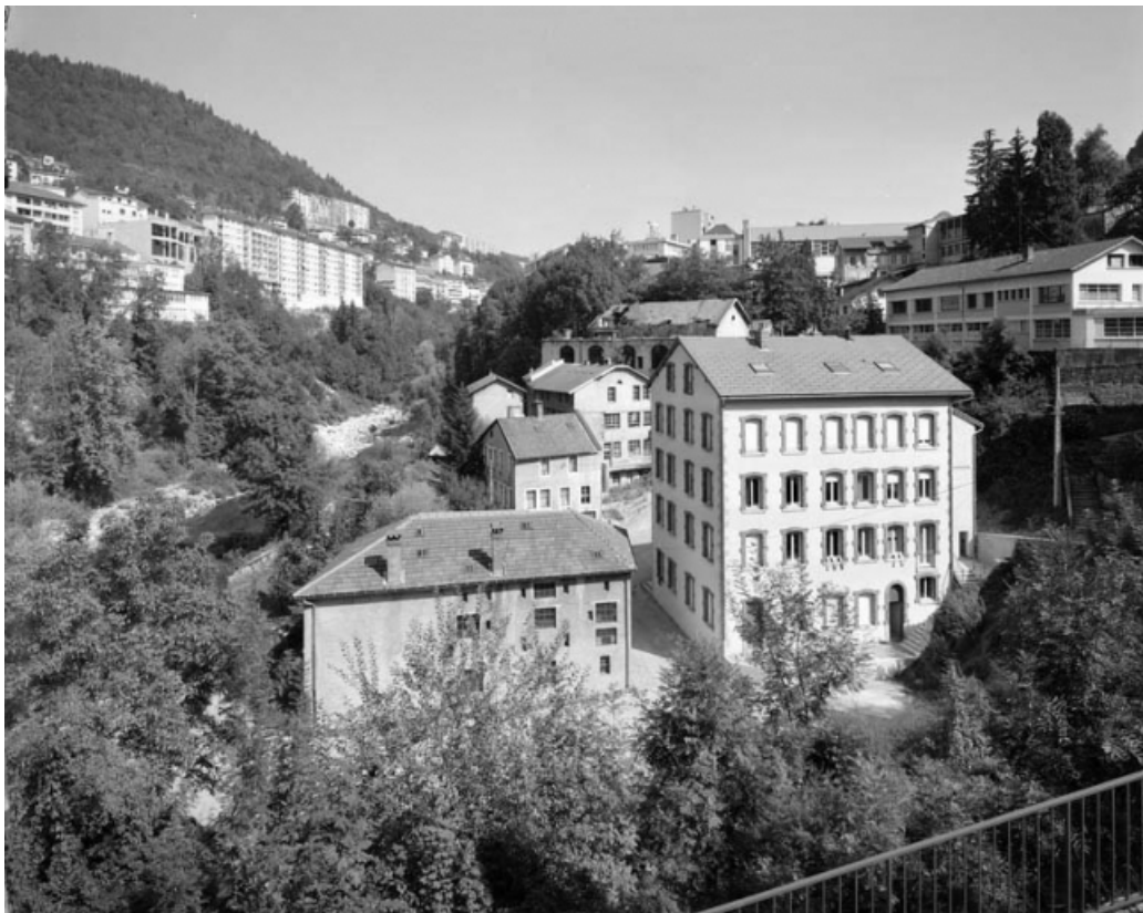
Vue d'ensemble depuis le sud.
