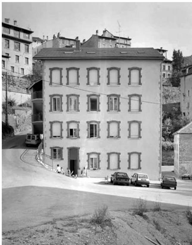
Immeuble (ancienne maison Vuillard) : façade antérieure.
