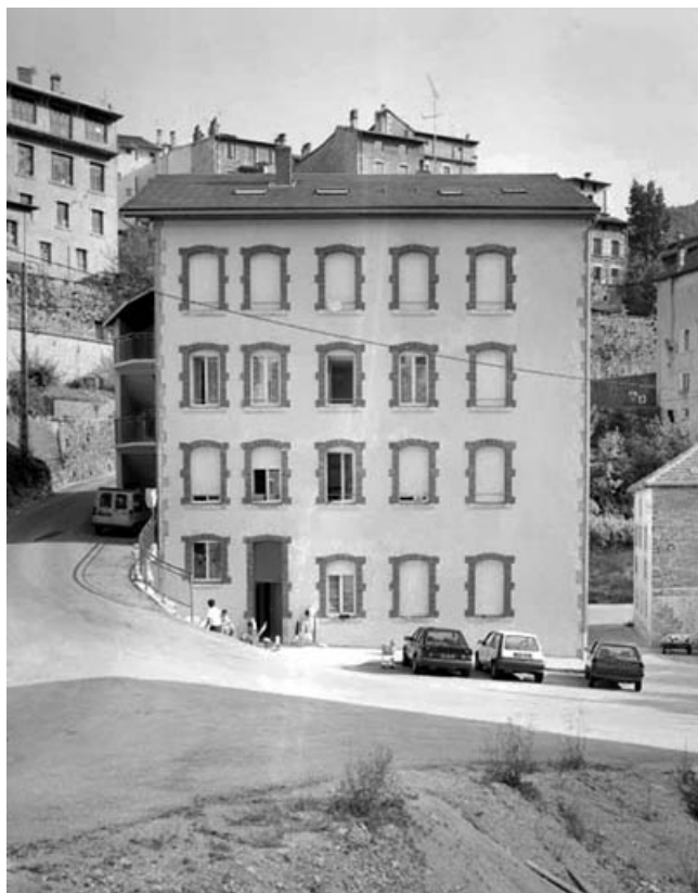
Immeuble (ancienne maison Vuillard) : façade antérieure.
