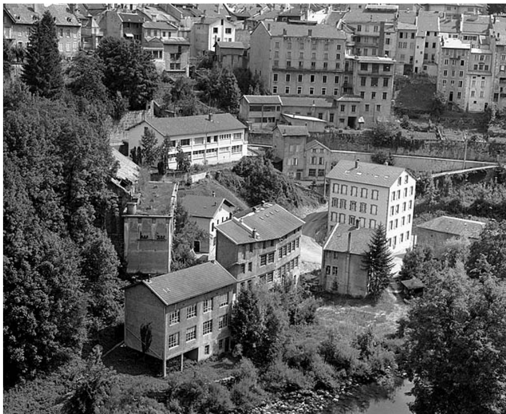
Vue d'ensemble rapprochée depuis le nord-ouest.
