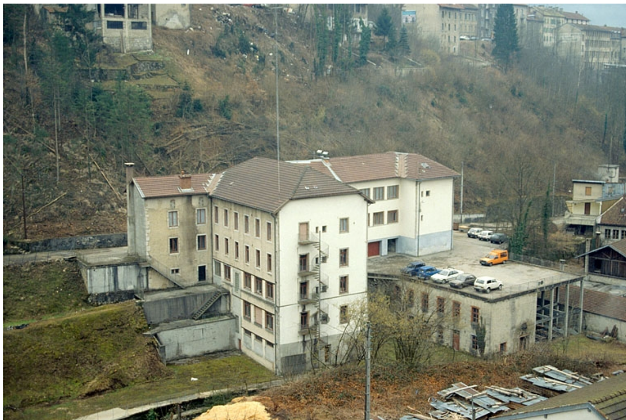
Vue d'ensemble plongeante depuis le nord.
