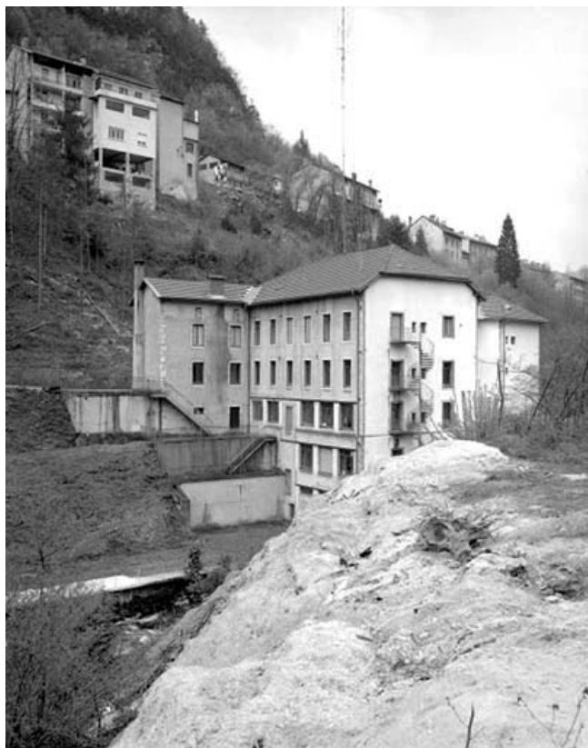
Ateliers de fabrication depuis le nord.
