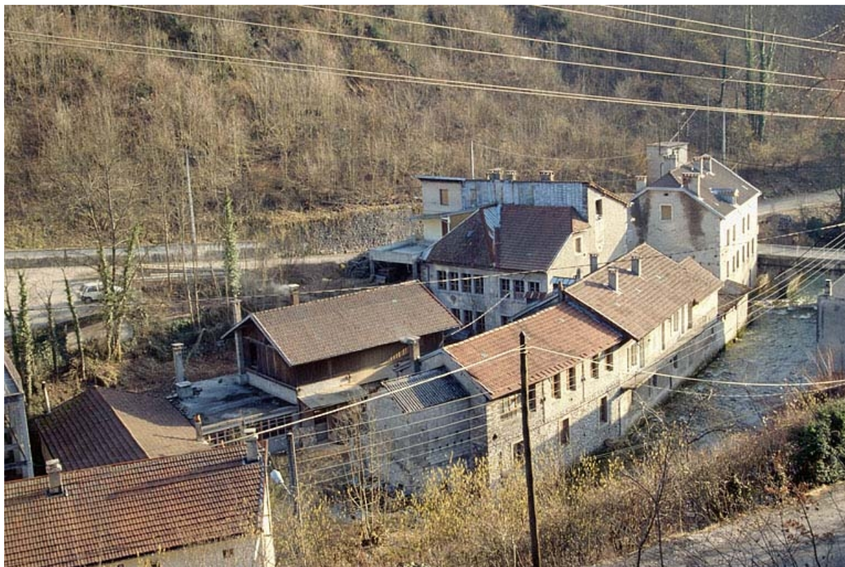
Vue d'ensemble plongeante depuis le nord-ouest.
