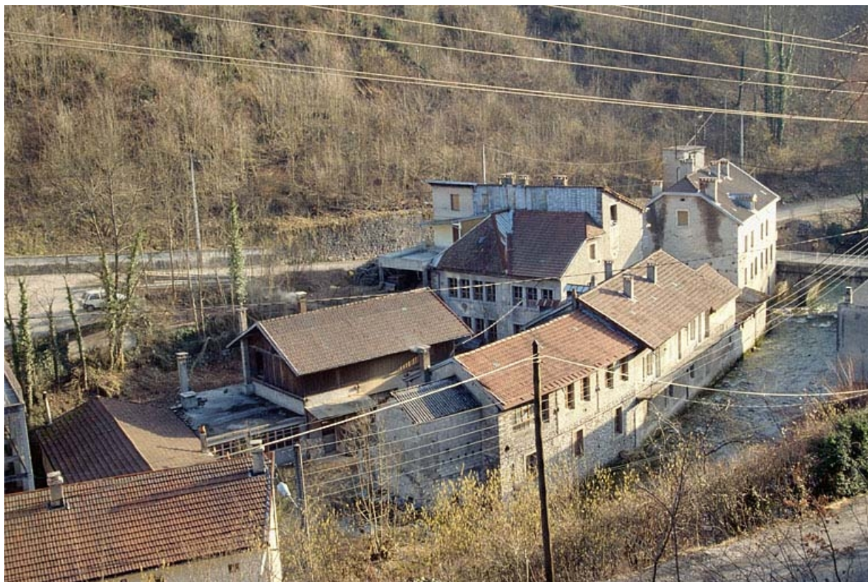
Vue d'ensemble plongeante depuis le nord-ouest.
