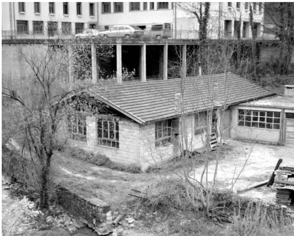
Atelier de fabrication et chaufferie de 1941.
