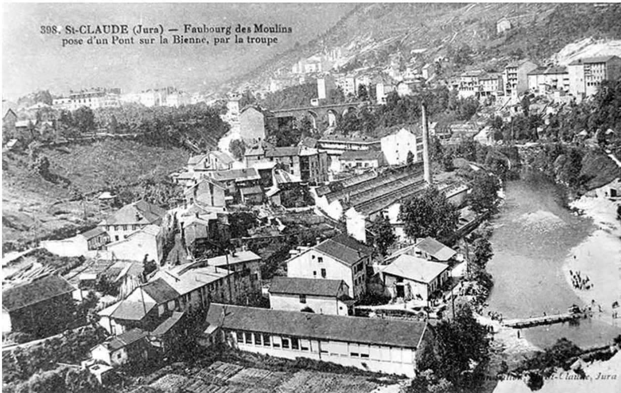
St-Claude (Jura) - Faubourg des Moulins. Pose d'un Pont sur la Bièvre, par la troupe.
