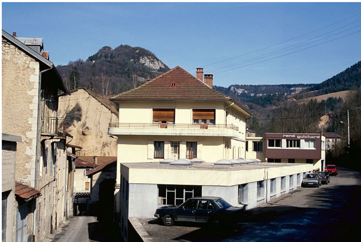
Façades antérieure et latérale gauche.
