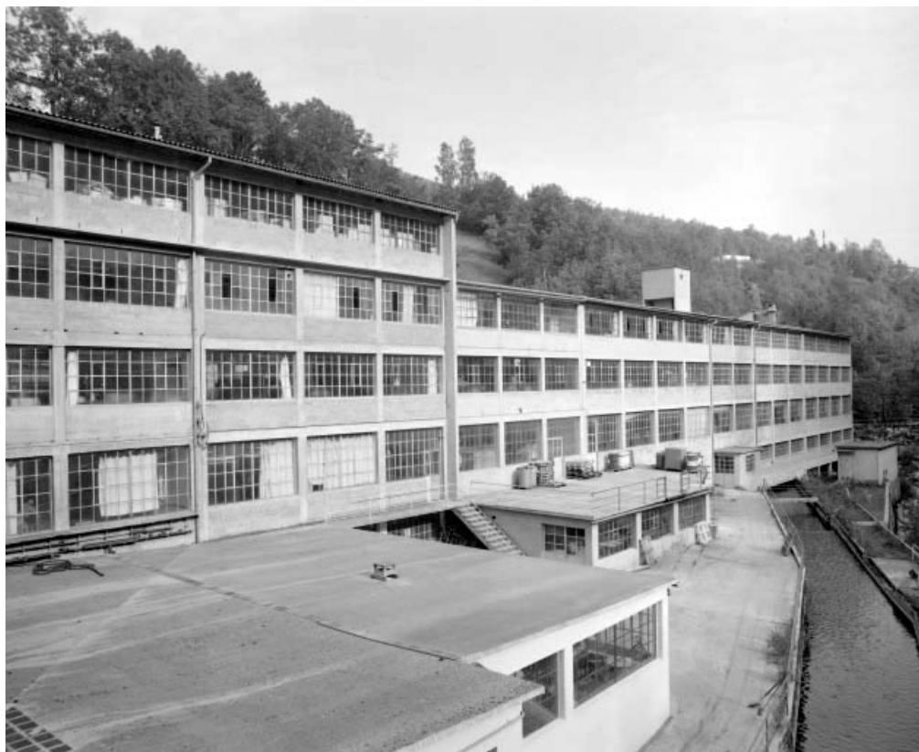
Façade postérieure des ateliers de fabrication.
