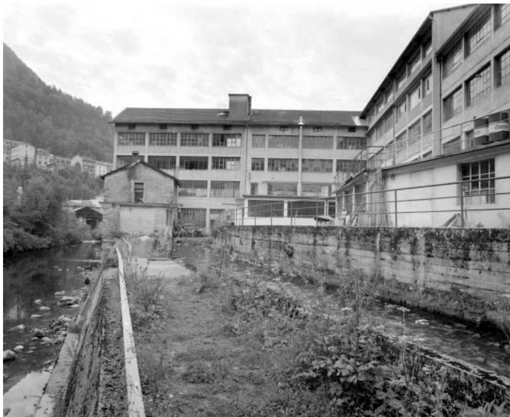
Façade postérieure des bâtiments et canal, depuis l'amont.
