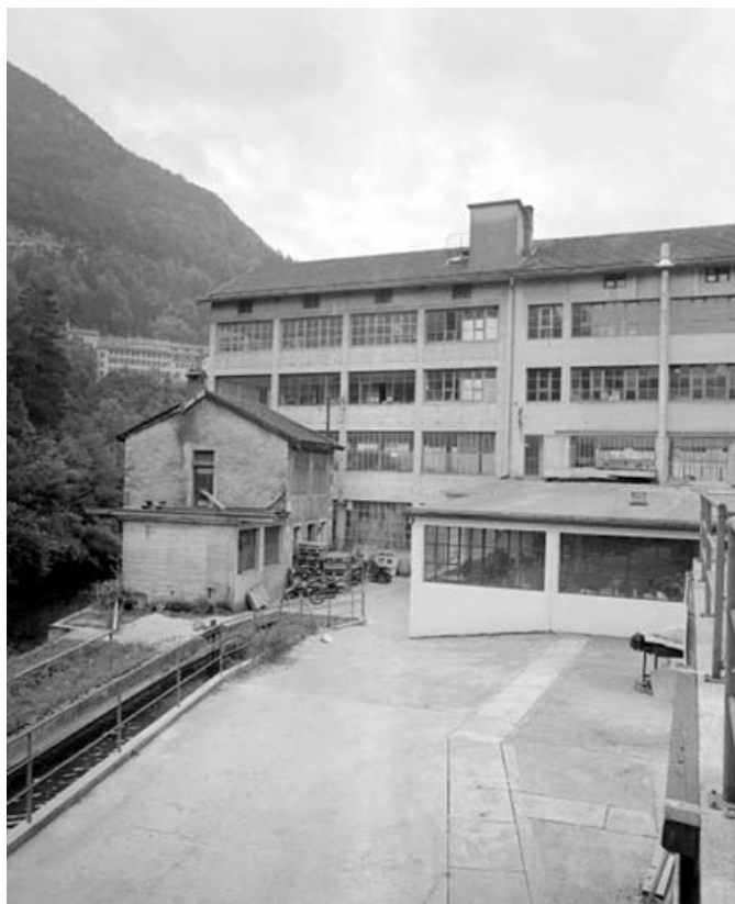
Atelier désaffecté, façade postérieure de l'atelier de conditionnement et atelier de réparation. 39, Saint-Claude, 20 chemin des Arrivoirs
