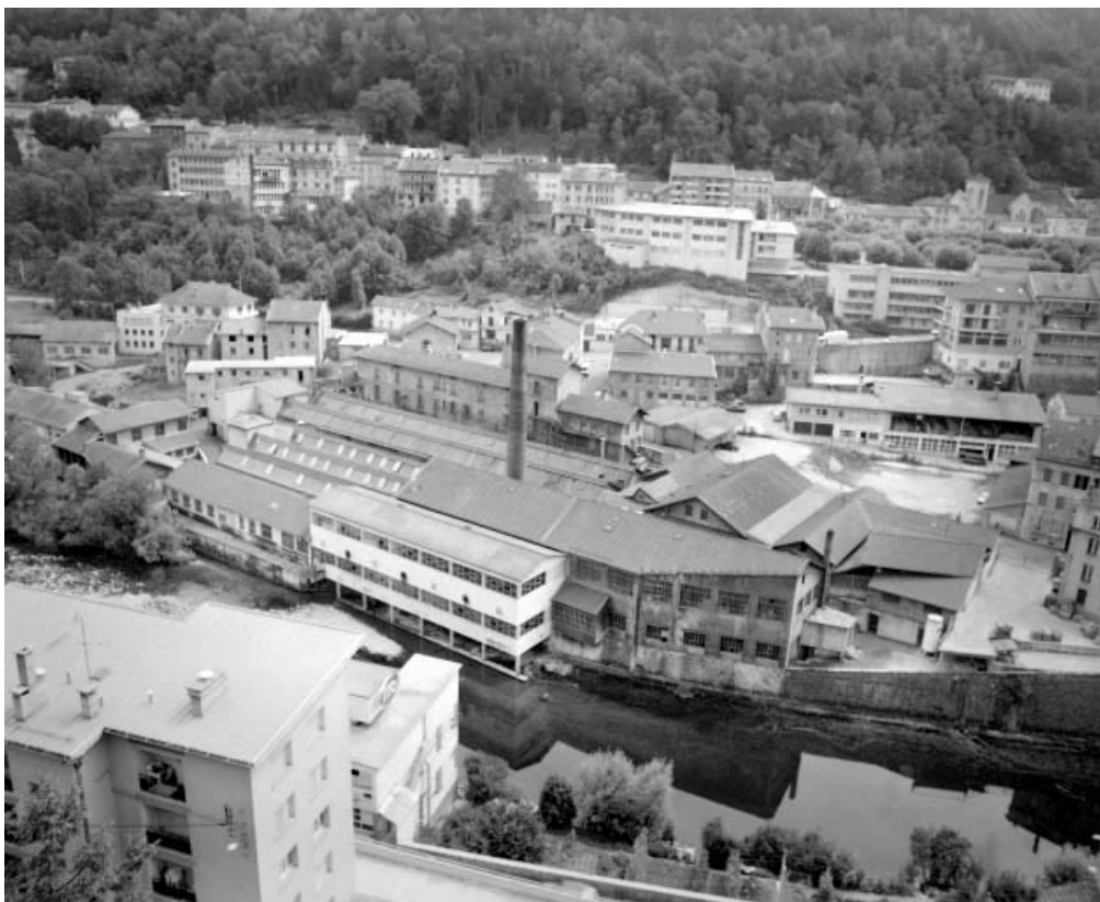
Vue d'ensemble plongeante depuis le nord-ouest.
