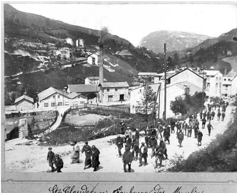
St-Claude (Jura) Faubourg des Moulins St-Claude (Jura). Faubourg des Moulins. Usine de l'Ebonite : la sortie des ouvriers à midi. 39, Saint-Claude, 2 à 8 rue du Faubourg des Moulins
