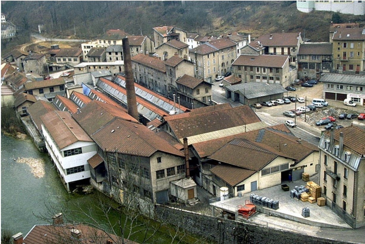
Vue d'ensemble plongeante sur l'usine, depuis l'ouest.
