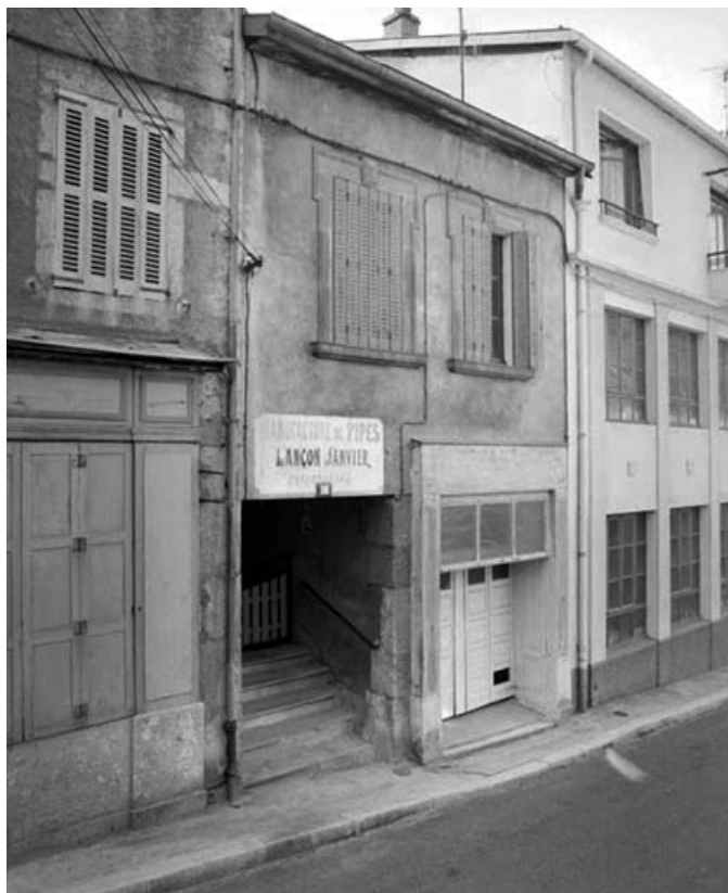
Façade antérieure du bâtiment sur la rue Christin.
