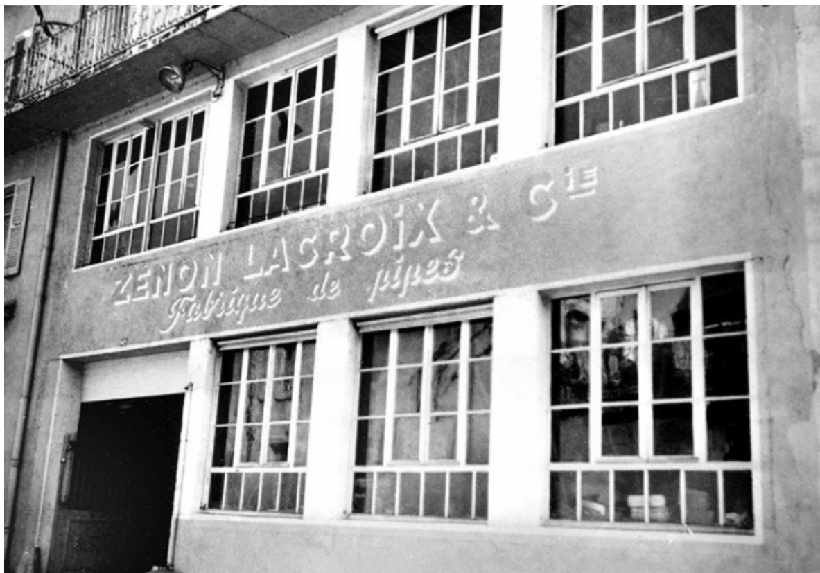
Façade antérieure du n° 8 bis.
