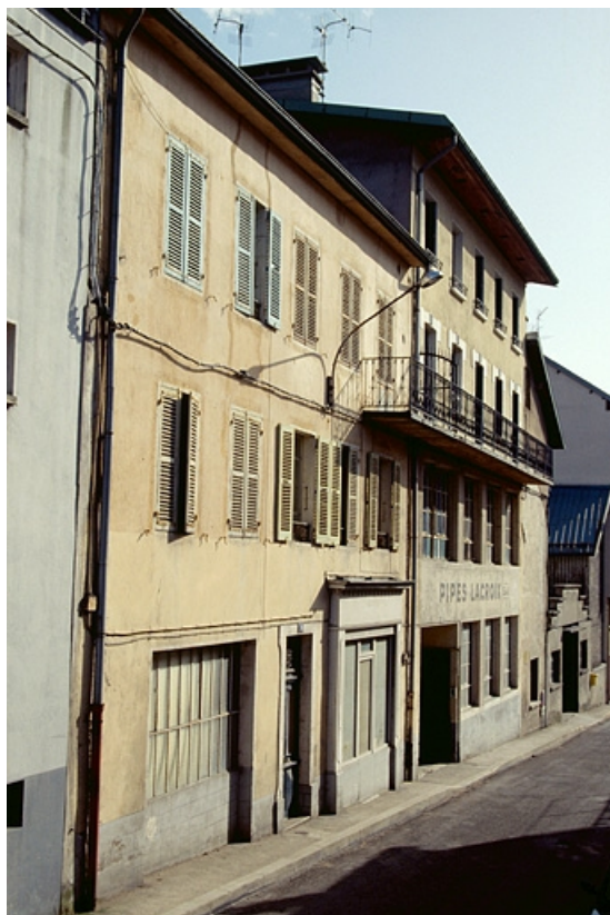
Façade antérieure des bâtiments sur rue.
