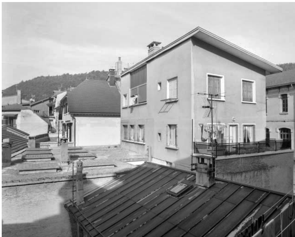
Façade postérieure du bâtiment d'origine et toiture de celui de 1960.
