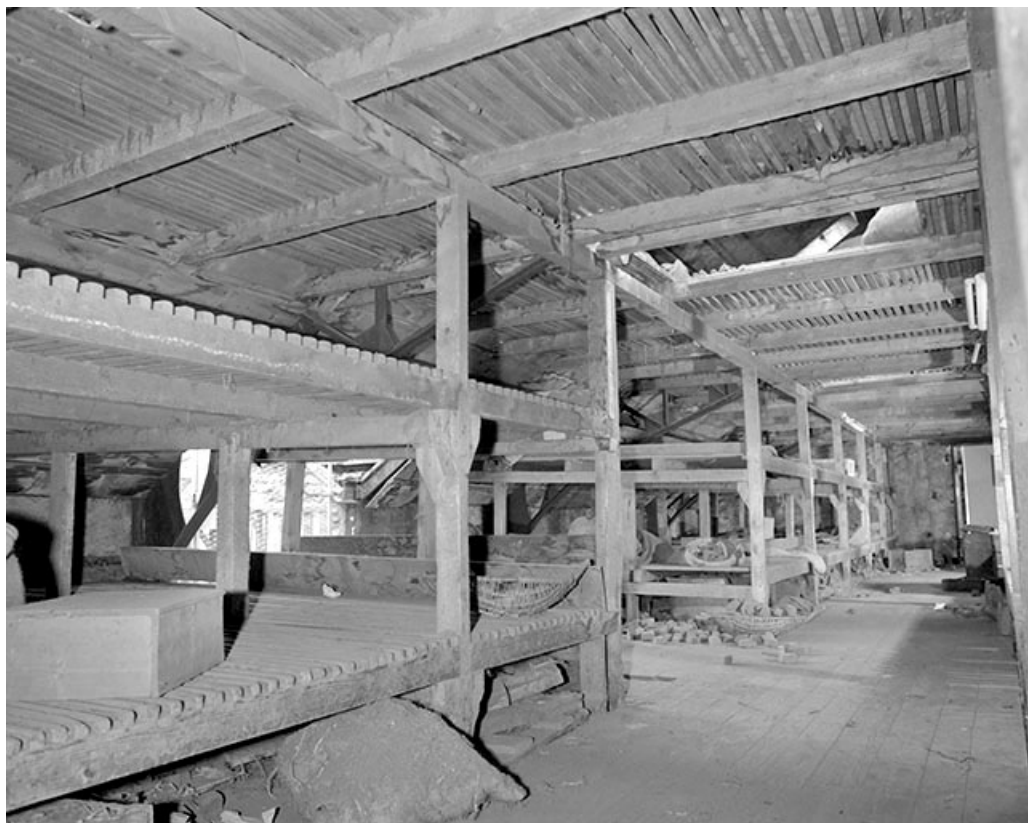
Intérieur d'un séchoir à ébauchons (bâtiment nord).
