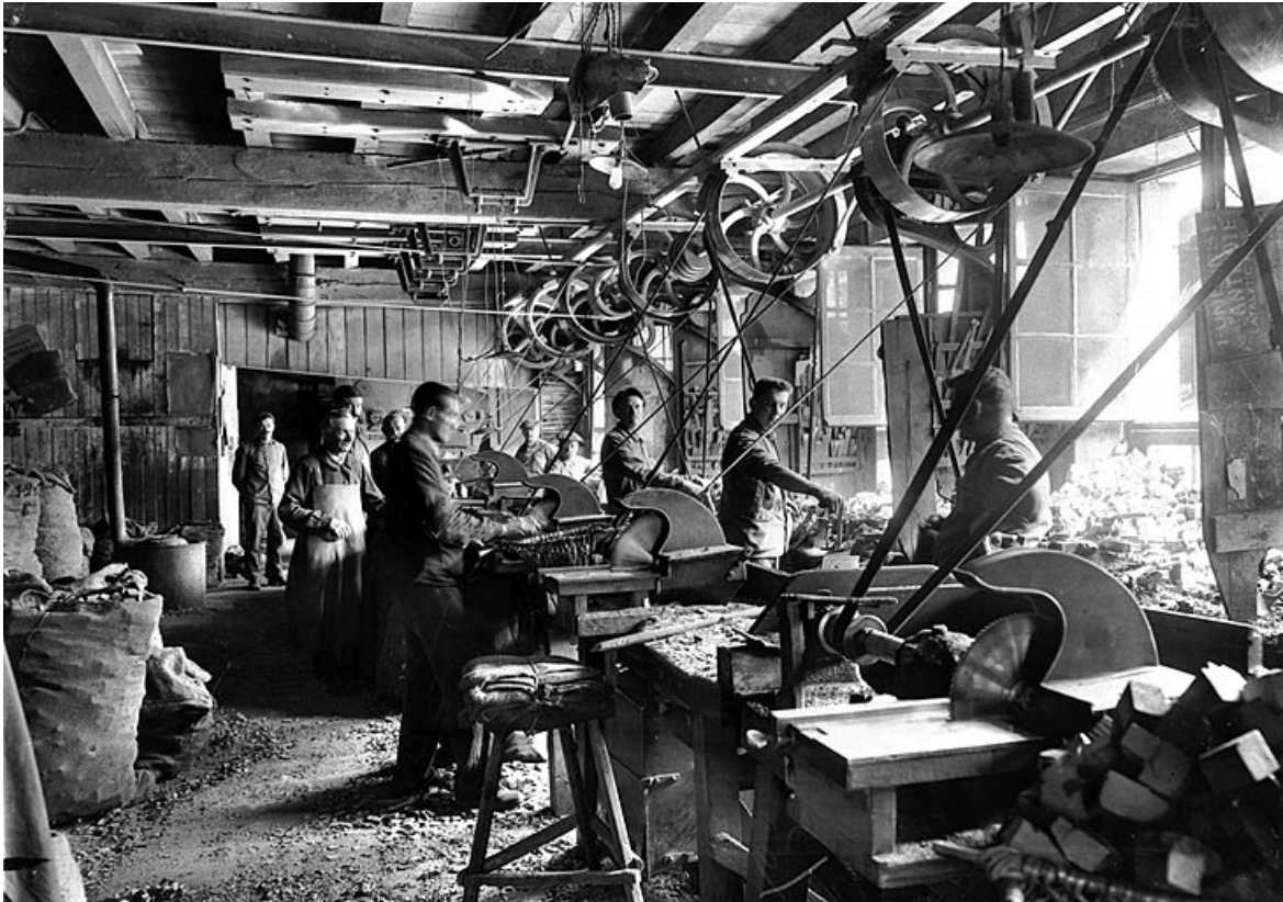
Intérieur de l'atelier d'ébauchage.
