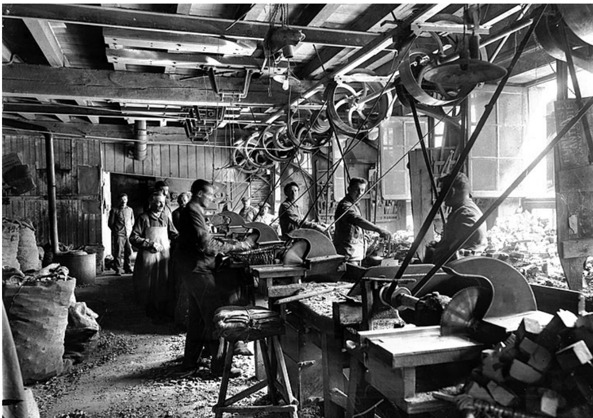
Intérieur de l'atelier d'ébauchage.
