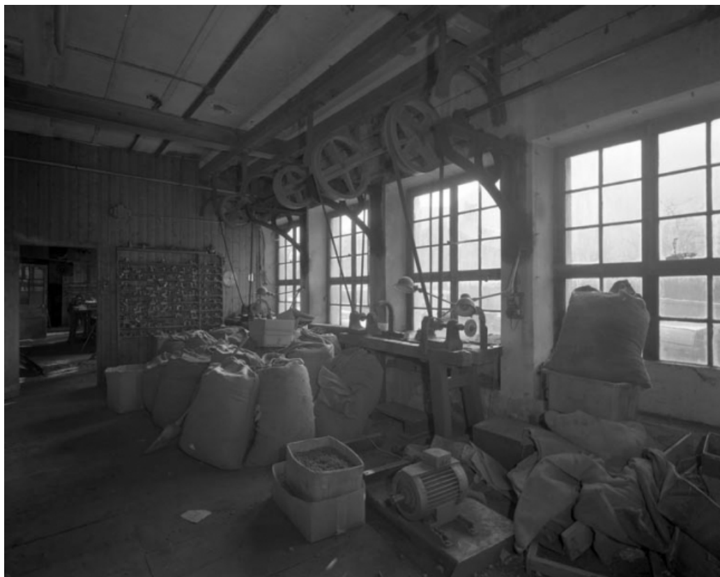
Intérieur de l'atelier de mécanique.
