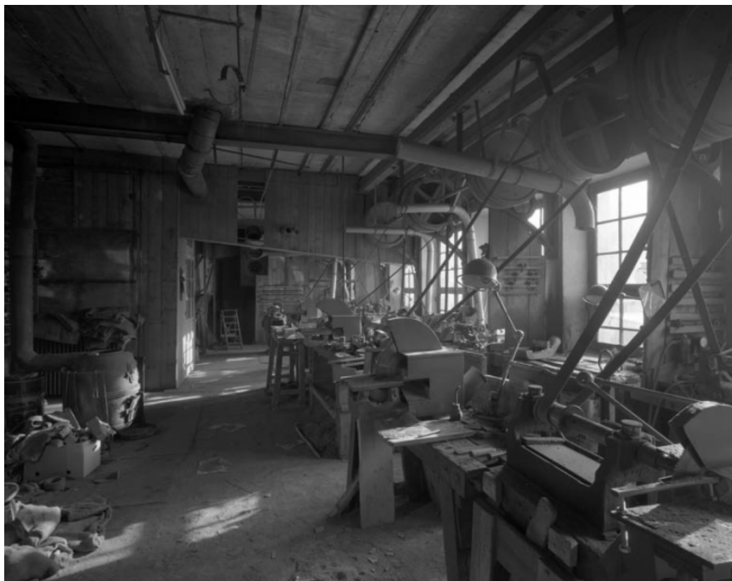
Intérieur de l'atelier d'ébauchage, depuis l'entrée.
