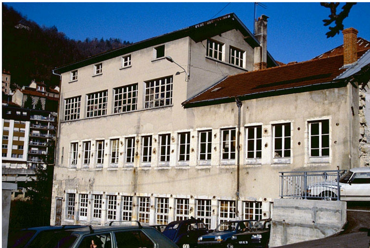
Bâtiment sud vu de trois quarts droite.
