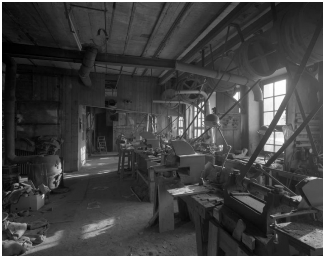
Intérieur de l'atelier d'ébauchage, depuis l'entrée.
