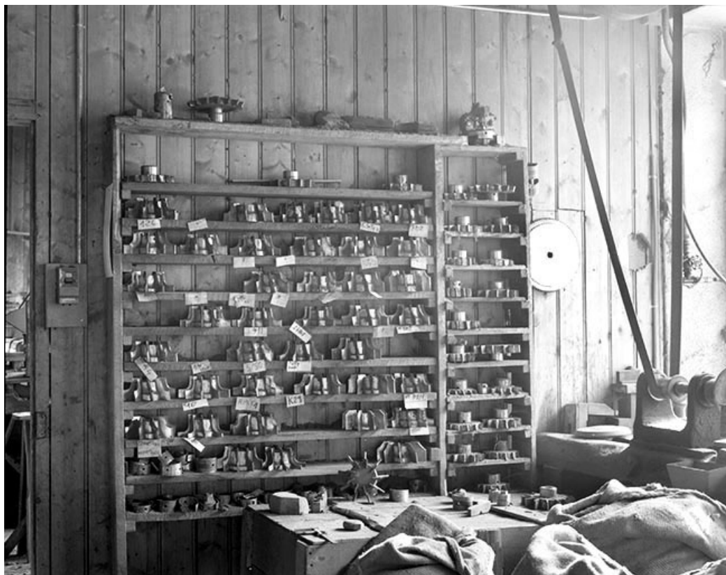
Atelier de mécanique : fraises pour l'ébauchage.
