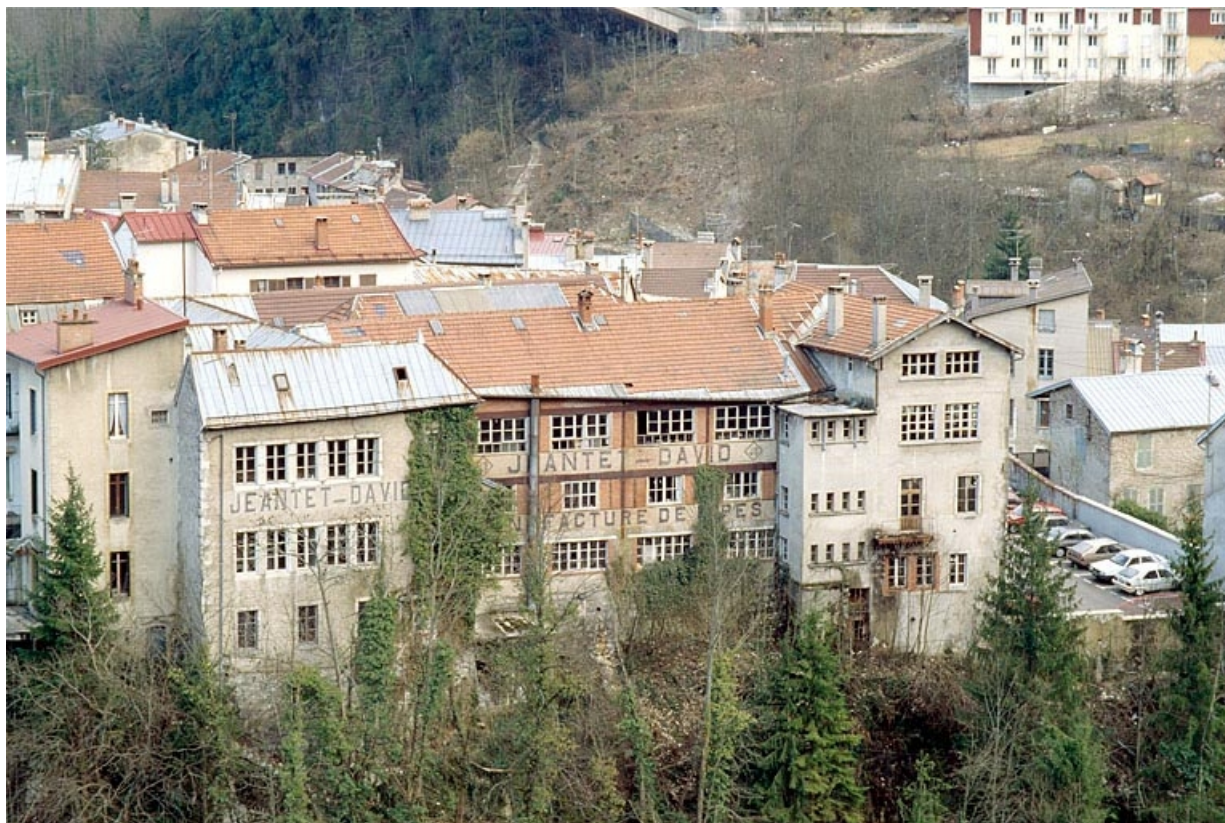
Vue d'ensemble rapprochée depuis l'ouest.
