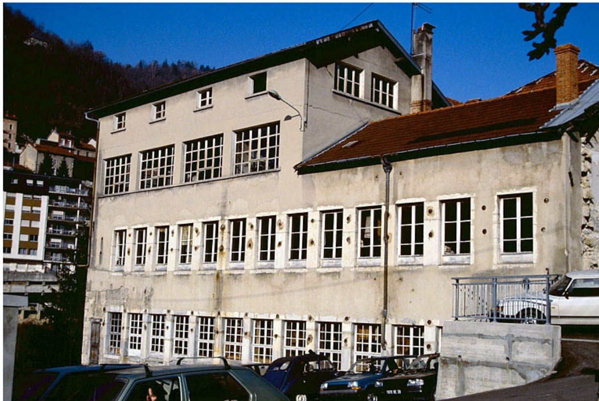
Bâtiment sud vu de trois quarts droite.
