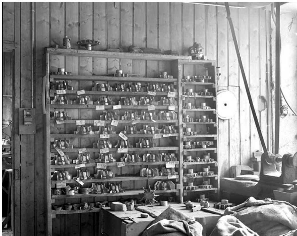
Atelier de mécanique : fraises pour l'ébauchage.
