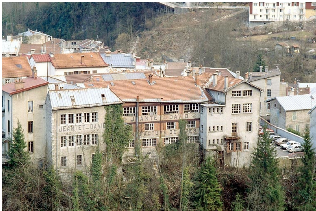
Vue d'ensemble rapprochée depuis l'ouest.
