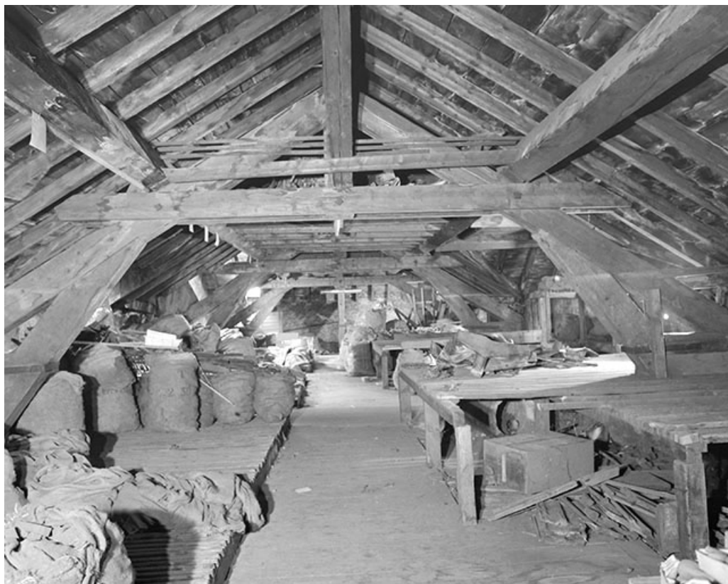
Intérieur d'un séchoir à ébauchons (bâtiment ouest).
