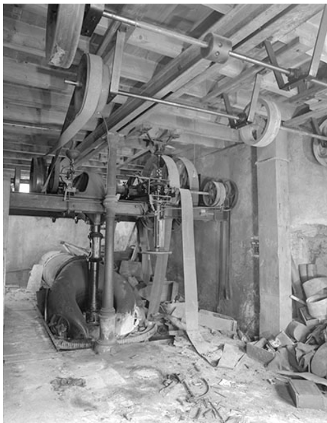
Bâtiment d'eau : bâche de la turbine et transmission.
