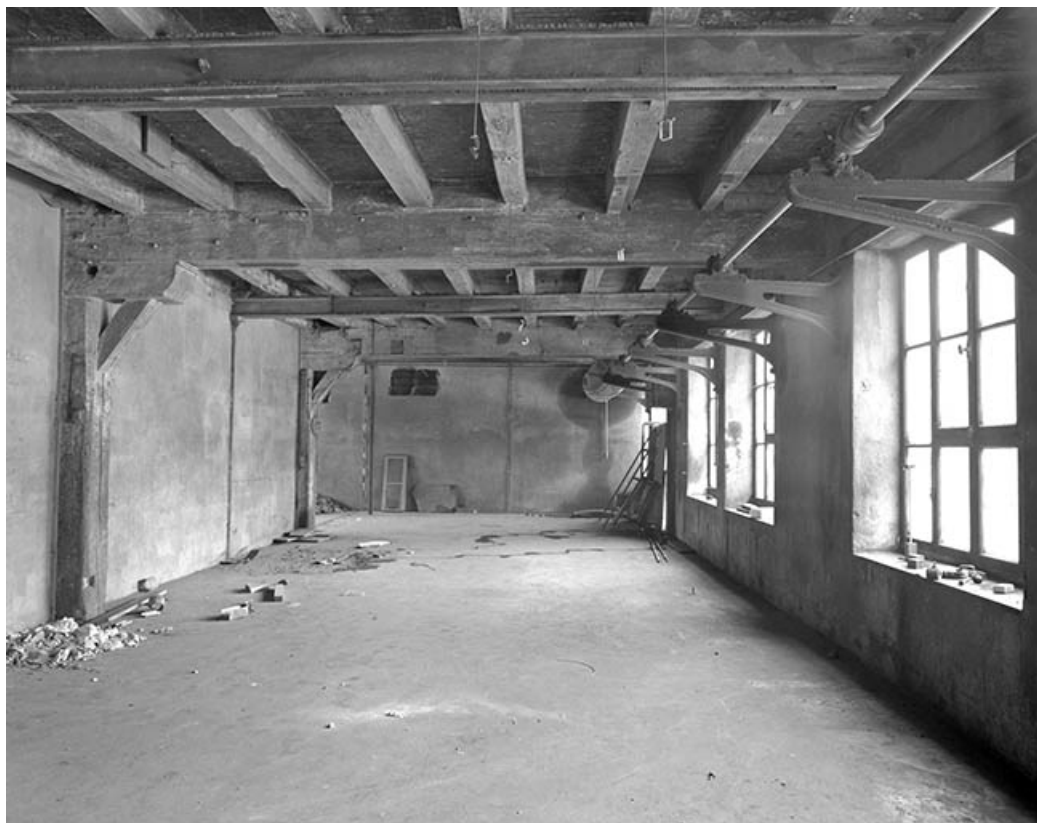
Atelier de fabrication (1er étage) : intérieur d'un atelier.
