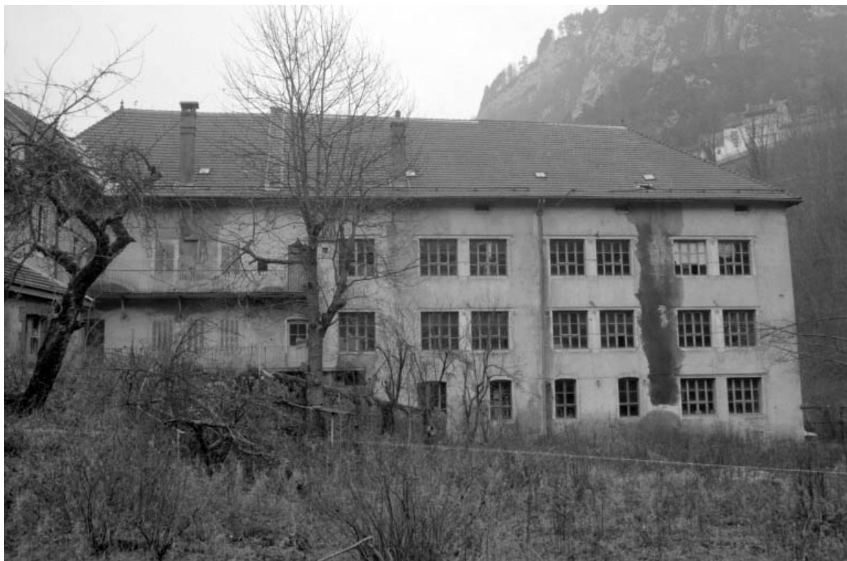
Façade postérieure de l'atelier de fabrication.
