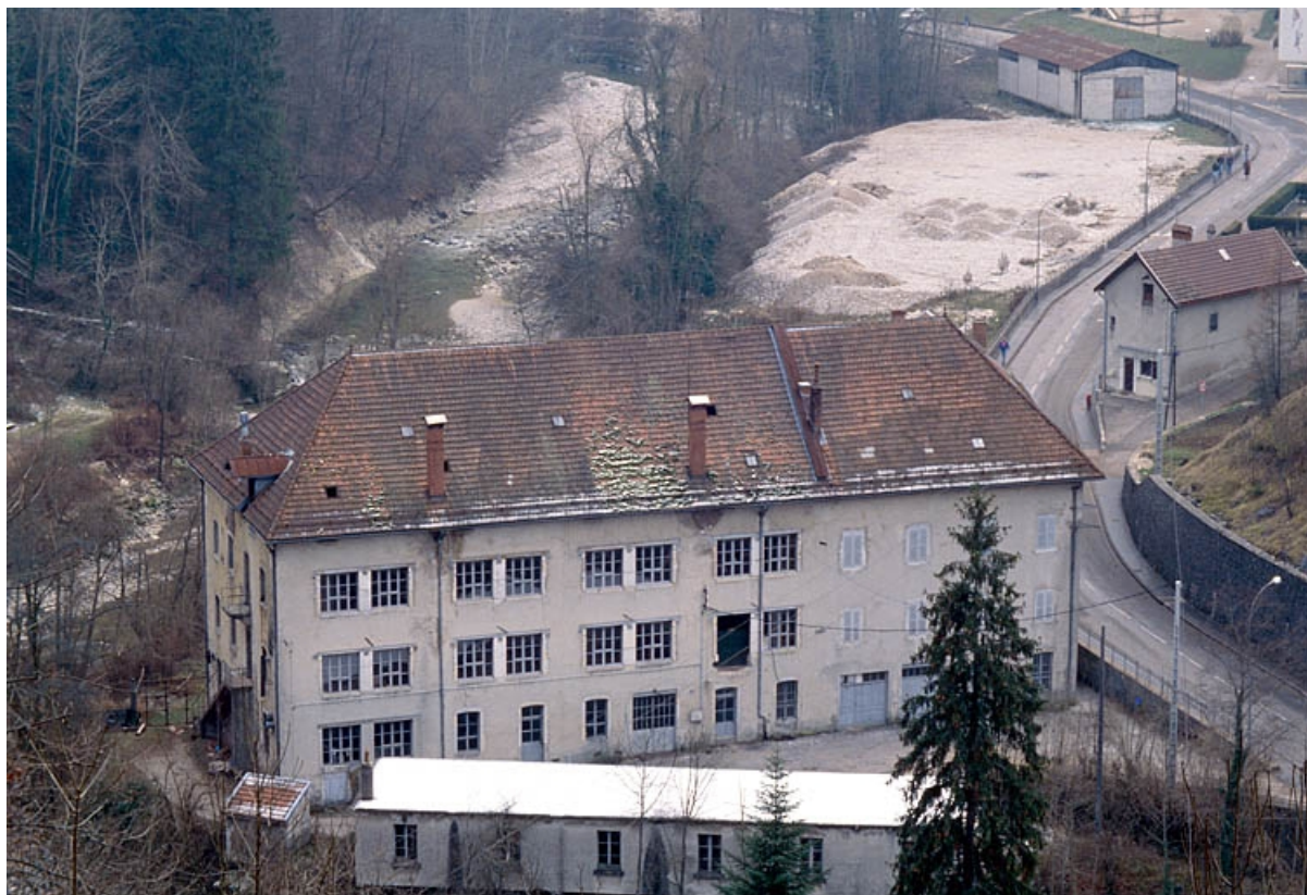
Vue plongeante sur le site, depuis le nord.
