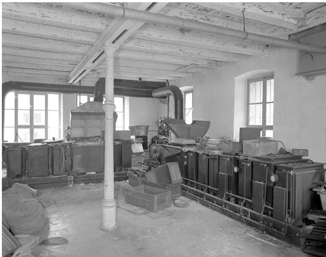
Atelier de fabrication (rez-de-chaussée) : chaîne d'électrolyse.
