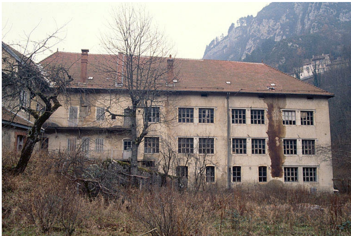
Façade postérieure de l'atelier de fabrication.
