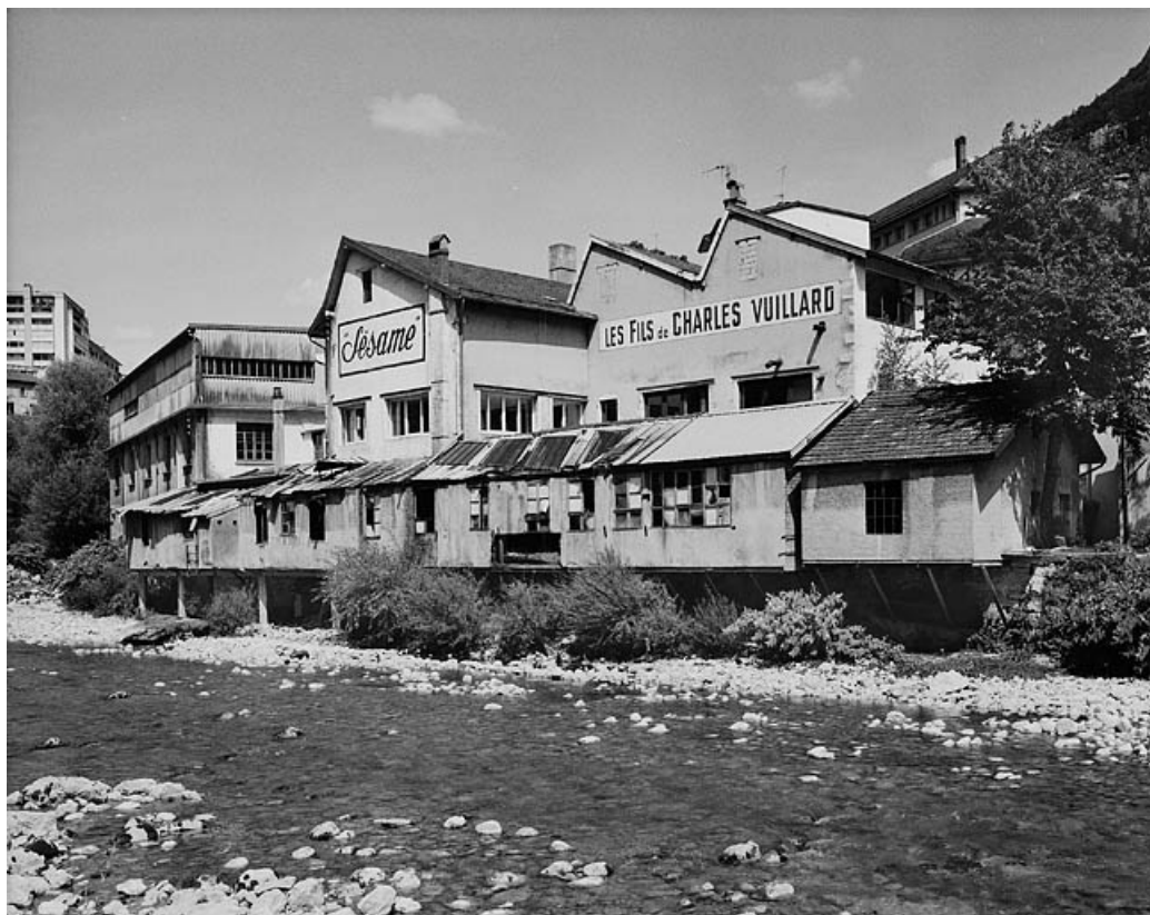
Façade postérieure de trois quarts droite. 39, Saint-Claude, 70, 72, 74 rue de la Poyat
