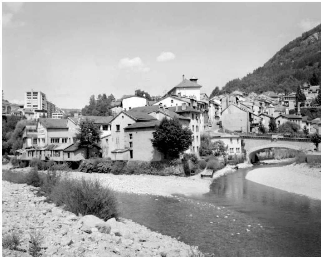
Vue d'ensemble depuis le sud-ouest (au confluent de la Bienne et du Tacon).
