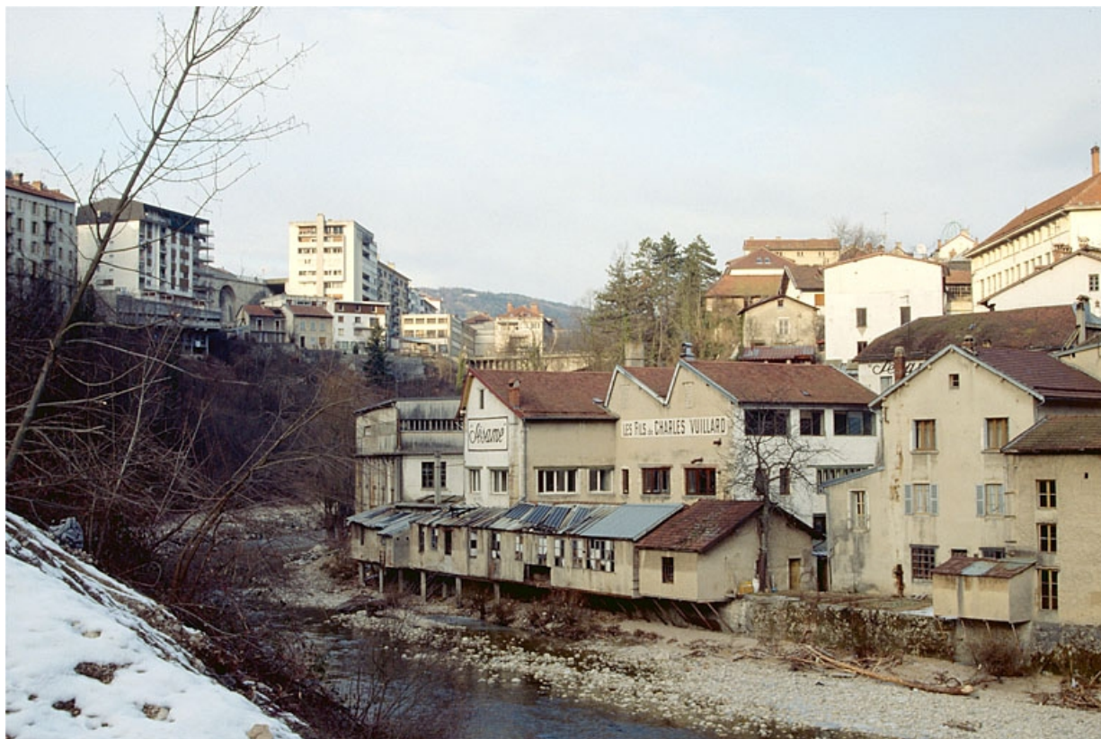
Vue d'ensemble de la façade postérieure (sur la Bienne).
